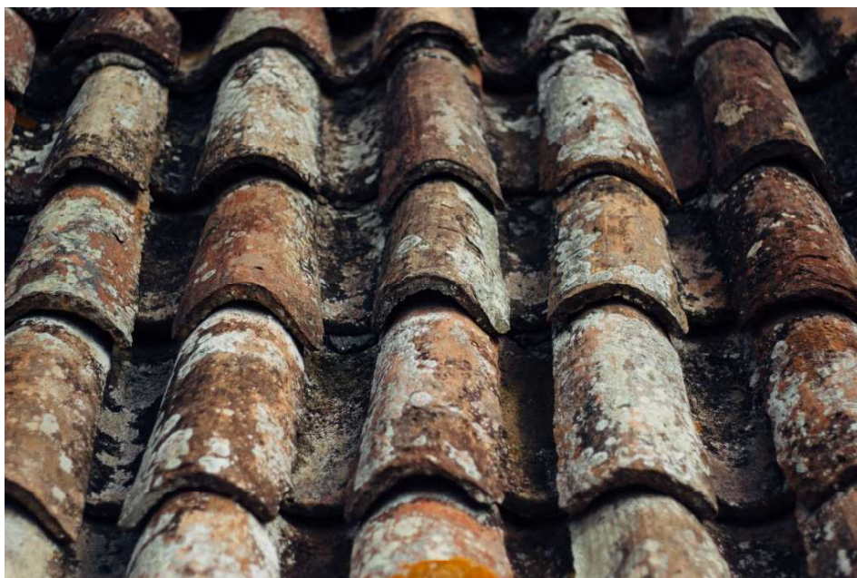
Fig. 3.6 – Toiture en tuiles canal et lait de chaux
