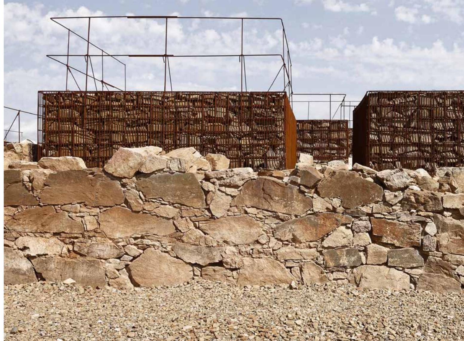
a formare semplici gabbie di armatura estese quanto gli ambienti stessi, ma distaccate dalle preesistenze murarie per non danneggiarle. Il materiale lapideo viene apparecchiato a secco all'interno delle gabbie metalliche per formare un primo perimetro di circa 60 cm di spessore; successivamente le granulometrie più
