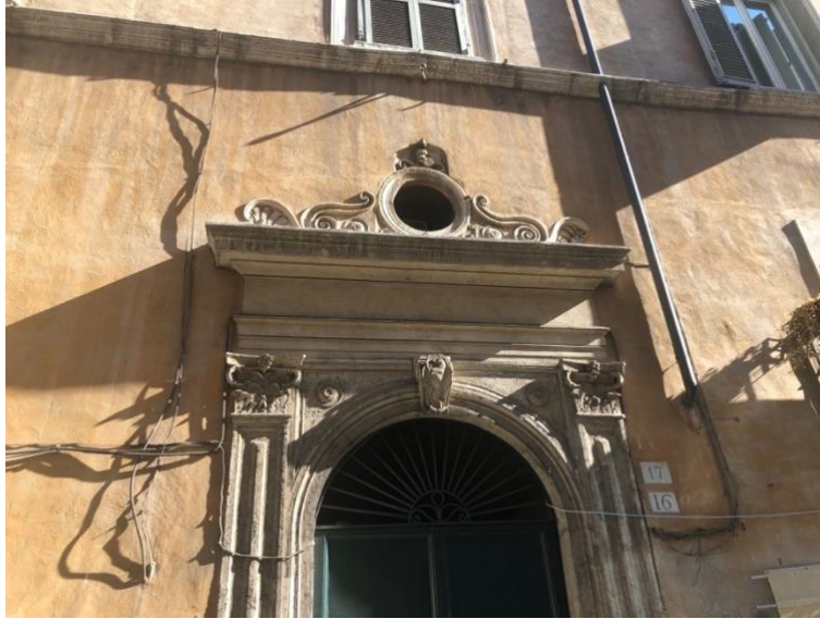
Fig. 18. Palazzo de Cupis a piazza Navona, Roma. Dettaglio del portone di ingresso su via dell'Anima
