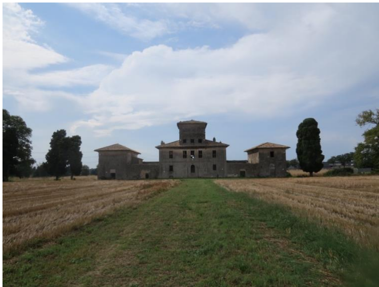
Fig. 15. Edifici di servizio del Triangolo Barberini, Palestrina, Roma
