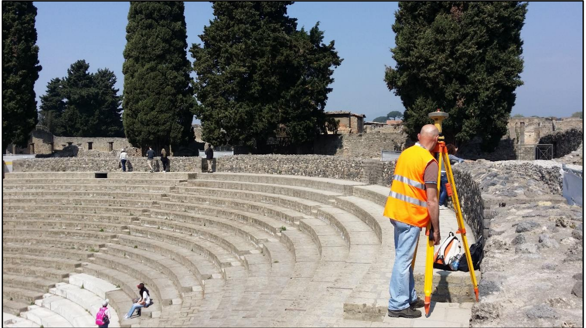
Figura 8.8 - Ricevitor GNSS/GPS in stazione sul vertice Z nel Teatro Grande
