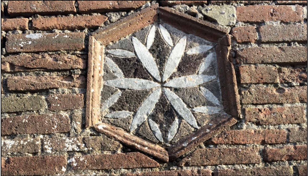
Figura 2.12 - Formella posta su un muro di via dell'Abbondanza
