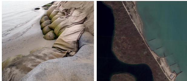
Fig. 18. Coastal erosion barrier in Lido di Spina
