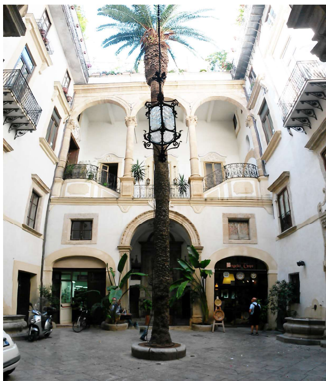
Fig. 1.1 – Cour du Palazzo Castrone
