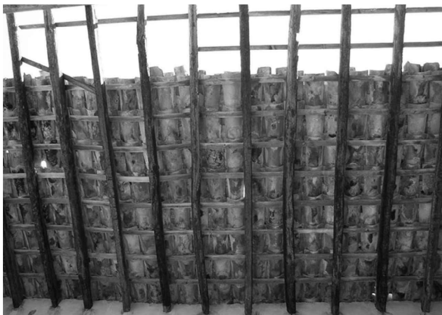
Fig. 2.28 – Les tuiles canal posées sur les solives
