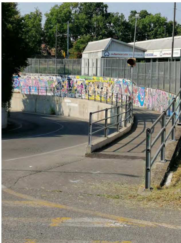
Fig. 14 – Piste ciclabili con murales nell'accesso all'argine del fiume
