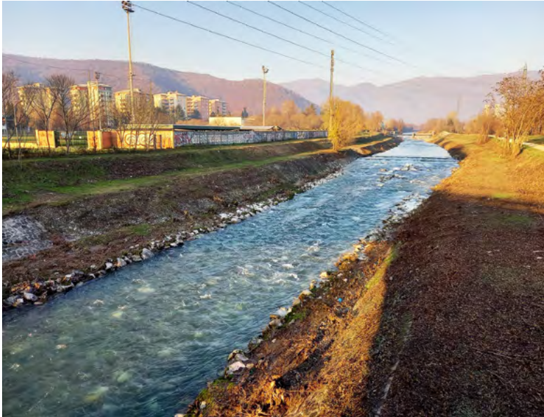
Fig. 15 - Il fiume Mella dal ponte Nuovo
