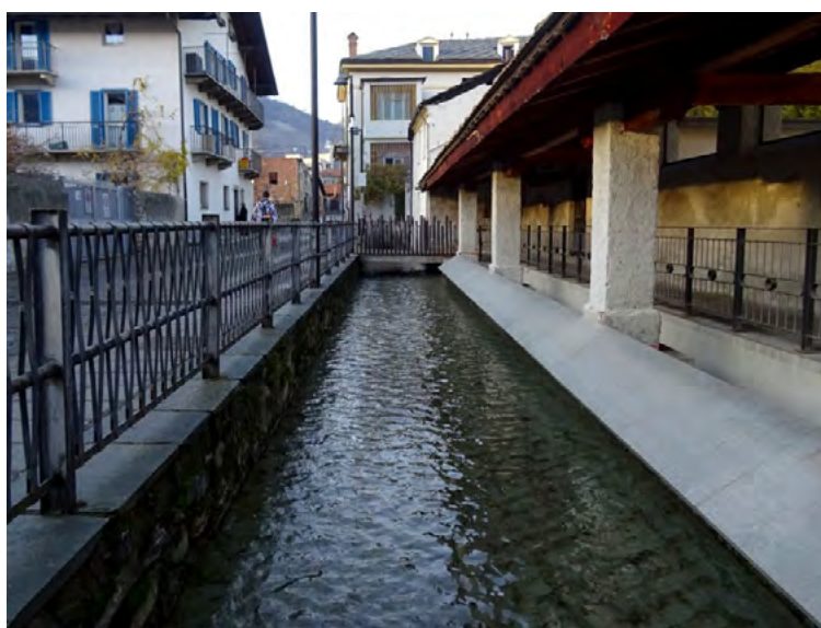
Fig. 23 – Lavatoi di Aosta
