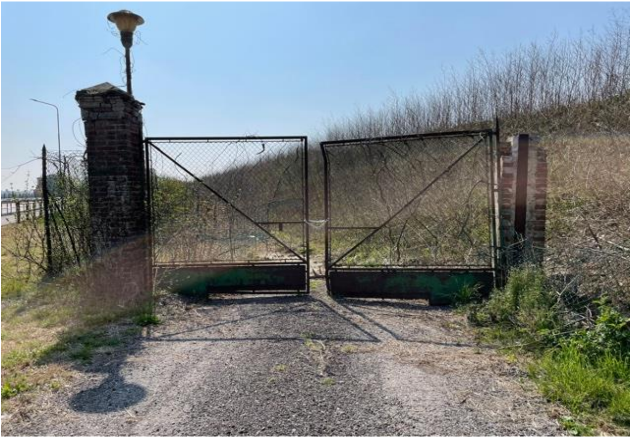
Fig. 6 Ex Zuccherificio - Lo stato di degrado in cui versano gli accessi nella parte nord-est.
