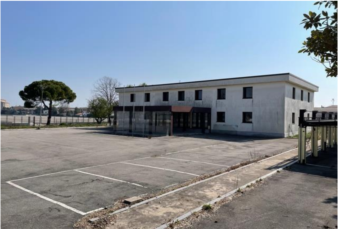
Fig. 2 Ex Zuccherificio - Il fabbricato direzionale del complesso ubicato nella parte est
