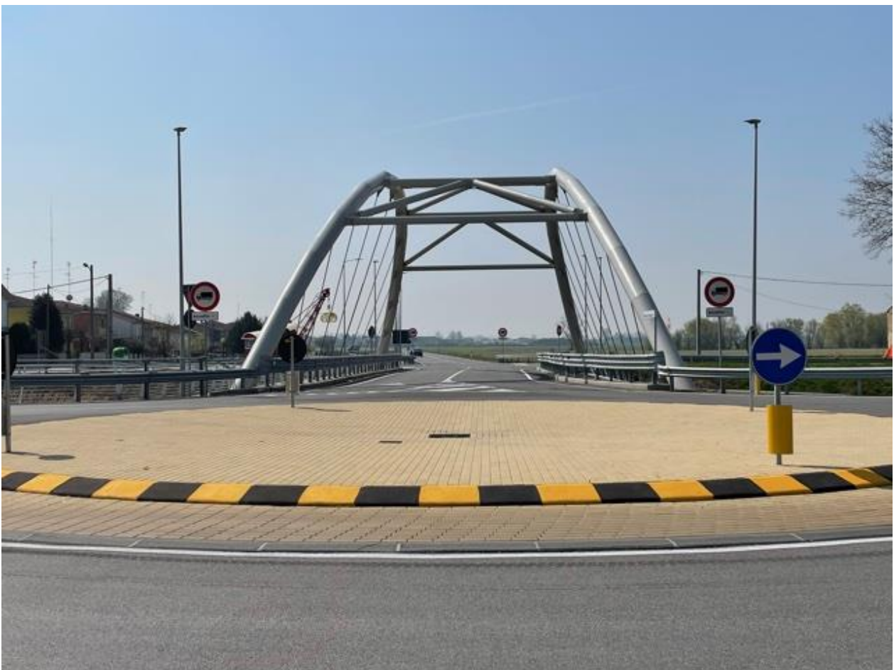
Fig. 7 Borgo Scala - Nuovo ponte sul canale Burana, opera strategica di collegamento extraurbano
