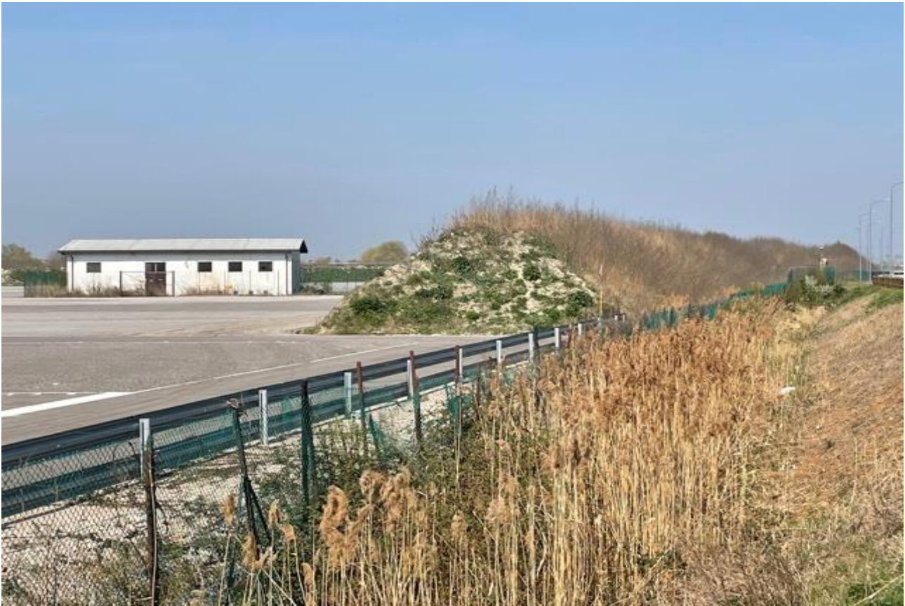
Fig. 4 Ex Zuccherificio - Le arginature delle vasche di decantazione ai margini dell'area
