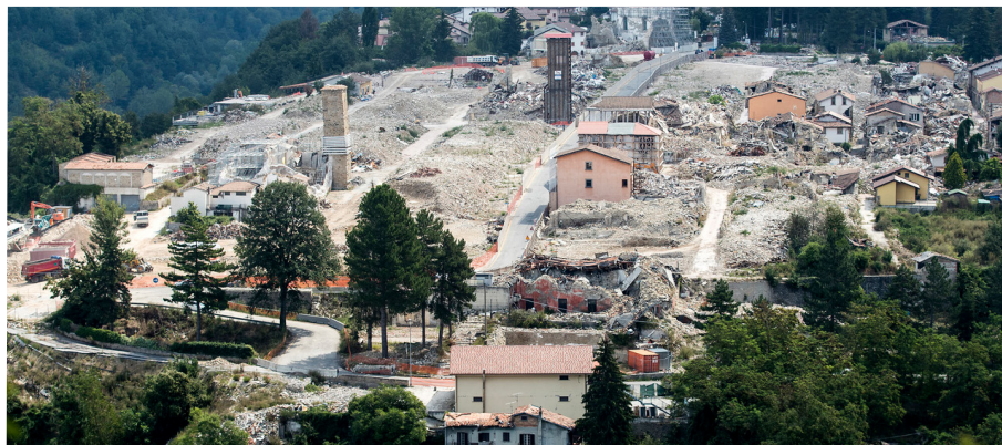
1 Amatrice, veduta dall'alto della "spianata" dopo la rimozione delle macerie e l'indiscriminata demolizione di qualsivoglia traccia del sedime murario delle case.
