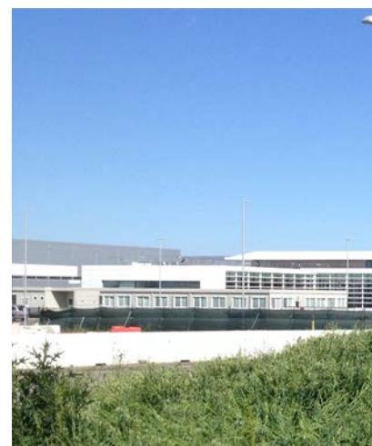
3. Nuovo stabilimento Philip Morris SpA (PM M&TB) a Valsamoggia, Bologna.
