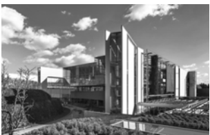
7. Vista dei volumi multipiano degli uffici a ridosso della collina.
