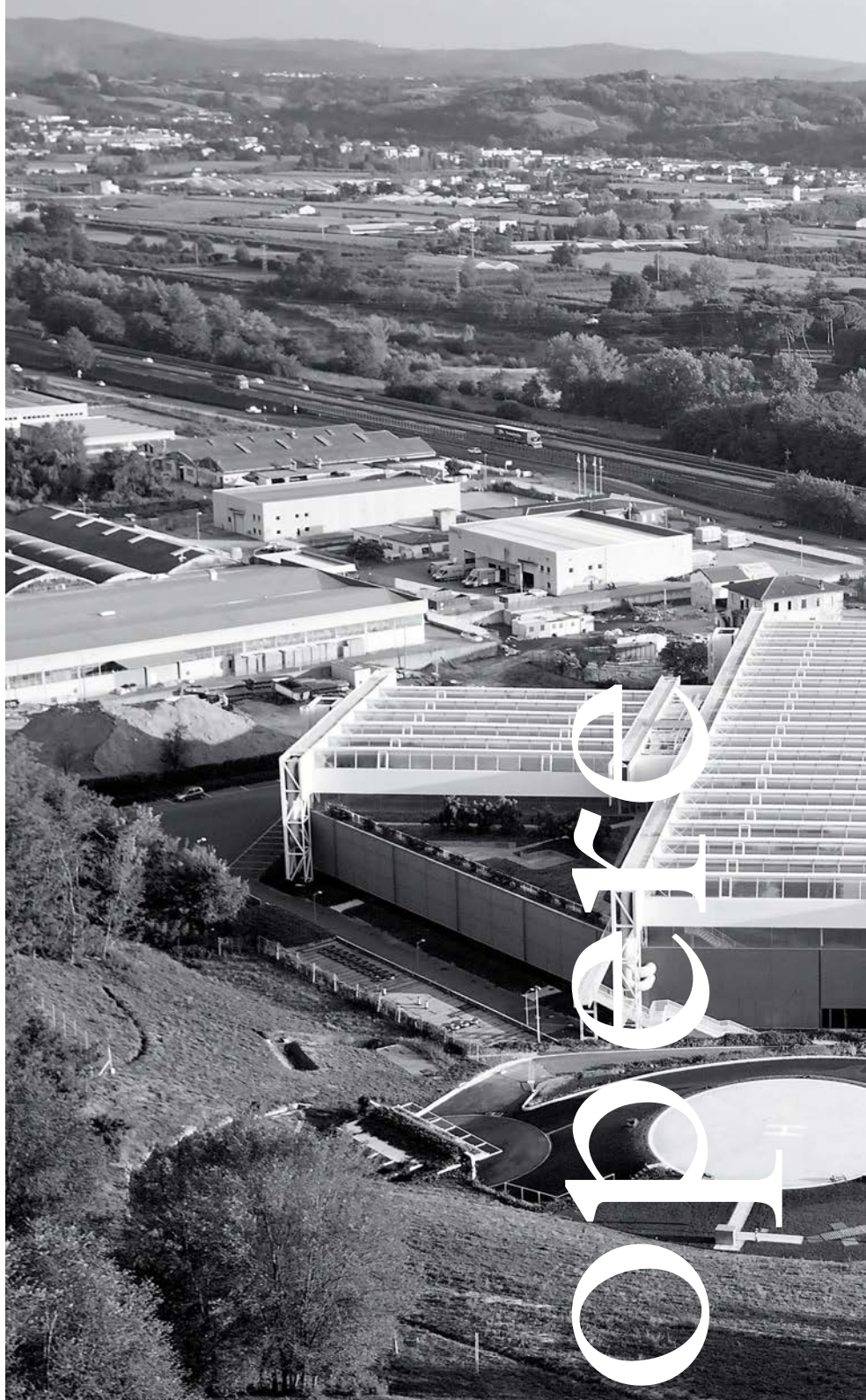
1. Vista dall'alto dello stabilimento.
