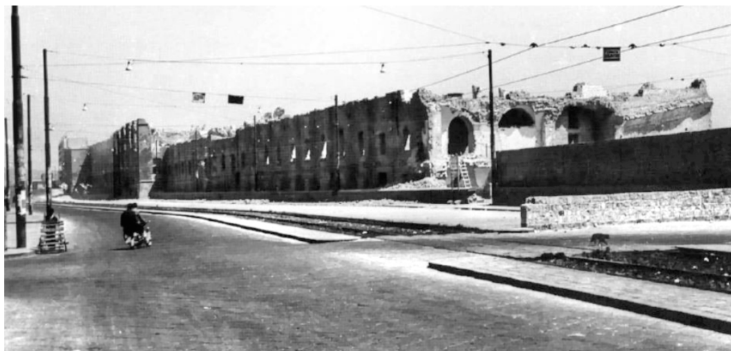
2. La fabbrica dei Granili durante le opere di demolizione del 1953.
