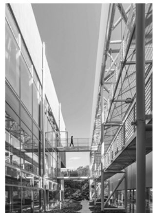
10. Vista delle passerelle esterne che collegano tra loro i volumi.
