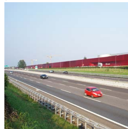
2. Kilometro rosso innovation district, Stezzano-Bergamo.
