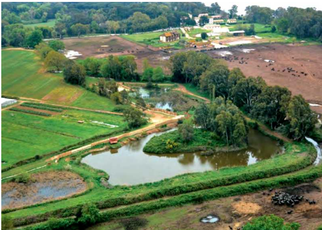
Figura 4 | Impianto di fitodepurazione presso la sede del Parco del Circeo a Fogliano Foto Carlo Perotto
