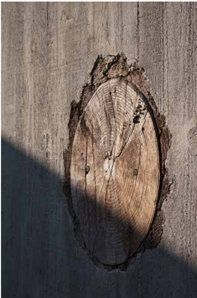
Dettaglio dei dischi di tronco d'abete inseriti nel getto in calcestruzzo armato dei muri della corte, © Wooseop Hwang
