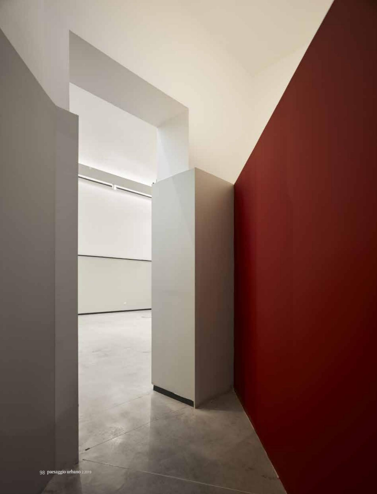
Per le finiture delle contro-pareti si è optato per grasselli o semplici tinteggiature a base di calce scegliendo, previa campionatura, la colorazione e grana delle superfici per garantire una visione complessiva omogenea fra intonaci ripristinati e mantenuti, e nel contempo riconoscere, ad una osservazione ravvicinata, il nuovo intervento.
