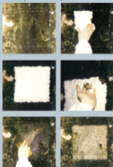
Fasi di un intervento di pulitura mediante impacco a base di polpa di carta; (FEIFFER 1997).
