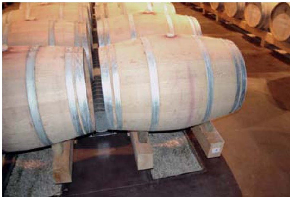
Figura 6.6 Zona di conservazione Fenditure nel solaio a terra per la regolazione dell'umidità interna
