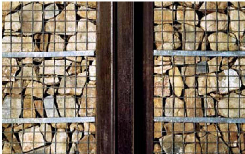
Figura 6.14 Dettaglio del muro di contenimento in gabbioni riempiti di pietrame a secco.
