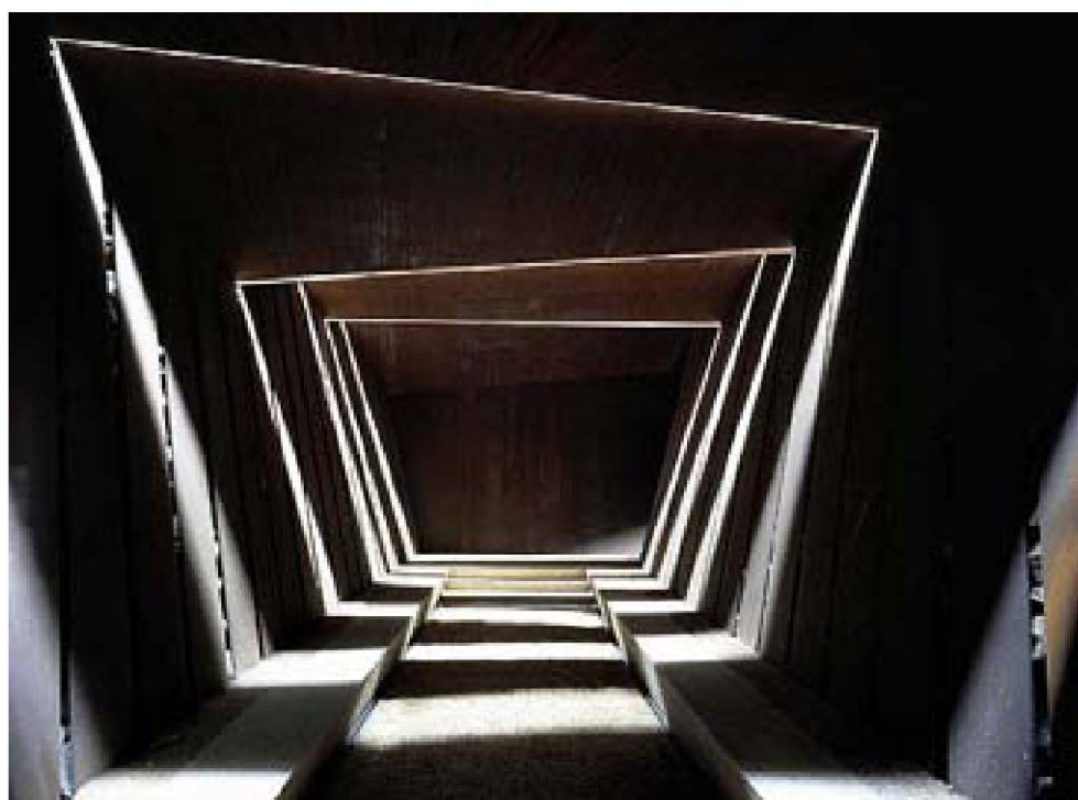
Figura 5.9 Sistema di illuminazione naturale zenitale della sala degustazione
