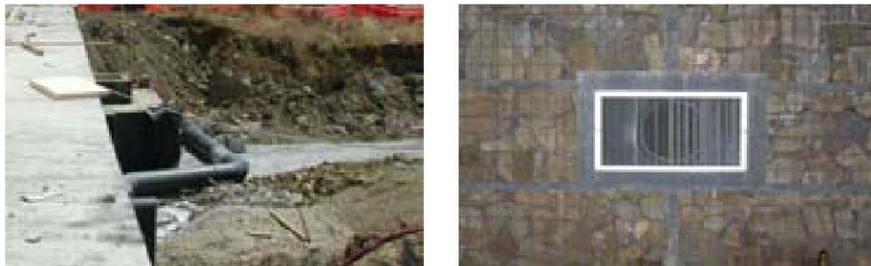
Figure 6.9, 6.10 Condotte di ventilazione naturale
