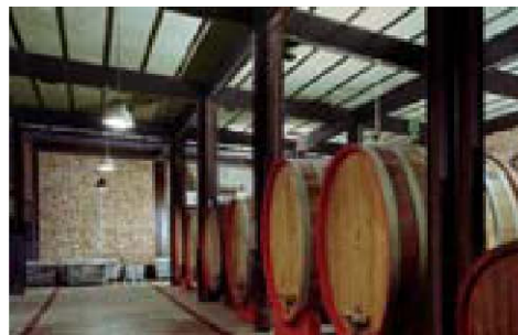
Figure 6.7, 6.8 Impianto di illuminazione artificiale dei reparti di vinificazione e invecchiamento
