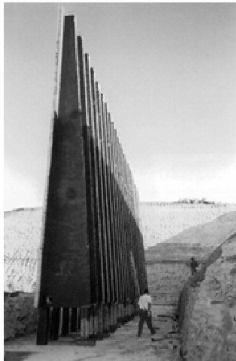
Figura 5.1 Elementi prefabbricati a sperone per il contenimento del terreno.
