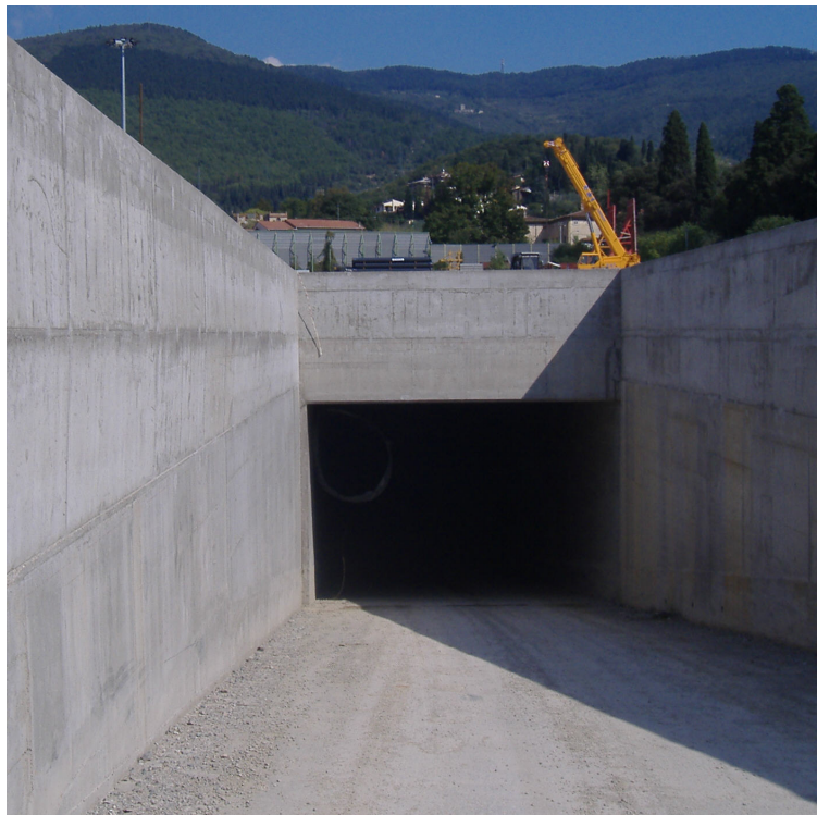
Fig. 4.16 – Cantiere della galleria dell'alta velocità Firenze-Bologna nel 2006 responsabile del segnale C nel Rilievo 1.
