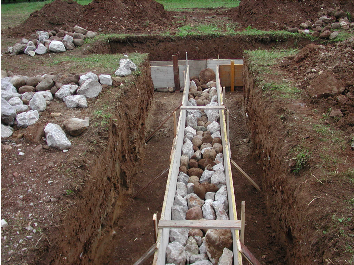
Fig. 3.4 – Muro a secco (n° 1 in Tab. 3.1) durante la realizzazione dell'Area Test di Rovereto (da Finotti 2003).
