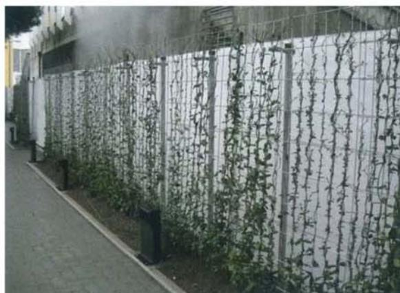
Esempio di applicazione del sistema confina soilless. Si noti come la struttura risulta completamente svincolata tanto dalla muratura, tanto dalla presenza di un substrato terroso da cui far partire il rivestimento vegetale.
