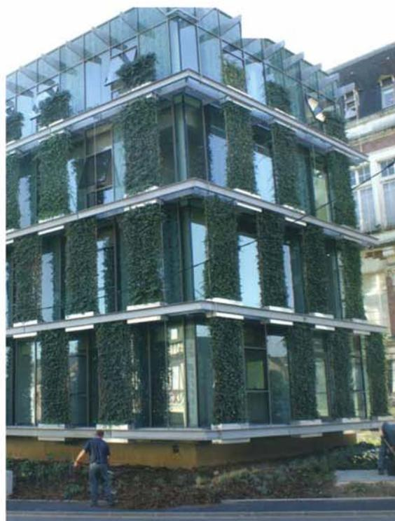
l Esempio di applicazione del sistema confina. Si notino la modularità del prospetto ed il modo in cui le vasche di terreno si integrano grazie al loro ridotto ingombro.
