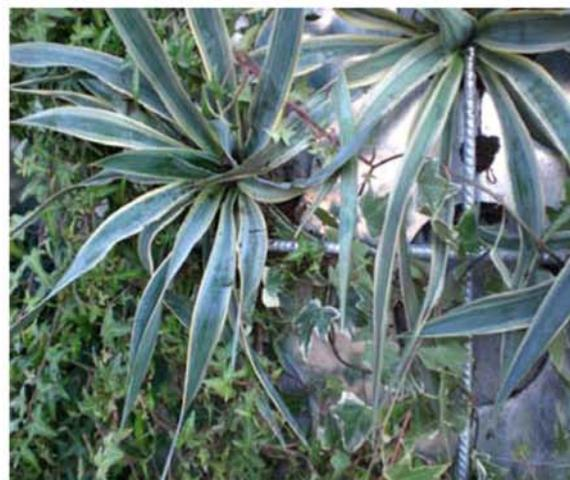
Particolare del sistema Vertical. Bucature sulla superficie dei vasi metallici per consentire l'innesto del manto vegetale e l'utilizzo della griglia metallica per orientare lo sviluppo delle piante a portamento rampicante o strisciante.
