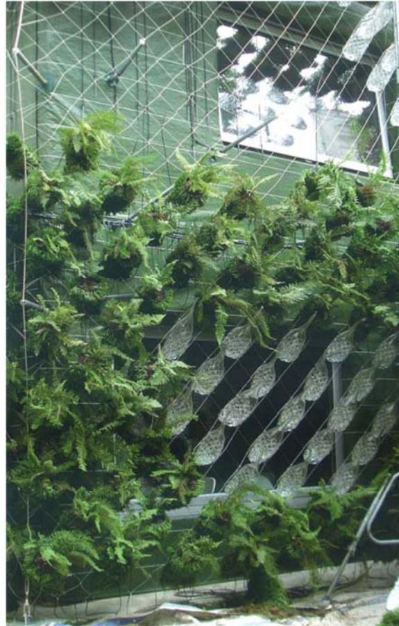
Vista frontale delle felci e delle ampolle vetrate applicate alla rete di facciata, durante le fasi di allestimento dell'involucro, pur essendo ancora piuttosto rado il rivestimento vegetale, l'effetto visivo generato dalla superficie verde di fondo aiuta nel comporre l'effetto di facciata naturale desiderato dai progettisti
