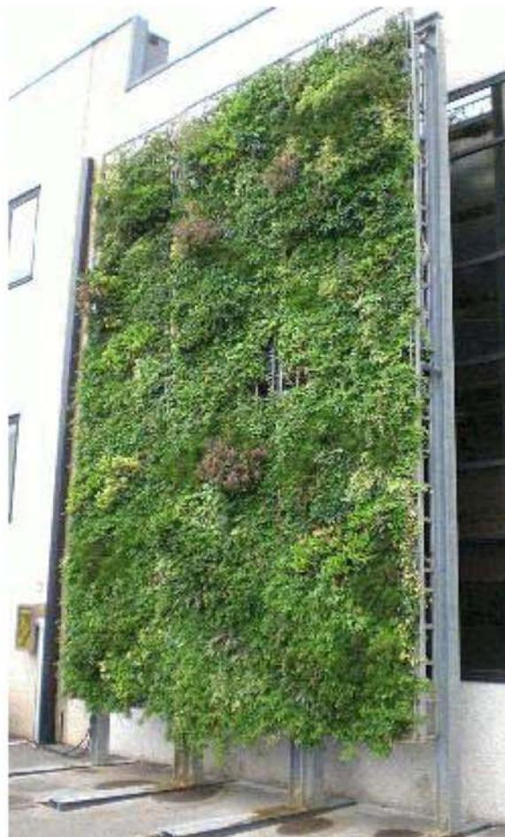
Prototipo di sistema Vertical applicato come schermatura svincolata dalla parete. Si notino le dimensioni importanti del sistema intelaiato necessario al sostegno dei pannelli
