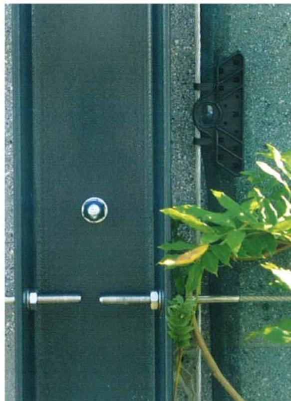
Particolare del sistema montanti e traversi attraverso cui vengono resati i cavi che sostengono la crescita dalle rampicanti in facciata.
