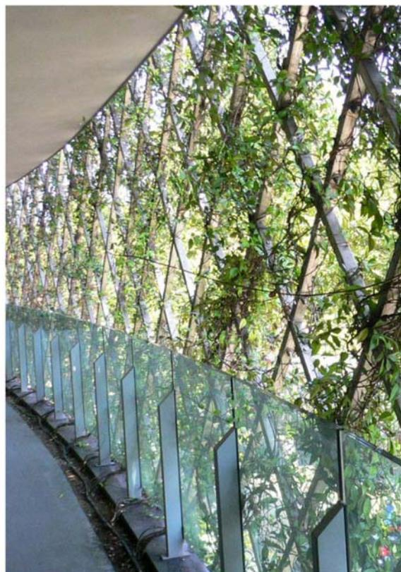
Vista interna dal ballatoio sud-est dell'edificio Ex Ducati, si osservano la capacità schermante della superficie vegetale applicata all'involucro dell'edificio, ed il sistema di vasche posto lungo tutto lo sviluppo del ballatoio per ospitare l'apparato radicale dei gelsomini ed il sistema di irrigazione costituito da una rete di tubi microforati.
