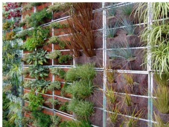
Particolare del sistema a telaio tripartito del pannello Reviwall, l'azienda ha sviluppato una gamma di possibili colorazioni per la geostuoia da utilizzare nelle tasche
