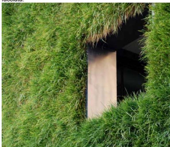
Dettaglio del sistema di facciata composto da moduli in polipropilene contenenti torba e fibre naturali che ospitano un tappeto erboso coltivato sul piano verticale
