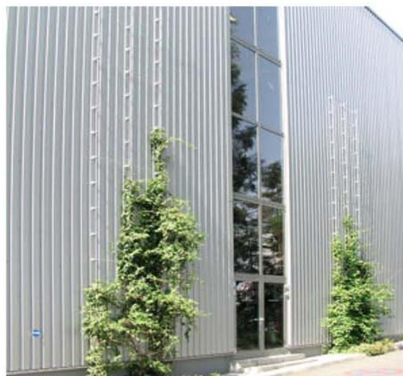
L'applicazione congiunta di cavi e griglie consente una configurazione variabile delle piante che nel caso dei cavi possono formare colonne di volubili, mentre la presenza del grigliato consente la formazione di fronti compatti dei varie specie di rampicanti, in ogni caso però come risulta evidente dall'immagine, l'entità ed i tempi dell'inverdimento sono legati alle caratteristiche naturali delle piante coltivate al suolo
