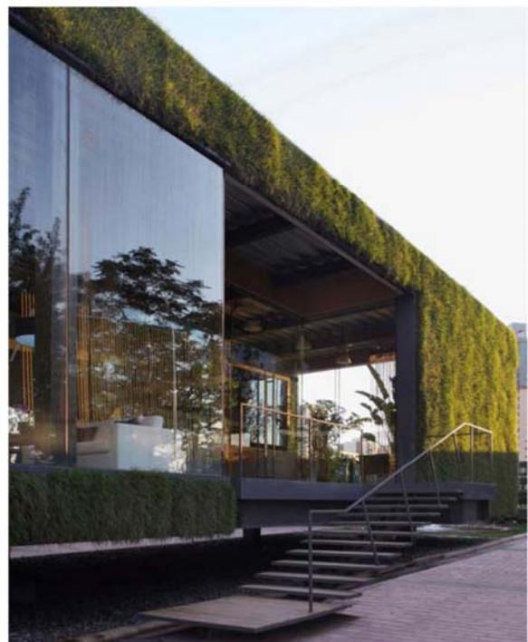
L'edificio presenta una serie di spazi filtro che valorizzano anche attraverso all'integrazione vegetazione coltivata in vaso e giochi d'acqua le caratteristiche di controllo microclimatico offerte dal rivestimento verde dell'involucro.
