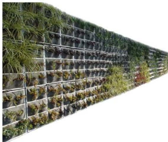
Vista di una parete rivestita tramite il sistema Reviwall. Si noti la grande rigidezza visiva conferita al sistema dalla modularità dei pannelli se confrontati con quelli del brevetto Blanc
