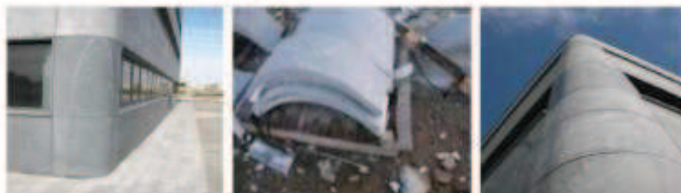
Fig.22 L'uso del tecnico "water-jet" per curvare le lastre di marmo posizionate agli angoli esterni. Fonte: la sede di Italmarble Pocar srl a Massa.
