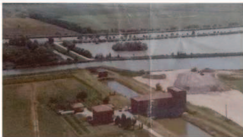
Fig.05 L'impianto idrovoro S.Zagno, fotoscattata dal nord verso sud. Sullo sfondo: le vallate di Ostellato. Fonte: consorzio di bonifica di Ferrara
