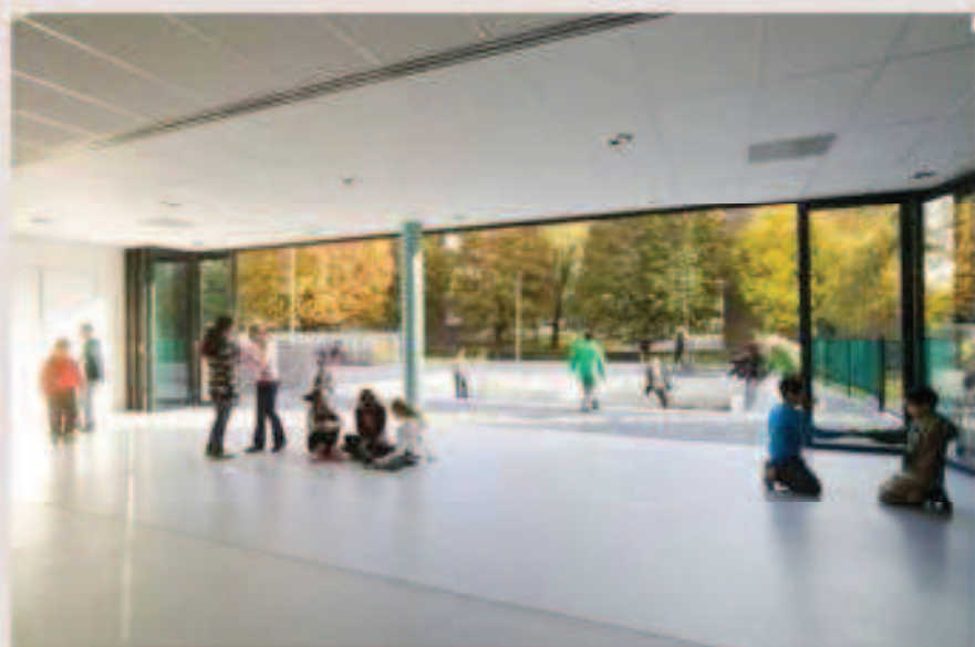
MFC PRESIKHAVEN, ARNHEM, (NL) - HERMAN HERTZBERGER l'aula si apre completamente verso l'esterno attraverso l'uso di pareti trasparenti a libro
