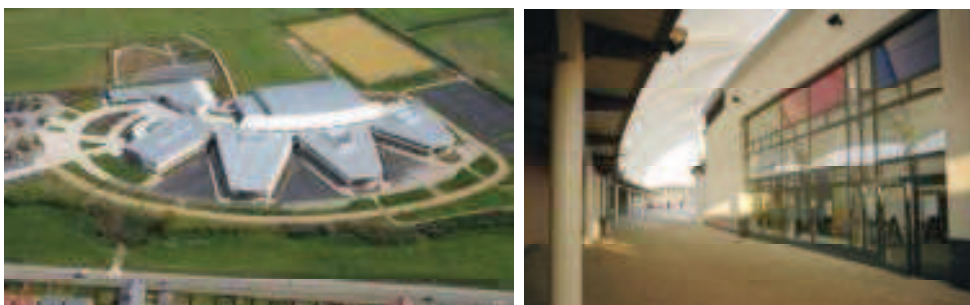
Figura 37 - La scuola Caroline Chisholm (progettisti: Building Design Partnership) è un esempio di progetto sottoposto alla valutazione DQI: incontra le necessità degli utenti ma anche quelle della comunità in cui è inserita (Fonte: CABE)
