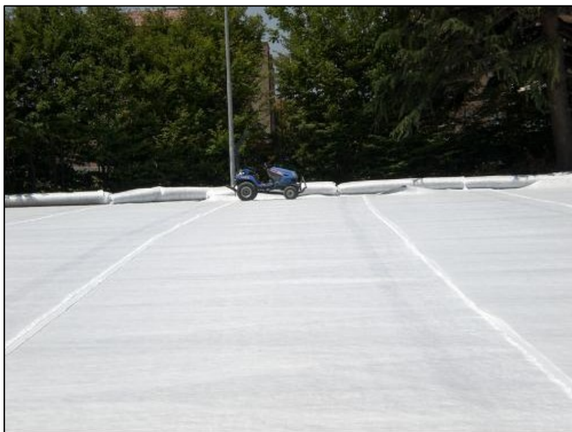
Foto 4.3 - Fase di posa dei rotoli di geodreno
