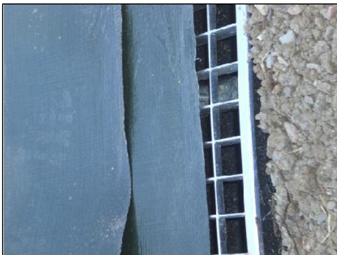
Foto 4.2 - Particolare guaina impermeabile e canaletta di scolo.
