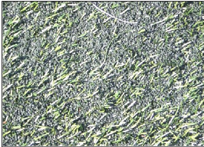
Foto 4.5 - Particolare sull'intasamento a lavori finiti
