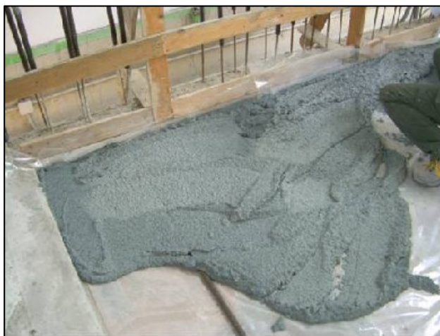
Foto 3.6 – Posa del massetto in cemento sopra lo strato di materiale fonoisolante
