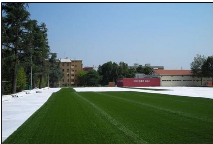
Foto 4.4 - Fase di posa dei rotoli di erba sintetica
