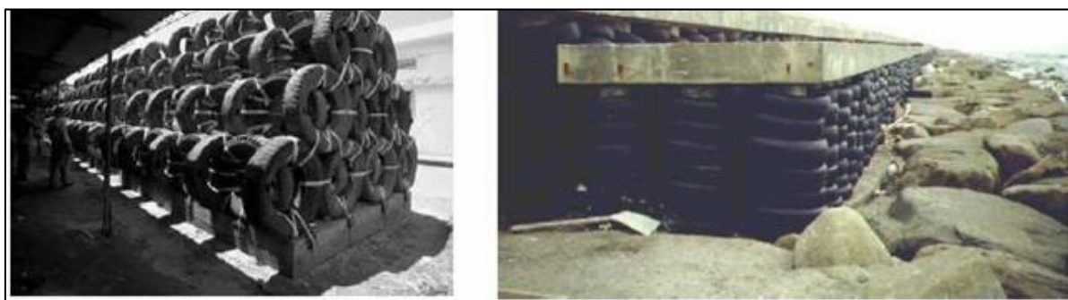
Foto 2.3 – Applicazioni del PFU come barriere artificiali
