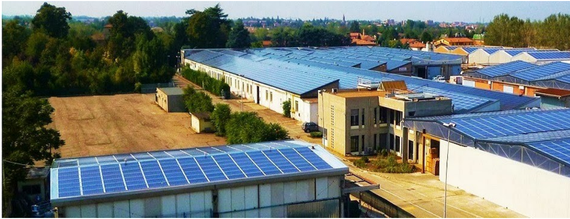
Figura 1.4 Il più grande impianto industriale integrato in Italia: 35 capannoni della Valuepart Europe S.p.A di Castelvetro di Modena con copertura costituita da pannelli fotovoltaici integrati, per un totale di 3.5 MWp di potenza nominale installata. L'impianto è stato riconosciuto tra le "applicazioni innovative finalizzate all'integrazione architettonica del fotovoltaico" definite dal 5° Conto Energia.
