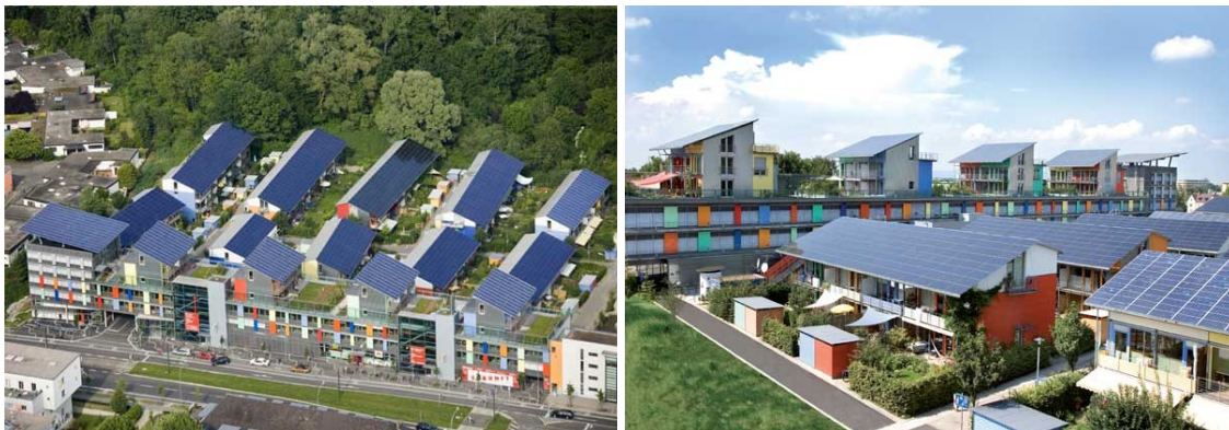
Figura 1.2 Quartiere residenziale Vauban di Friburgo nel sud della Germania. Le coperture, rivolte verso sud, sono interamente rivestite da pannelli fotovoltaici. La tecnologia utilizzata è quella dei pannelli semitrasparenti in cui le celle policristalline sono laminate tra due lastre di vetro [4].
