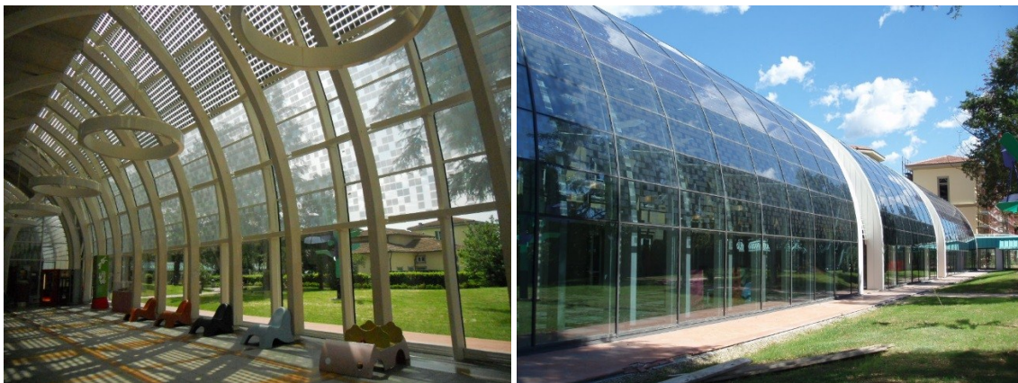
Figura 1.3 Serra fotovoltaica dell'Ospedale Pediatrico Meyer di Firenze. L'impianto è composto da 181 moduli fotovoltaici realizzati con vetrocamera di diverse dimensioni. La potenza nominale complessiva è di 32 kWp.
