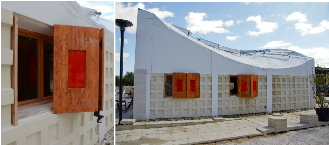
Figura 3.1 Le finestre solari integrate in Astonyshine. Le dimensioni di ciascuna finestra sono 150 x 60 cm.
