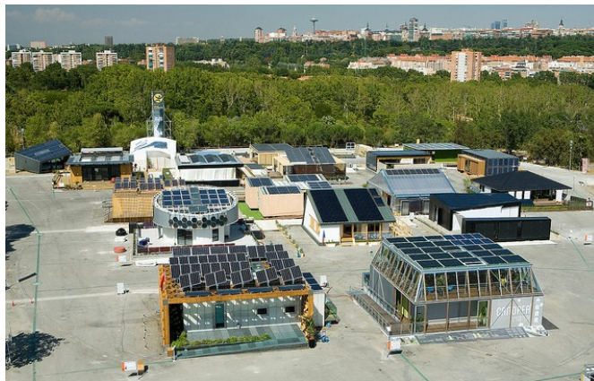
Figura 2.66 Le 18 case in gara presso Villa Solar, Madrid, durante il Solar Decathlon Europe 2012.
