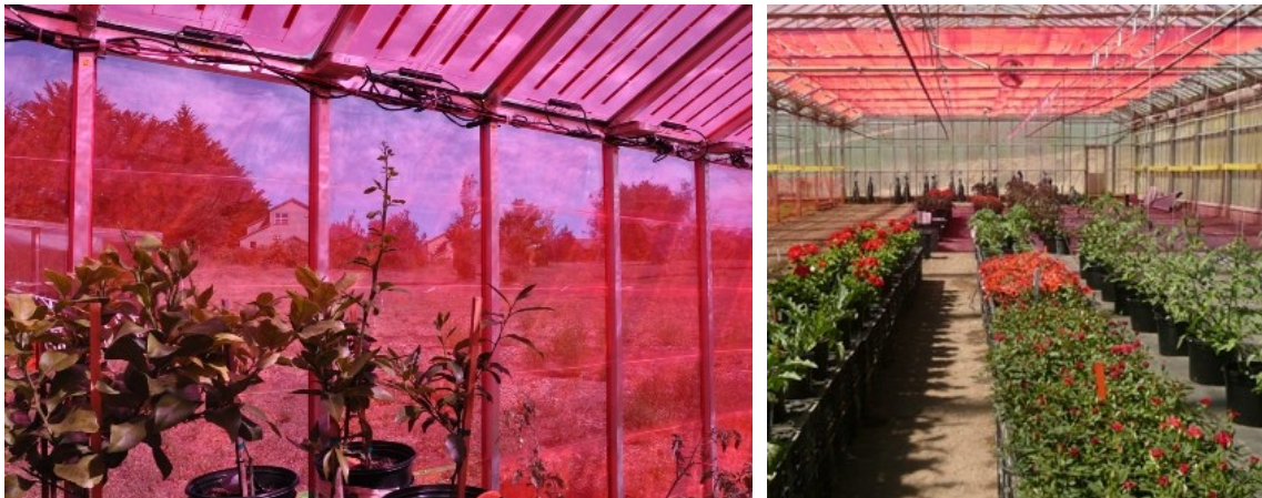
Figura 1.22 Serra con pannelli LSC realizzata presso l'Università della California, Santa Cruz.
