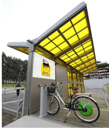
Figura 1.23 Pensilina fotovoltaica ENI inaugurata a Roma il 27 novembre 2012.
