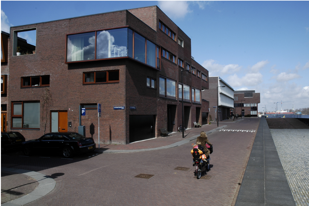
Figura 16 Borneo island, Amsterdam, Olanda. prog: WEST 8. La sede stradale viene configurata come woonerf, in continuità fisica e percettiva con gli spazi pedonali, migliorando la sicurezza degli utenti deboli come ciclisti e pedoni.
