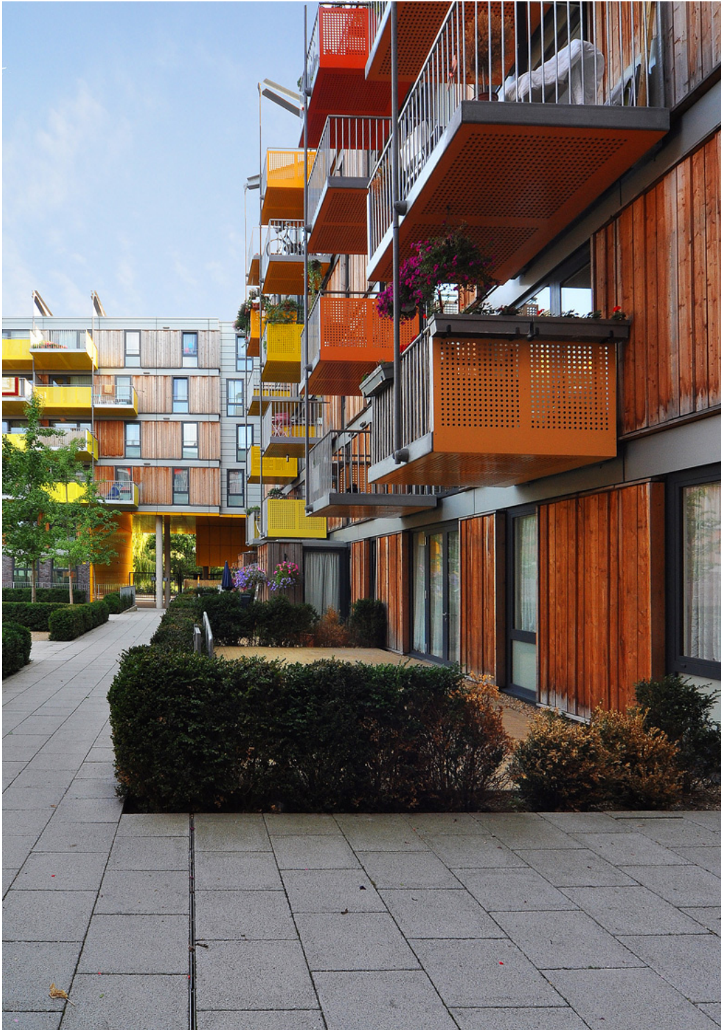
Figura 5 Le facciate interne alla corte sono caratterizzate dai balconi metallici, utilizzati come estensione delle zone giorno.
