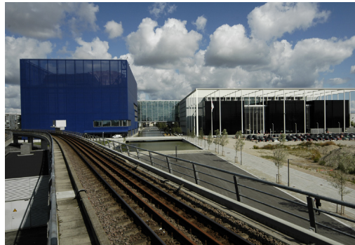
Figura 5 Orestad, Copenha- gen, Danimarca. prog: ARKKI, KHR arkitekter, A/S, Daniel Liebeskind. La strategia insediativa applicata dalla città di Copenhagen per le nuove espansioni prevede l'utilizzo della linea di metropolitana come in- frastruttura traspostistica principale.
