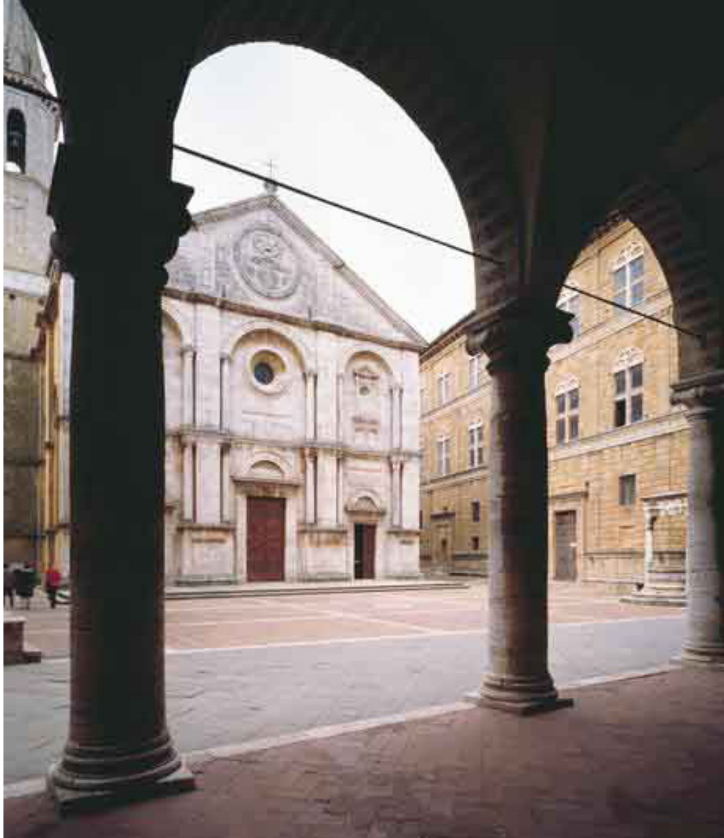
Figura 11 Pienza, lo spazio pubblico di matrice storica. La configurazione spaziale dell'ambito urbano mette in relazione diretta gli edifici che sintetizzano il potere temporale e secolare. Foto: @ apertoperrestauro.siena.it
