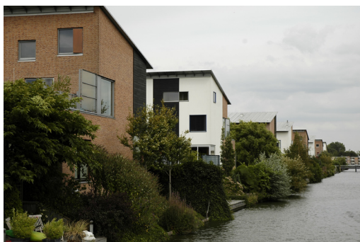
Figura 3 Floriande, Hofddorp, Olanda, 2000-2009, prog: Van Tilburg, H+N+S. La progettazione paesaggistica ha tenuto conto degli elementi naturali, anche se di natura artificiale nella definizione degli spazi aperti ed in relazione alle nuove infrastrutture.
