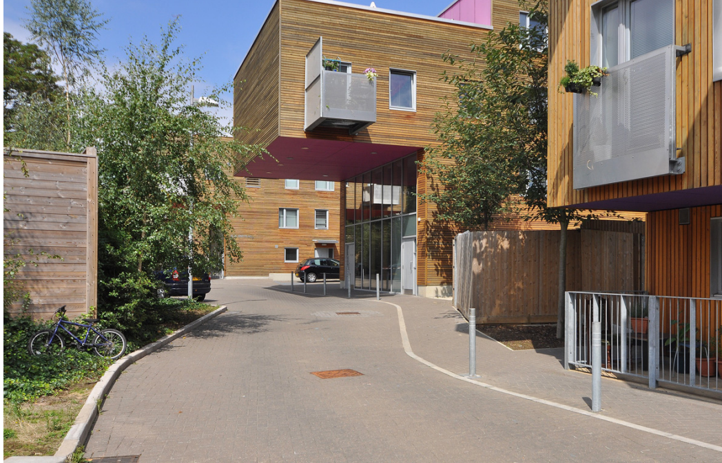
Figura 2 Elementi aggettanti sulla strada carrabile contribuiscono all'immagine innovativa del progetto.
