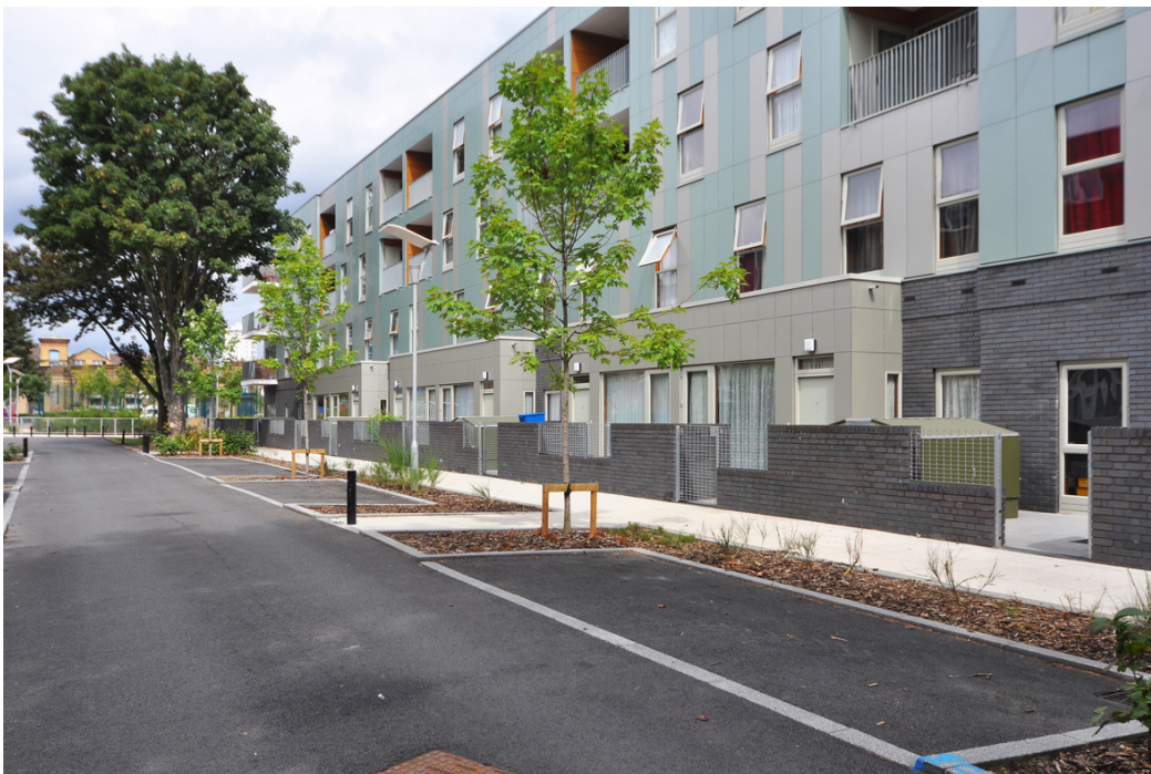
Figura 6 L'attenta progettazione del livello zero, permette la definizione gerarchica degli spazi, coerentemente alle richieste dei protocolli Home Zone.
