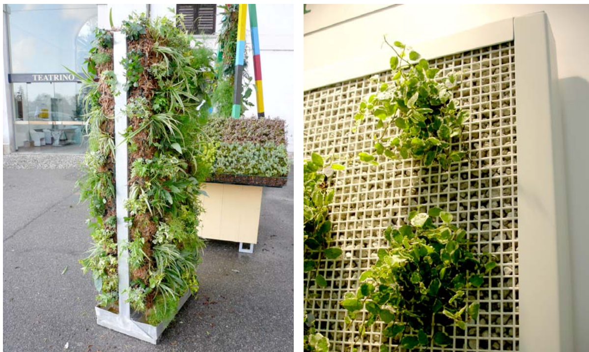
Fig.V.63 – A sinistra. Esempio di sistema a strati continui: Giardini Verticali Sfagno , commercializzato dall’azienda Antologia (modulo dimostrativo). Il sistema è composto da gabbioni metallici modulari contenenti un substrato in sfagno.
