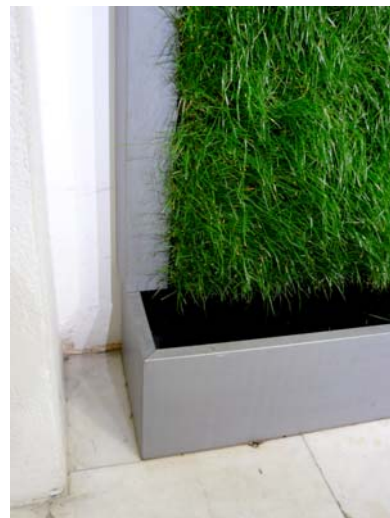
Fig.V.52 – A sinistra: BioTecture Ltd, Anthropologie Store , Londra, 2009. Muro vegetale indoor : nella parte alta dell’installazione è presente l’impianto d’illuminazione per fornire artificialmente alle piante la luce di cui necessitano, mentre sulla destra è visibile l’elemento di connessione verticale tra la chiusura pre-esistente e il sistema d’inverdimento. (Fonte: Valeria M. Rocco)
