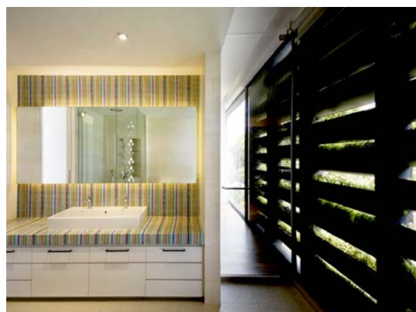
Fig.III.91 – Formwerkz Architects, Maximum Garden House , Singapore, 2010. Al secondo piano, in corrispondenza della camera padronale, è presente una facciata a verde finalizzata alla schermatura solare. Tale frangisole, posizionato davanti ad una grande chiusura trasparente ubicata nel bagno (foto di destra), è ottenuto mediante fiorire equidistanti in altezza e contenenti specie decombenti. (Fonte: http://www.archdaily.com )
