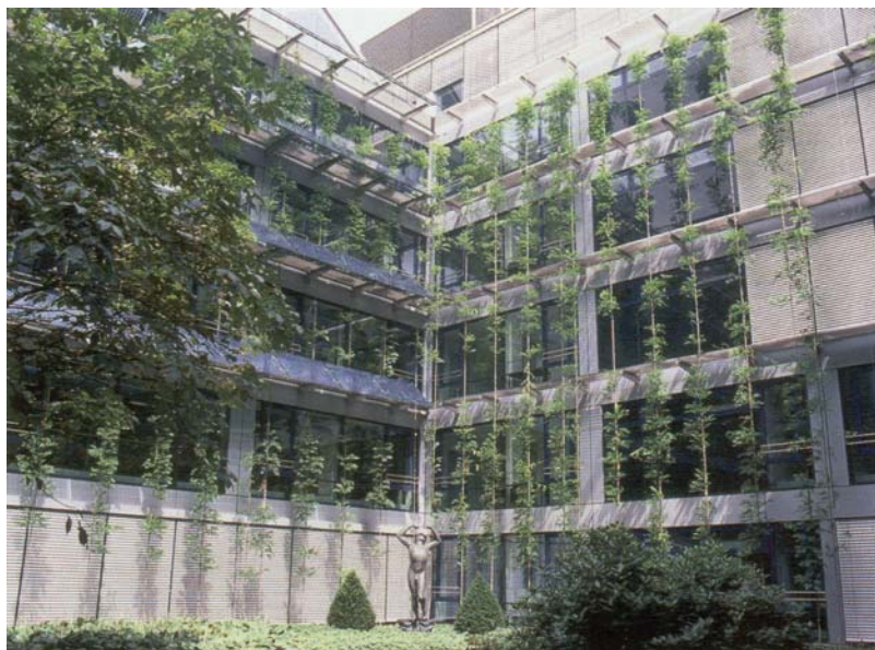
Fig.VI.11 – A sinistra: M. Ludwig e H. N. Schneider, Asilo nido, Winnenden (Germania), 1995. Esempio di schermatura solare ottenuta con specie rampicanti che si svilupperanno principalmente in orizzontale (Fonte: TUCCI, FABRIZIO, “Sistemi tecnologici per la schermatura bioclimatica dall’irraggiamento solare”, p.242).
