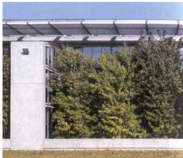
Fig.VI.13 – Christian Hauvette, Centro di ricerca e Scuola di Ingegneria, Clermont-Ferrand (F). La vegetazione arborea caduciflora a ridosso delle facciate permette di ottenere una protezione solare durante le stagioni calde, per le chiusure esposte all’irraggiamento diretto. Le due fotografie rappresentano il medesimo edificio: a sinistra in inverno, a destra durante il periodo estivo. (Fonte: MINGUZZI, GIANLUCA, Architettura sostenibile – Una scelta responsabile per uno sviluppo equilibrato , in bibl., p.66)
