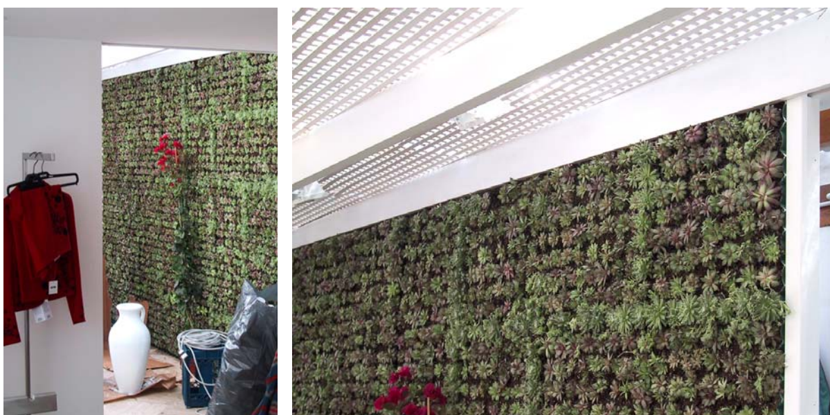
Fig.V.57 – Studio Bay, Moschino Store , Capri (NA), 2001. Installazione a verde eseguita artigianalmente: a supporto del sistema vegetale si sono utilizzati dei pannelli a base polimerica delle dimensioni di 50x50 cm (solitamente impiegati nelle opere di terra armata), mentre lo strato a verde monospecie (prevegetato in vivaio) è composto da piante del genere Sempervivum tectorum , appartenenti alla famiglia delle Crassulaceae . L'installazione risulta particolarmente interessante perché le specie impiegate, essendo geneticamente adattate ai climi aridi, non necessitano di un grande quantitativo idrico. La parete non presenta infatti alcun impianto d'irrigazione automatizzato: l'apporto idrico avviene manualmente, impiegando quando necessario un semplice nebulizzatore manuale a spruzzo. (Fonte: Marco Bay)
