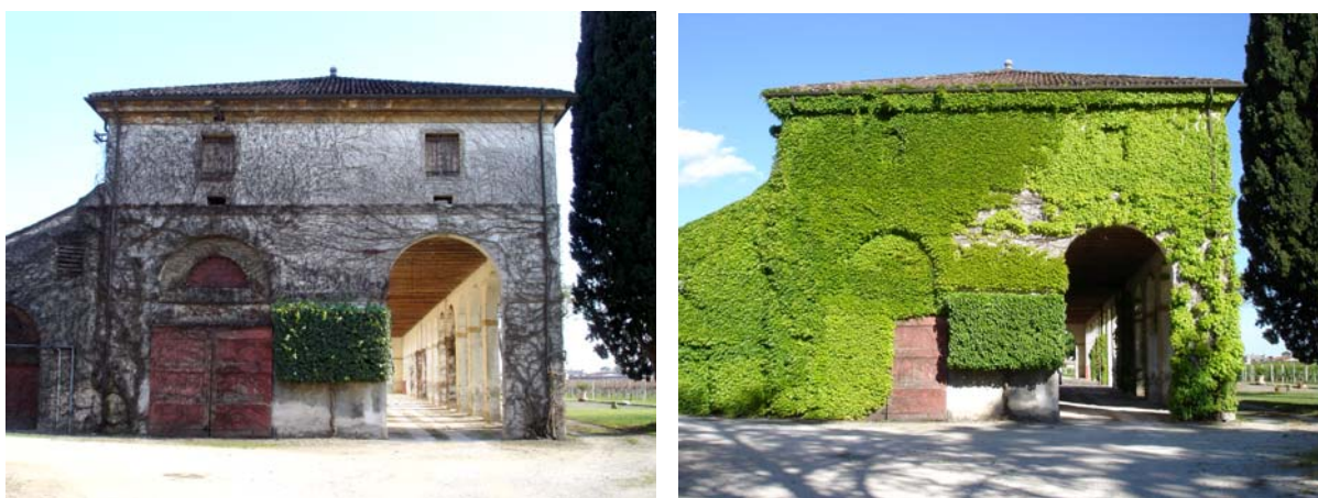
Fig.VI.18 – Confronto tra due fotografie dello stesso edificio nelle configurazioni invernale (a sinistra, scatto eseguito in data 16/01/2010) ed estiva (30/05/2010, a destra). È comprensibile come durante l'inverno gli esili rami della pianta decidua non costituiscano un'ostruzione all'acquisizione solare passiva, mentre a destra, in estate, proprio quando il soleggiamento potrebbe rivelarsi un problema per la gestione bioclimatica del manufatto, le foglie possono fungere da schermatura solare.
