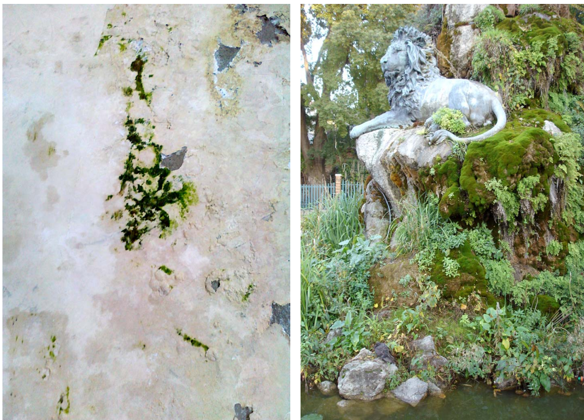
Fig.IV.9 – A sinistra. Cattedrale romanica di Aquileia (UD), 2010. Il muschio (appartenente alla famiglia delle briofite ) è una pianta particolarmente portata alla colonizzazione primaria: i muschi sopportano bene luoghi umidi e scarsamente illuminati, quindi sono anche identificabili come piante sciafile. La specie muscinale ritratta nella foto ha preso avvio da una macchia d’umidità sulla superficie muraria interna alla chiesa.
