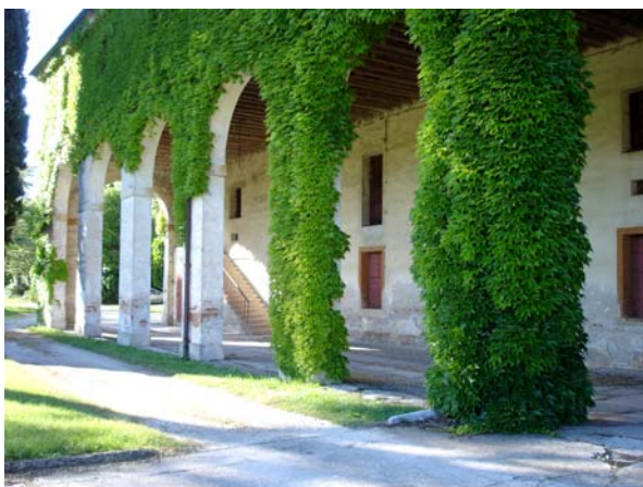
Fig.III.28 – A sinistra. I rampicanti presentano uno spessore vegetale maggiore in prossimità del fusto, mentre tendono a diradarsi nelle propaggini più distanti da esso. Si noti come in prossimità del pilastro in primo piano (che ospita il fusto della pianta) lo spessore del rivestimento sia molto consistente, mentre nei punti più distanti l'FHT diventi più esiguo. Se in prossimità del fusto lo spessore vegetale è stimabile nell'ordine dei 30-40 cm, esso cala fino ai 15-20 cm sul pilastro in secondo piano, per diminuire ulteriormente all'aumentare della distanza dal punto d'impianto. La specie vegetale in questione è una Parthenocissus tricuspidata (vite vergine).
