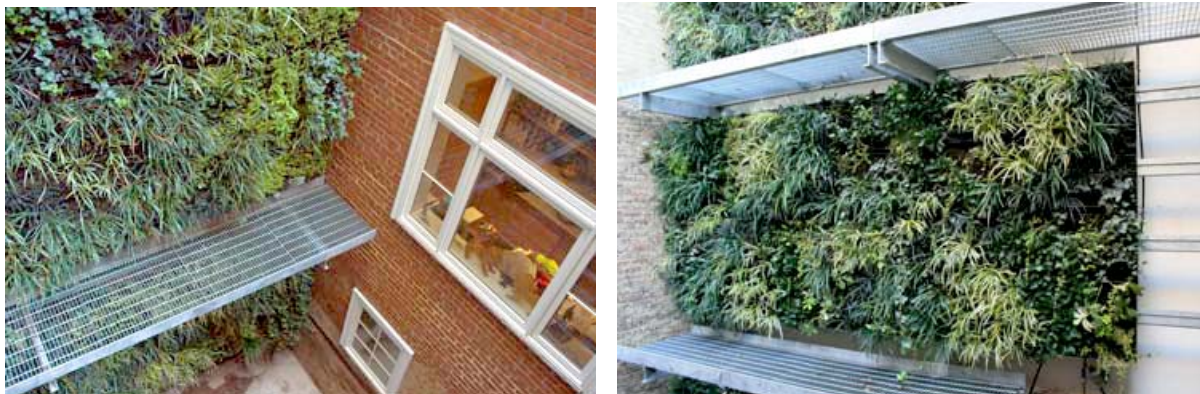
Fig.V.87 – L'azienda americana ELT Easy Green , produttrice dell'omonimo sistema industrializzato per l'inverdimento parietale, vista l'oggettiva difficoltà intrinseca e la frequenza necessaria per espletare le ordinarie operazioni manutentive, consiglia di realizzare dei camminamenti praticabili in prossimità delle pareti vegetate: soluzione certamente funzionale, ma probabilmente non proprio raccomandabile dal punto di vista della riuscita formale dell'intervento. (Fonte: http://www.eltlivingwalls.com )
