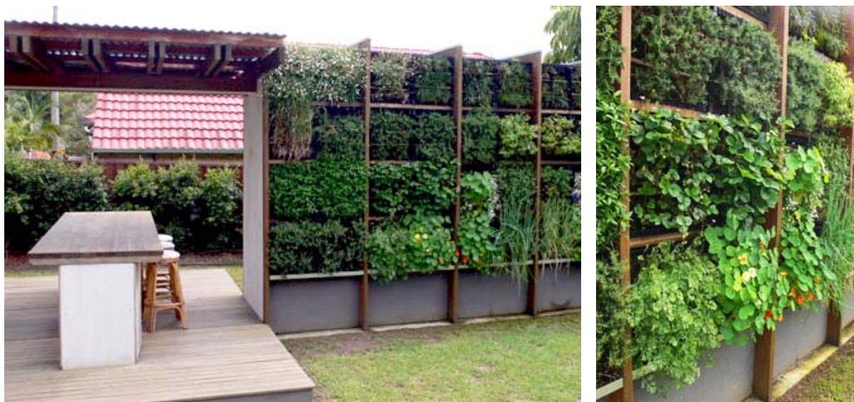
Fig.VII.63 – Turf Design Studio, The Salad Bar , Canberra (Australia), 2009. Una superficie parietale presso l'area esterna di questo locale pubblico ospita un orto verticale. L'installazione è alta 2,5 m e suddivisa orizzontalmente in partizioni modulari di 1 m. La struttura è mista in legno e acciaio, ed ogni modulo contiene del substrato dove vengono piantati i vari ortaggi. L'intero sistema è servito da un impianto d'irrigazione automatizzato e nella parte bassa dell'installazione (in colore grigio nelle immagini) è presente un serbatoio per il recupero idrico dell'acqua non trattenuta dai vegetali. (Fonte: http://www.aila.org.au/SustainableCanberra/006-salad/default.htm )
