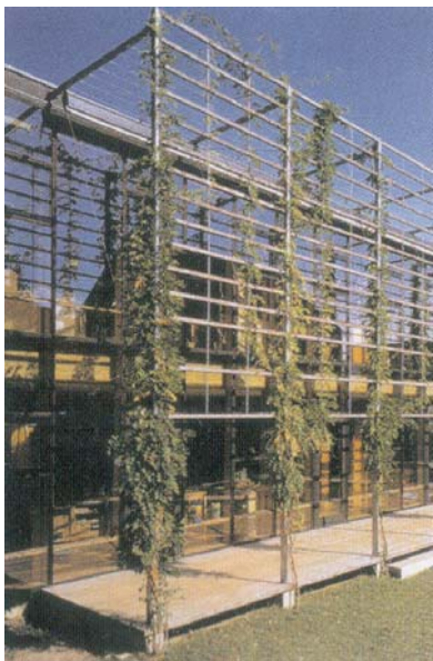
Fig.VI.11 – A sinistra: M. Ludwig e H. N. Schneider, Asilo nido, Winnenden (Germania), 1995. Esempio di schermatura solare ottenuta con specie rampicanti che si svilupperanno principalmente in orizzontale (Fonte: TUCCI, FABRIZIO, “Sistemi tecnologici per la schermatura bioclimatica dall’irraggiamento solare”, p.242).
