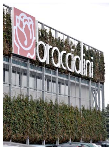
A sinistra: operazione di messa a dimora delle specie vegetali sull'apposito reticolo in metallo zincato. Si notino, nella parte bassa della foto, i vasi in PVC contenenti i rampicanti. A destra: dettaglio del sistema di rivestimento al termine dei lavori.
