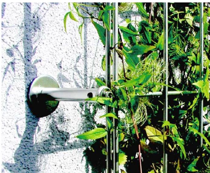
Fig.III.45 – A sinistra: dettaglio di un sistema metallico rigido a maglie ortogonali per la realizzazione di rivestimenti vegetali. (Fonte: catalogo Brandmeier Begrünungssysteme GmbH ) Fig.III.46 – A destra: CBA Progetti, Ristrutturazione di Caruzzo & Associati , Treviso, 2006. Le chiusure verticali dell'edificio sono avviluppate da una pelle vegetale distaccata dal manufatto originale e presentante proprie fondazioni e strutture in elevazione. Esempio di come il rivestimento possa disgiungersi dalla parete ad esso deputata, per divenire elemento autonomo.
