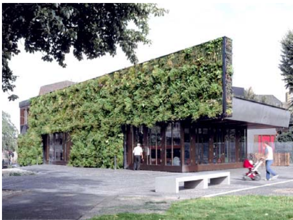
Fig.V.93 – A sinistra. DSDHA, Paradise Park Children's Centre , Londra, 2006: foto della parete a verde subito dopo il termine dei lavori. Il sistema è composto da moduli metallici gabbionati contenenti substrato; la componente a verde è realizzata tramite un mix vegetale molto variegato, composto da specie erbacee tappezzanti.
