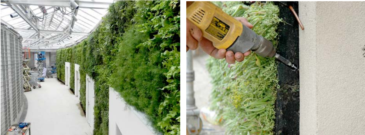
Fig.V.31 – A sinistra. Kim Wilke Associates, Longwood Gardens , Chester (USA), 2010: fasi di cantiere riguardanti il montaggio di moduli prevegetati. In base agli elaborati di progetto entrambe le pareti visibili dovranno essere inverdite: alla destra dell'immagine è possibile notare il risultato finale dell'opera, mentre a sinistra è visibile il sottosistema metallico di supporto ancora sprovvisto dei pannelli. (Fonte: http://www.lushe.com.au )
