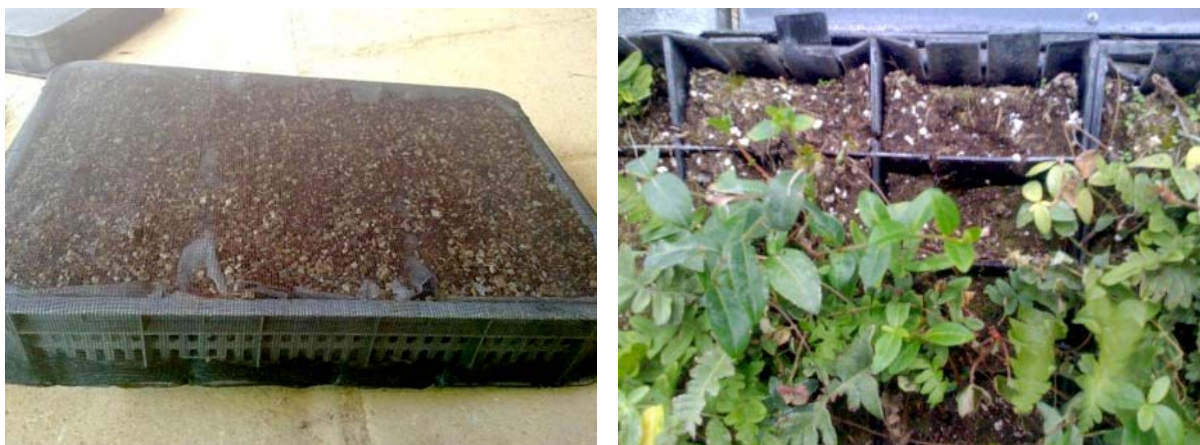
Fig.V.18 – A sinistra. Khaja N. Abdul, muro vegetale artigianale presso il terminal voli del Changi Airport (Singapore), 2009. Dettaglio del pannello contenente substrato: tale foto rappresenta il pannello a terra prima della messa in opera. L'elemento di contenimento contro la caduta o il cedimento del substrato è realizzato mediante una rete polimerica microforata. Il passo successivo prima della sua collocazione finale in opera sarà quello di praticare dei piccoli fori sulla superficie della rete per consentire l'alloggio delle piante. (Fonte: http://www.lushe.com.au )
