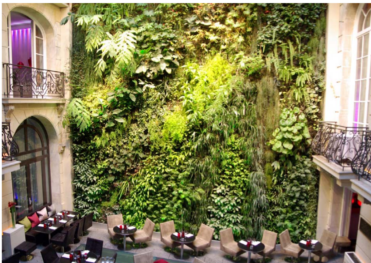
Fig.II.43 – Patrick Blanc, Mur Vegetal presso il Pershing Hall Hotel a Parigi. È evidente come questo sistema riesca a mettere in opera una grandissima varietà di specie vegetali differenti all'interno di un ordito che sfugge a qualsiasi forma di modularità. (Fonte: http://www.parisdailyphoto.com/2010/04/green-oasis.html )
