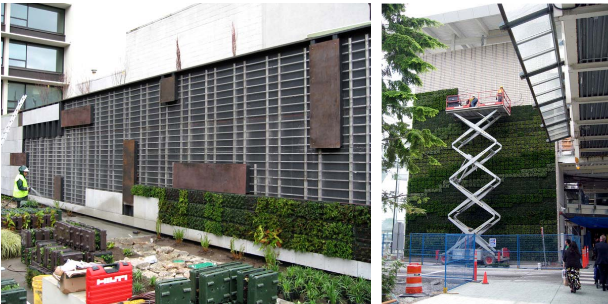
Fig.V.33 – A sinistra. Holst Architecture, Hotel Modera , Portland (USA), 2009: da questa foto di cantiere è ben comprensibile come sia realizzata una sottostruttura per la messa in opera dei pannelli vegetati. Nel caso specifico trattasi di un reticolo metallico in montanti e traversi, dove i moduli inverditi verranno semplicemente agganciati. Si noti la presenza a terra dei pannelli prevegetati già pronti per il montaggio, ed un operatore dell'azienda che provvede ad annaffiarli. (Fonte: http://gsky.com/projects/hotel-modera )
