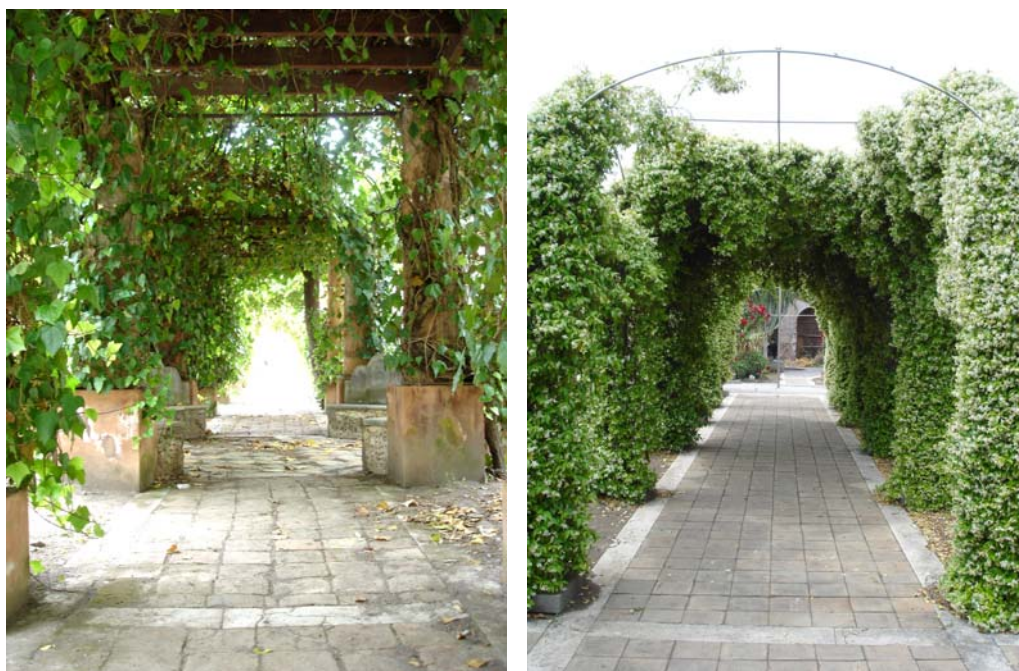
Fig.II.16 – A sinistra: pergola classica presso l'Università di Catania. Le strutture in elevazione sono realizzate mediante pilastri massivi intonacati, mentre gli orizzontamenti sono lignei.
