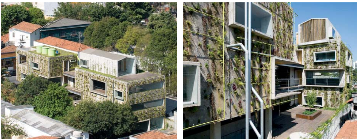
Fig.VII.36 – Triptyque, Harmonia 57 , San Paolo (Brasile): vista aerea (a sinistra) e dettaglio delle chiusure verticali (a destra). Le pareti esterne dell'edificio a destinazione d'uso mista (abitazioni e uffici) sono realizzate in C.A. grezzo lasciato a vista, e contengono delle nicchie circolari per l'alloggio di esemplari vegetali. La volontà alla base del progetto fu quella di creare un organismo edilizio in grado di rispondere alle sollecitazioni ambientali del luogo, molto umido e piovoso, spesso caratterizzato da inondazioni: le chiusure vegetate sono state quindi concepite con l'intento della regimazione idrometeorica. Nell'immagine di destra si notino le tubature sia per l'annaffiatura della parete (che avviene tramite nebulizzazione) che per il deflusso del liquido idrometeorico; esse sono lasciate a vista e giocano un ruolo fondamentale nella caratterizzazione formale del progetto. Entrambe le foto sono state eseguite nel 2008, subito dopo la chiusura del cantiere. (Fonte: http://inhabitat.com/living-water-recycling-building-wrapped-in-a-network-of-tubes )
