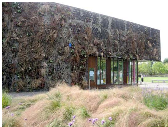
Fig.V.93 – A sinistra. DSDHA, Paradise Park Children's Centre , Londra, 2006: foto della parete a verde subito dopo il termine dei lavori. Il sistema è composto da moduli metallici gabbionati contenenti substrato; la componente a verde è realizzata tramite un mix vegetale molto variegato, composto da specie erbacee tappezzanti.
