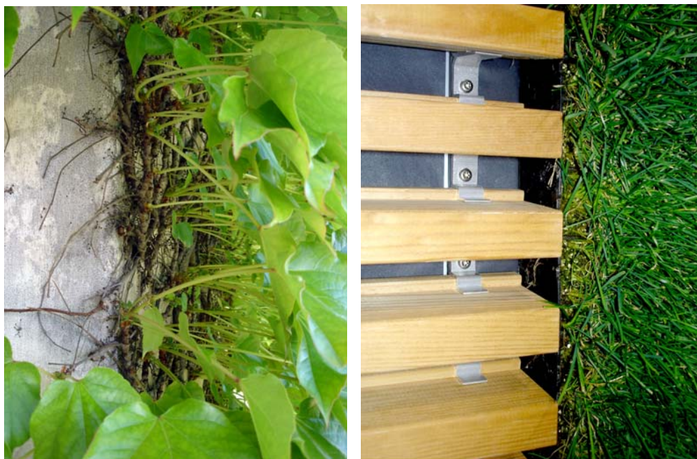
Fig.II.46 – Confronto tra due sistemi per l'inverdimento parietale. A destra un rivestimento a verde realizzato mediante specie rampicanti piantate a terra ed aggrappate alla superficie muraria. A sinistra il sistema industrializzato Tecology (cfr. capitolo V): esso è realizzato mediante una sottostruttura in alluminio distaccata qualche centimetro dalla superficie retrostante, che supporta dei moduli inverniti dello spessore di 6 cm. e realizzati in polipropilene. All'interno dei moduli sono alloggiati delle specie vegetali erbacee. L'apporto idrico e dei nutrienti necessari alla vita delle piante è garantito da un impianto automatizzato di idrocoltura. Si noti la grande differenza tecnologica e concettuale che intercorre fra i due.
