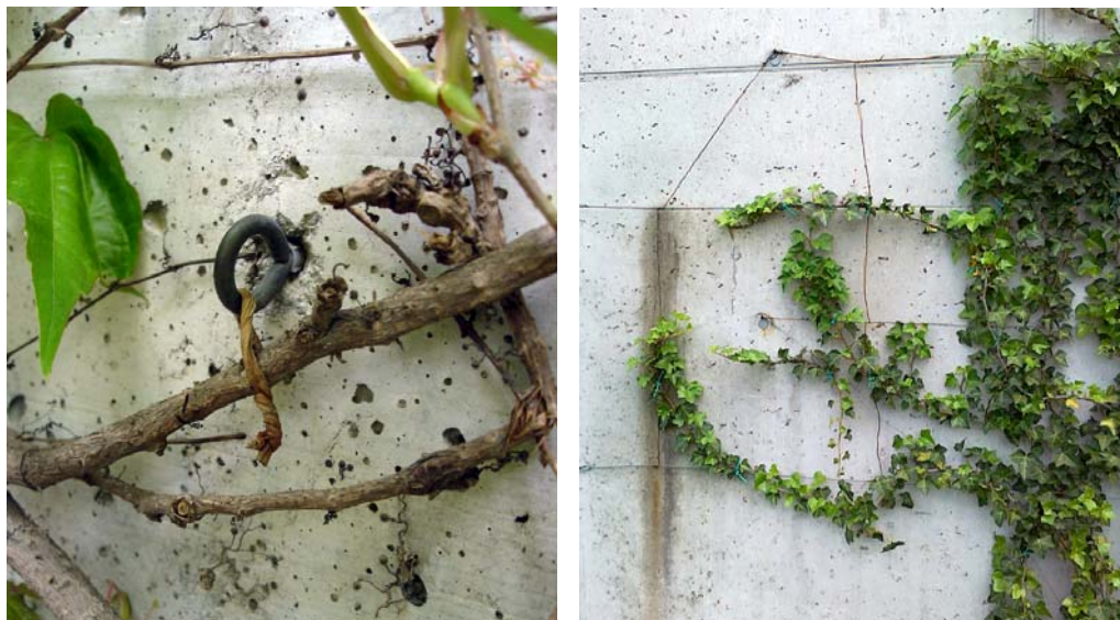
Fig.III.9 – A sinistra: elementi per il supporto della pianta nelle prime fasi d’impianto e/o per indirizzarne lo sviluppo. Trattasi di un’asola metallica a muro, completata da un legaccio che sostiene le propaggini di una Parthenocissus tricuspidata . Seppur tale specie possa contare sulle proprie radici a ventosa, l’utilizzo di elementi d’indirizzamento è a discrezione dell’agronomo che ne gestisce la crescita, qualora si voglia ottenere una copertura vegetale uniforme.
