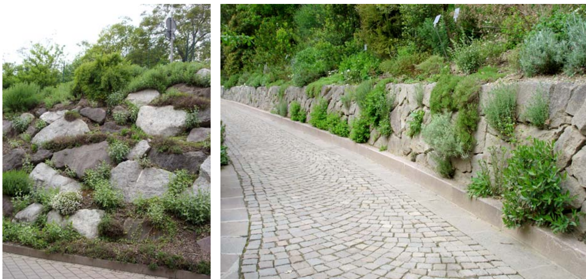
Fig.IV.18 – Esempi di terrazzamenti eseguiti mediante murature a secco. Si noti la grande varietà vegetale delle specie presenti, direttamente proporzionale alla dimensione degli interstizi tra le pietre.
