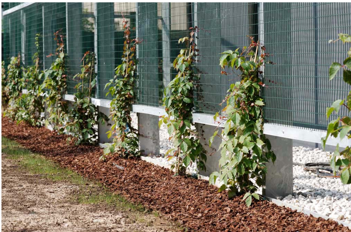
Fig.III.18 – Esempio di supporto strutturale industrializzato, destinato alla crescita di vegetazione: nella foto sono ben visibili tutti i sottosistemi che andrebbero impiegati per la realizzazione di un rivestimento a verde. Il sistema, distanziato qualche cm dalla parete edilizia (di colore scuro, sullo sfondo), si compone di supporti verticali e correnti orizzontali in acciaio zincato, a loro volta tamponati con della rete a maglia fitta di circa 1 cm. Piante di Parthenocissus tricuspidata “ Veitchii ” sono piantate in prossimità di ogni supporto e si svilupperanno utilizzando la rete come base d'appoggio. Nella fascia “a corteccia” alla base dei rampicanti è interrato un sistema automatizzato d'irrigazione, con lo scopo di fornire alle piante l'apporto idrico loro necessario. (Fonte: Carlo Bordini)
