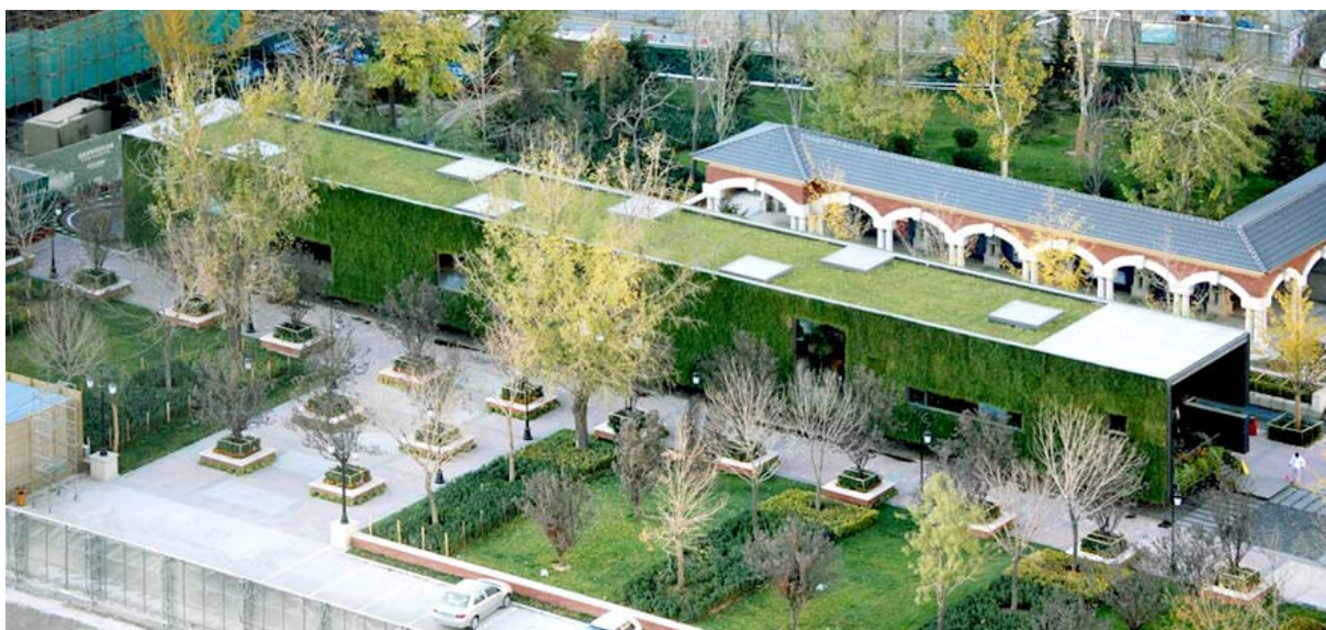
Fig.VII.14 – Vector Architects, CR Land Guanganmen Showroom , Pechino (Cina), 2008. L'involucro edilizio è completamente inverdito tramite l'impiego combinato di tecnologie per chiusure verticali vegetate e di coperture a verde estensivo. Si veda la contestuale Scheda Progetto al paragrafo V.3. (Fonte: http://www.archdaily.com )
