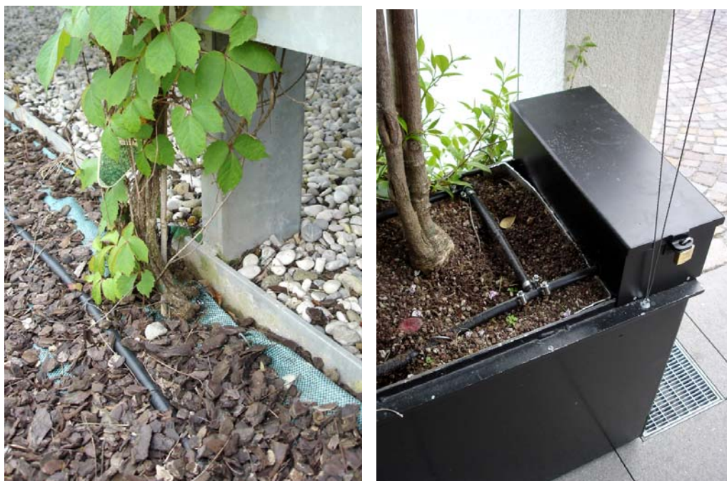
Fig.III.77 – A sinistra. Esempio di impianto d'irrigazione automatizzato sistemato nel terreno. Nella parte in basso a sinistra dell'immagine è visibile l'ala gocciolante in PVC alla base della pianta: l'obiettivo del sistema è quello di portare un adeguato quantitativo idrico nel terreno in prossimità del fusto del vegetale.
