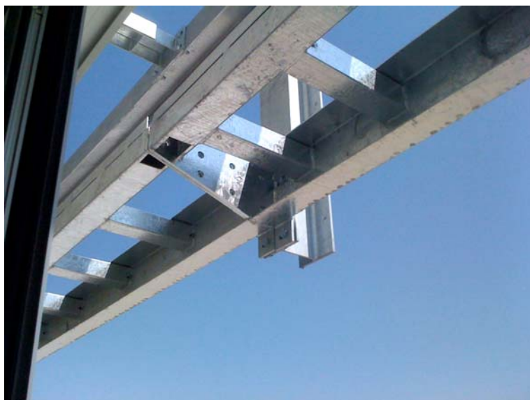
A sinistra: vista del reticolo strutturale in acciaio zincato durante le fasi di montaggio. A destra: dettaglio delle mensole metalliche per il supporto dei vasi sospesi contenenti i rampicanti.
