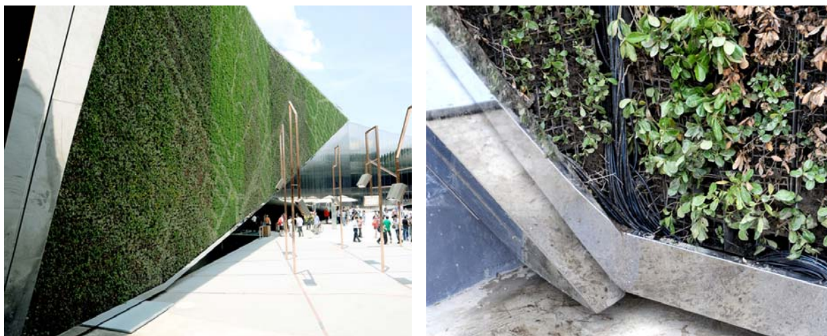
Fig.V.67 – Saia, Barbarese e Topouzanov Architects, padiglione del Canada presso l'Expo di Shanghai 2010. L'attacco a terra è stato risolto mediante una duplice strategia (foto di sinistra): in alcuni punti tocca terra, mentre in altri si eleva dal suolo per consentire il passaggio delle persone. Dal punto di vista tecnologico (a destra), esso consiste in una canalina destinata a contenere il liquido in eccesso rilasciato dalla facciata. La chiusura vegetata monospecie qui rappresentata consta di un sistema modulare, continuo e contenente una consistente quantità di substrato, quindi pesante . (Fonte: Giovanni Zannoni)
