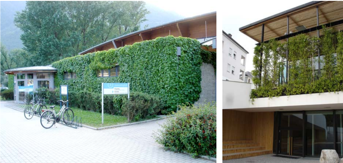
Fig.III.35 – A sinistra. Piscina di Merano (BZ): padiglione d’ingresso. Esempio di rivestimento con messa a dimora in piena terra del sistema vegetale.
