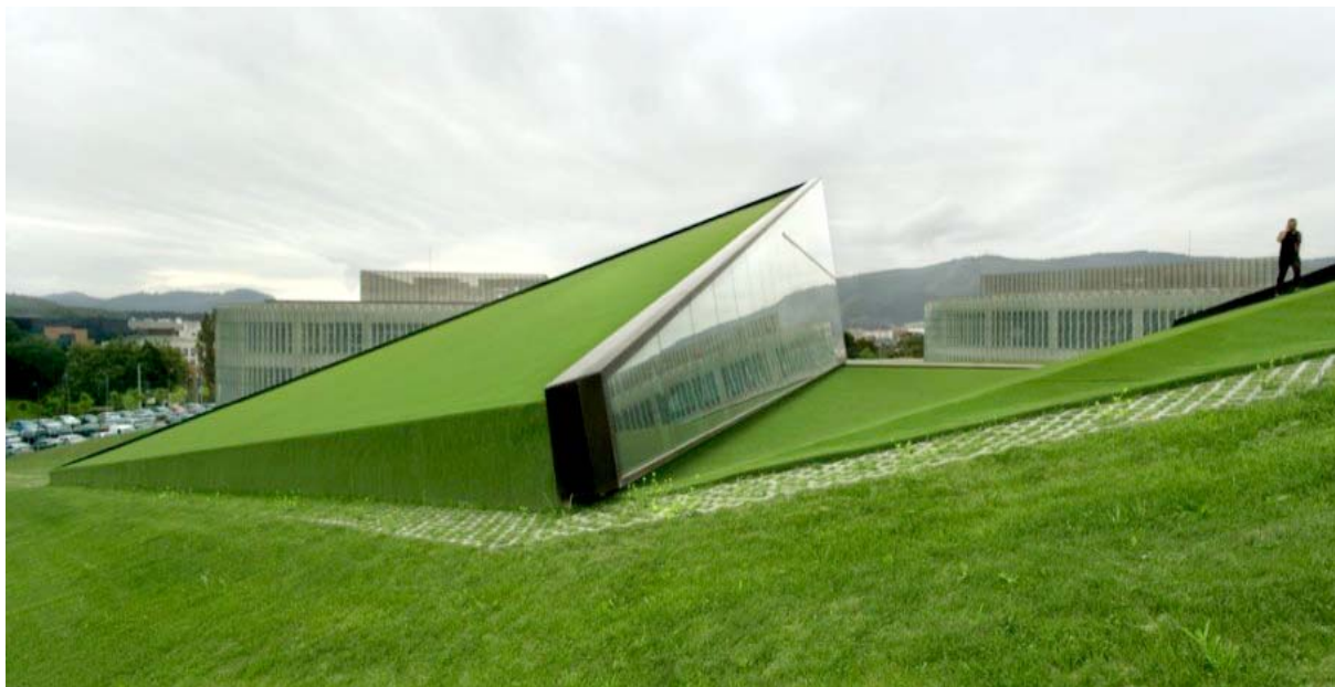
Fig.VII.18 – ACXT, Technology Interpretation Center , Derio (Spagna), 2009. Il manufatto è quasi totalmente ipogeo e le sue uniche emergenze all'esterno sono le due "piramidi-lucernaio". Una delle due piramidi è vegetata sui due lati, mediante il risvolto dell'inverdimento presente sulla collina artificiale venutasi a creare conseguentemente alla costruzione dell'edificio. ACXT non dichiara nulla di preciso a riguardo però, da uno studio degli elaborati disponibili, si presume che l'inverdimento non sia in questo caso realizzato tramite tecnologie convenzionali, ma si tratti piuttosto di erba sintetica: ciò non nega comunque che tale modalità progettuale possa essere replicata senza particolari problemi anche impiegando sistemi che prevedano vegetazione naturale. (Fonte: http://www.archdaily.com )
