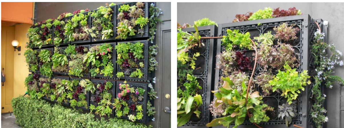
Fig.VII.64 – Esempio di utilizzo finalizzato alla produzione orticola di tecnologie originariamente nate per l'inverdimento parietale (cfr. Fig.V.24 e Fig.V.25). In una pizzeria di Los Angeles (USA), l'installazione del sistema brevettato VGM – Vertical Greening Module ha permesso l'utilizzo di una parete cieca interna al locale come spazio per la coltivazione di ortaggi: le verdure ivi coltivate vengono utilizzate nella preparazione delle stesse portate destinate ai clienti del locale. L'apparato vegetale non è stato in questo caso totalmente finalizzato alla produzione di verdura: soluzione strategica che permette di non lasciare mai la parete totalmente sprovvista di vegetazione. Nell'immagine di destra è visibile l'ala gocciolante del sistema d'irrigazione (in colore marrone chiaro) prima che venisse collocata nella sua posizione definitiva. (Fonte: http://www.lushe.com.au )
