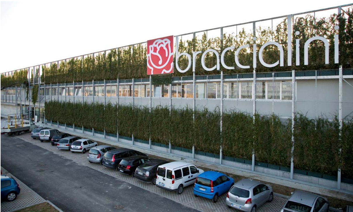
Foto della facciata principale subito dopo la chiusura del cantiere. Si noti che gli esemplari vegetali, disposti su due livelli entrambi distaccati dal piano di campagna, si trovano ad uno stato di sviluppo ancora arretrato.
