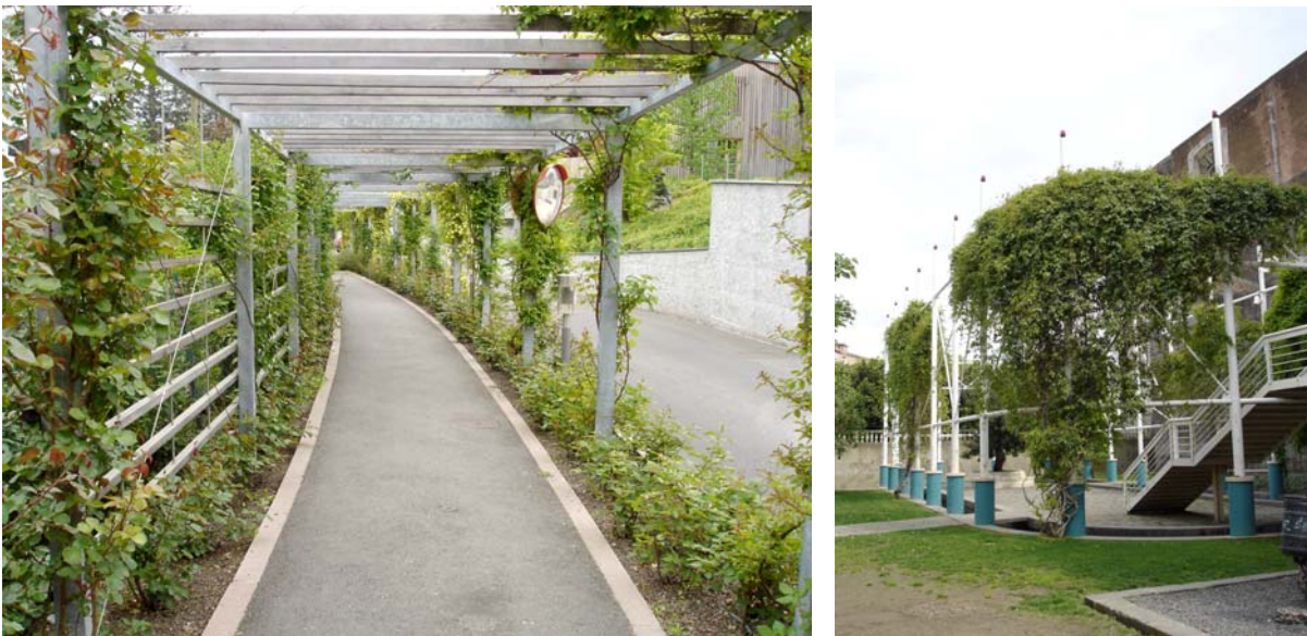
Fig.III.80 – A sinistra: esempio di pergola rivisitata con tecniche e materiali moderni. Le strutture portanti sono in acciaio zincato, mentre gli elementi lignei di completamento sono di larice non trattato. I supporti verticali e orizzontali della pergola favoriscono la verticalizzazione delle piante.
