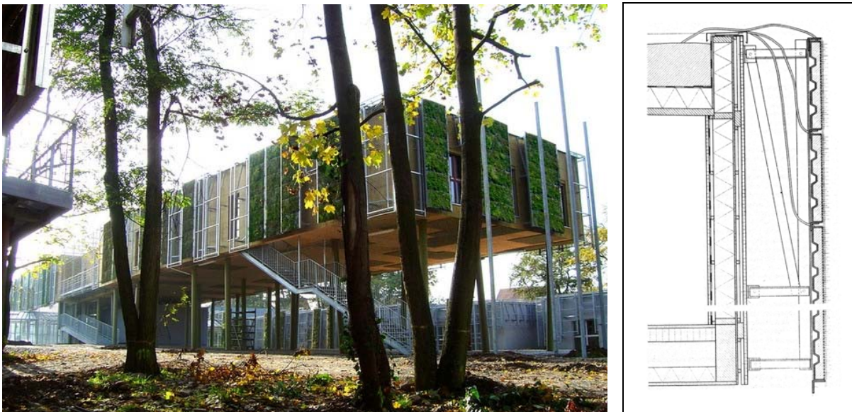
Fig.II.47 – A sinistra: Duncan Lewis, centro scolastico, Obernai (Francia), 2004. Le superfici verticali parzialmente inverdite sono realizzate mediante l'adattamento di tecnologie per la realizzazione di coperture a verde estensivo; tale adattamento è avvenuto in maniera del tutto artigianale. (Fonte: http://www.flickr.com/photos/construmatica/473411504/sizes/o )
