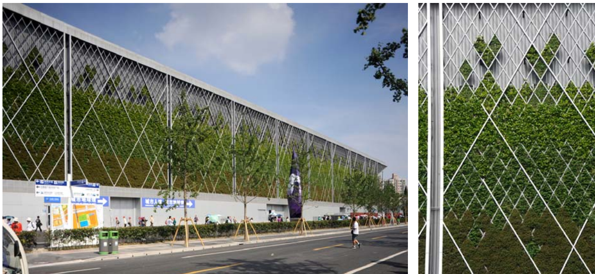
Fig.V.83 – Expo di Shanghai 2010: Padiglione Tematico . La tecnologia dei pannelli vegetati permette delle composizioni che non sarebbe possibile realizzare con altri sistemi di facciata a verde. Interessante da notare anche la varietà delle specie impiegate (immagine di destra): esse, procedendo dal basso verso l’alto, si diradano non solo grazie alla composizione architettonica ma anche in funzione delle specifiche caratteristiche vegetali. (Fonte: Giovanni Zannoni)
