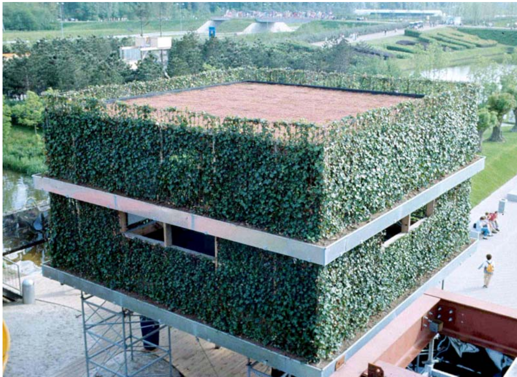
Fig.III.27 – Nuova casa naturale, fiera Floriade, 2002. Esempio di giustapposizione in verticale di più fasce inverdite mediante l'espedito tecnico della creazione di fioriere in quota. Nel caso specifico le fioriere orizzontali corrispondono alle fasce marcapiano dell'edificio. (Fonte: Marco Devecchi)
