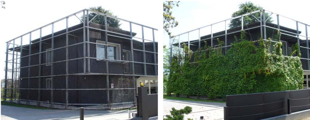
Fig.III.21 – CBA Progetti, ristrutturazione dello Studio Caruzzo & Associati , Treviso, 2006. L'utilizzo di una specie decidua rende la pelle edilizia mutevole durante l'arco dell'anno. In inverno (foto a sinistra) sono visibili solo il reticolo strutturale e gli esili rami della pianta senza foglie, mentre nelle altre stagioni (a destra) l'edificio si ricopre di uno strato vegetale. Sempre nella foto a destra si noti come a quasi quattro anni dall'impianto del rampicante le propaggini vegetali non abbiano ancora raggiunto la sommità dell'edificio.
