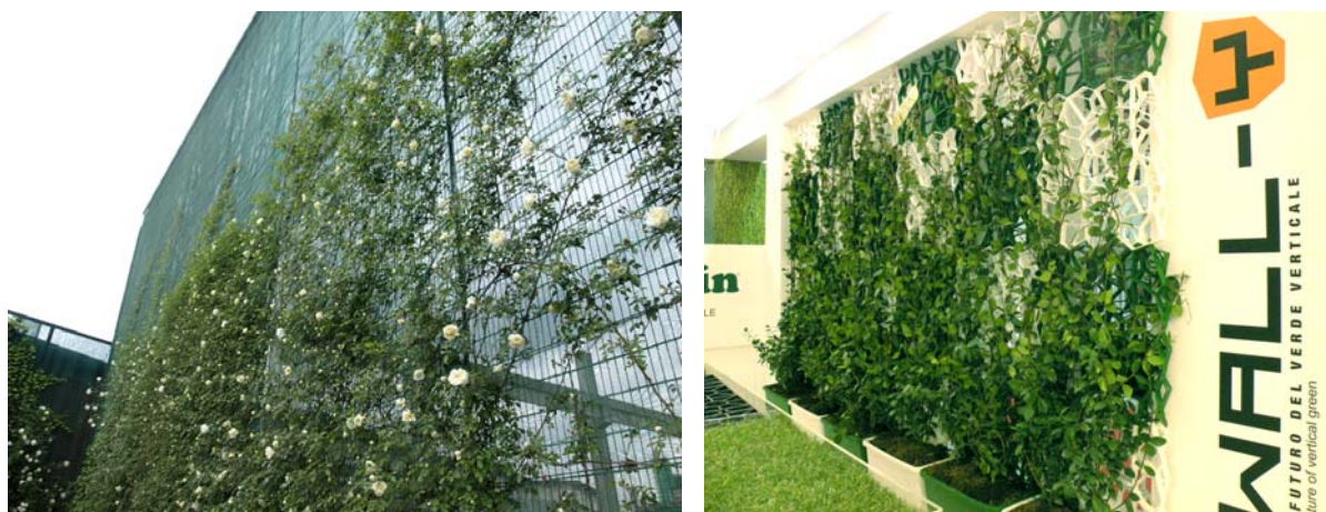
Fig.III.65 – A destra. Esempio di griglia in FRP per il supporto di rivestimenti a verde. Nel caso specifico è stata impiegata nella riqualificazione architettonica di un edificio industriale. Il sistema è denominato Greenover e viene prodotto dall'azienda Tecnoimage . (Fonte: http://www.tecnoimage.it )
