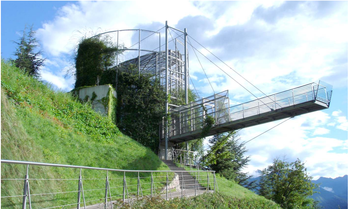
Fig.III.82 – Voliera presso i Giardini di Castel Trauttmansdorff , Merano (BZ). Esempio di Verde Verticale libero autoportante finalizzato all'inserimento paesaggistico. Tutte le parti dell'installazione sono realizzate in strutture e graticci di acciaio zincato, al fine di poter essere completamente invasi col tempo dalla vegetazione naturale del parco. La foto risale al 2006, quando l'installazione era stata da poco completata. Oggi tale struttura risulta quasi completamente rivestita dalla vegetazione del giardino botanico.
