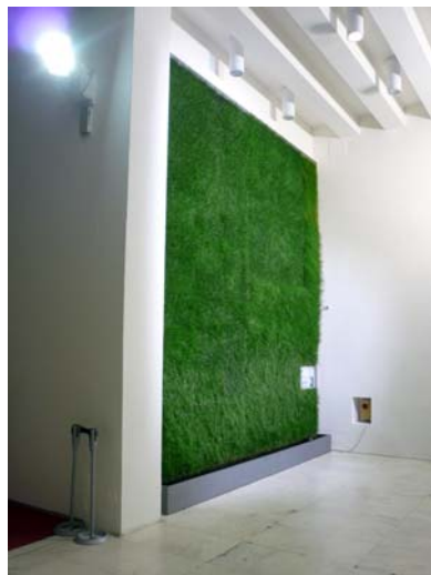
Fig.V.52 – A sinistra: BioTecture Ltd, Anthropologie Store , Londra, 2009. Muro vegetale indoor : nella parte alta dell’installazione è presente l’impianto d’illuminazione per fornire artificialmente alle piante la luce di cui necessitano, mentre sulla destra è visibile l’elemento di connessione verticale tra la chiusura pre-esistente e il sistema d’inverdimento. (Fonte: Valeria M. Rocco)
