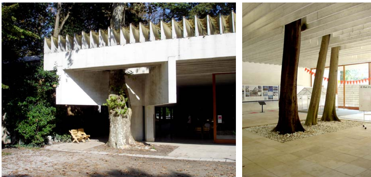
Fig.VII.3 – Sverre Fehn, padiglione dei Paesi Nordici presso i Giardini della Biennale di Venezia, 1961. Fehn è uno dei maestri nell'integrazione fra architettura e paesaggio naturale; in questo caso l'architetto norvegese non solo ha studiato una particolare conformazione per la connessione trave-pilastro in modo che potesse ospitare un platano pre-esistente (immagine di sinistra), ma ha anche sviluppato l'intero spazio interno utilizzando come fulcro visivo i tre alberi precedentemente riscontrabili in loco (vista dell'interno, a destra). Si noti la similitudine di tale azione progettuale con quella descritta nell'immagine precedente (cfr. Fig.VII.2), anche alla luce del fatto che i due progetti sono stati concepiti contemporaneamente da due architetti provenienti entrambi dalla penisola scandinava.
