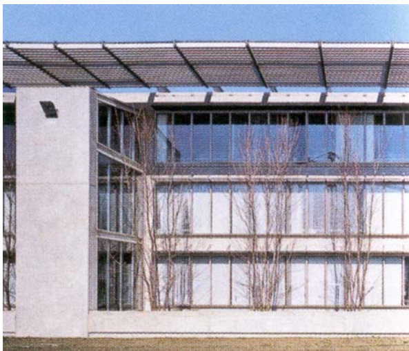
Fig.VI.13 – Christian Hauvette, Centro di ricerca e Scuola di Ingegneria, Clermont-Ferrand (F). La vegetazione arborea caduciflora a ridosso delle facciate permette di ottenere una protezione solare durante le stagioni calde, per le chiusure esposte all’irraggiamento diretto. Le due fotografie rappresentano il medesimo edificio: a sinistra in inverno, a destra durante il periodo estivo. (Fonte: MINGUZZI, GIANLUCA, Architettura sostenibile – Una scelta responsabile per uno sviluppo equilibrato , in bibl., p.66)
