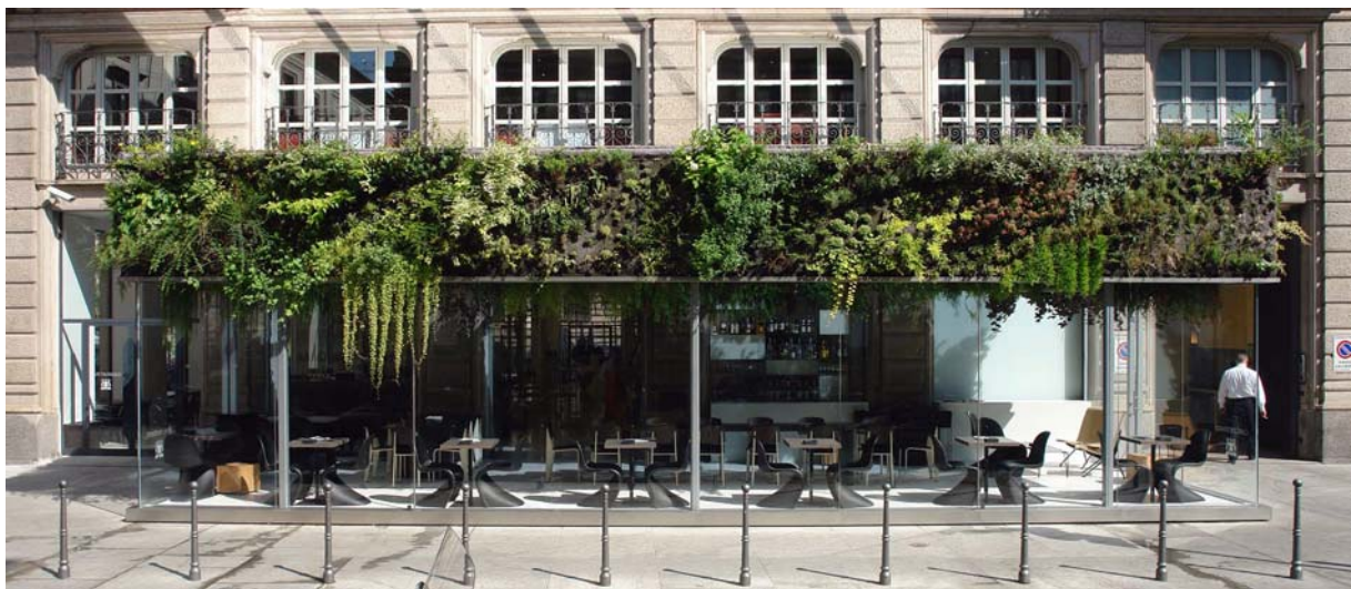
La facciata prospettante sulla piazza subito dopo la fine dei lavori.
