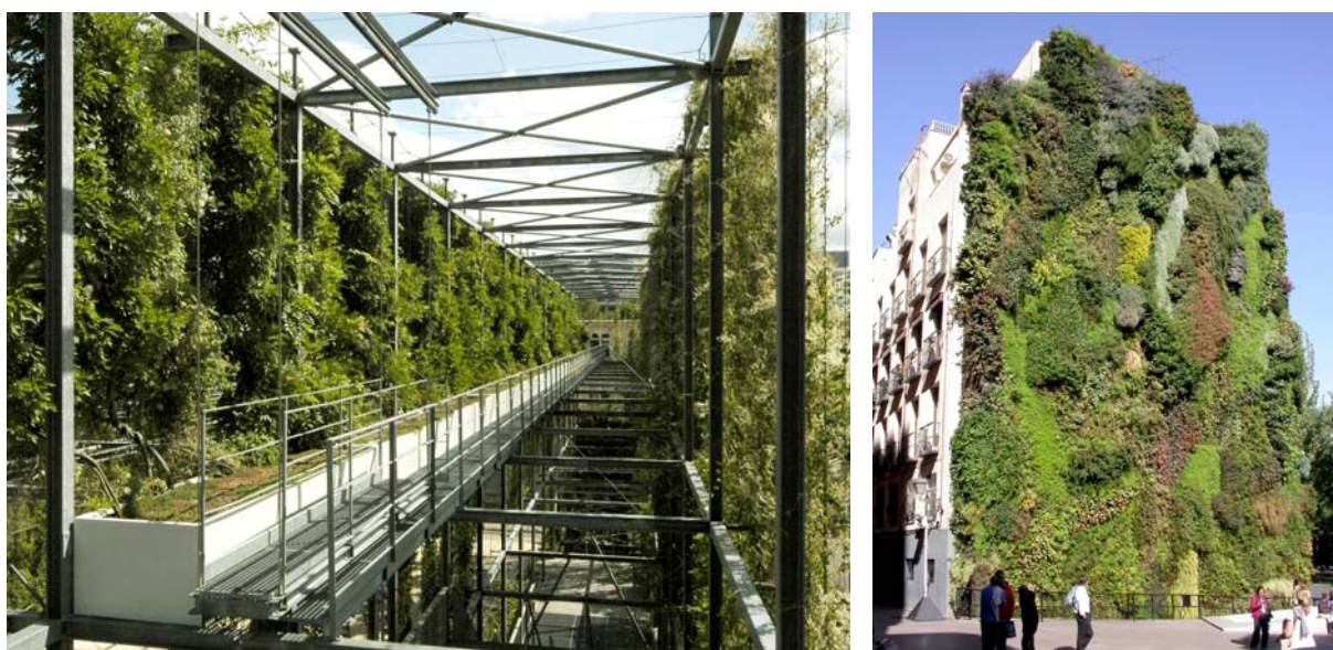
Fig.VIII.1 – A sinistra. Burckhardt + AG Architekten: MFO Park , Zurigo (Svizzera), 2002. La bassa complessità tecnologica dei rivestimenti a verde li rende un sistema sostenibile e poco energivoro. (Fonte: Giovanni Avosani)
