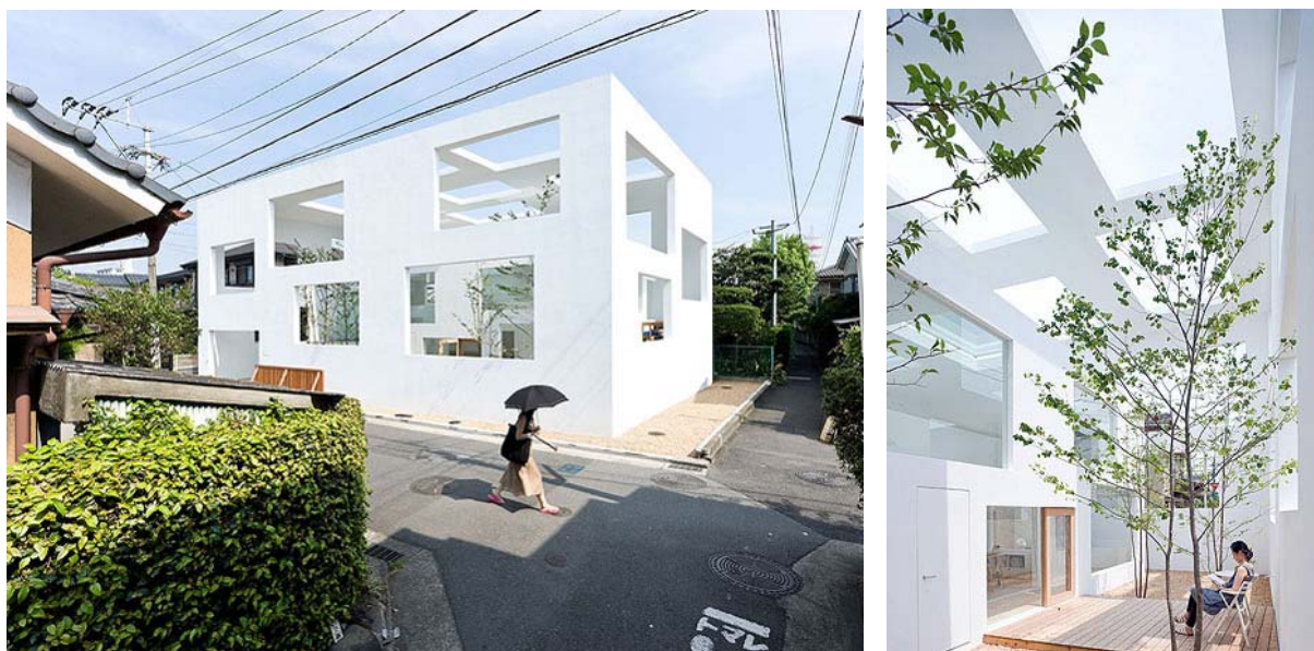
Fig.VII.11 – Sou Fujimoto, House N , Oita (Giappone), 2008. In chiusura di paragrafo si riporta un esempio low-tech d'integrazione architettura/natura. Questa casa privata è composta da tre involucri dello stesso materiale che si contengono l'un l'altro come fossero delle scatole cinesi. L'involucro più interno contiene i vari vani dell'abitazione, quello intermedio rappresenta le chiusure vere e proprie dell'edificio, mentre il guscio più esterno coincide col confine del lotto e quindi delimita lo spazio semiaperto di pertinenza. Tra il secondo e il terzo involucro (foto di destra) vi è il cortile dell'abitazione: un giardino roccioso dove presenziano alcuni esemplari arborei. Si notino le forature presenti anche sulla copertura dell'involucro più esterno, in modo da uniformare la conformazione delle chiusure. (Fonte: http://www.archdaily.com )
