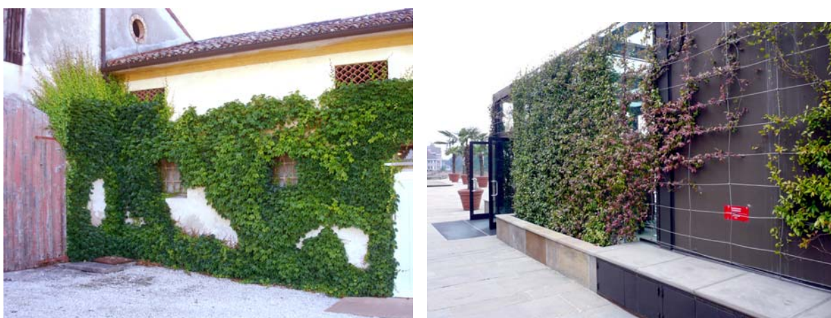
Fig.III.19 – A sinistra. In passato i rivestimenti a verde venivano eseguiti mediante l'impiego di piante rampicanti direttamente aggrappate alle superfici edilizie. Nell'edificio storico raffigurato non esiste alcuna sottostruttura di mediazione fra i vegetali e la superficie muraria.
