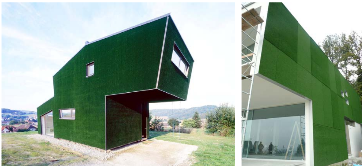
Fig.II.87 – A sinistra. GRID Architects, Amalia House , Styria (Austria), 2007. L’immagine verde offerta dalla casa di vacanze è lievemente contraddetta dal fatto di essere totalmente rivestita da erba sintetica. (Fonte: http://www.archdaily.com )
