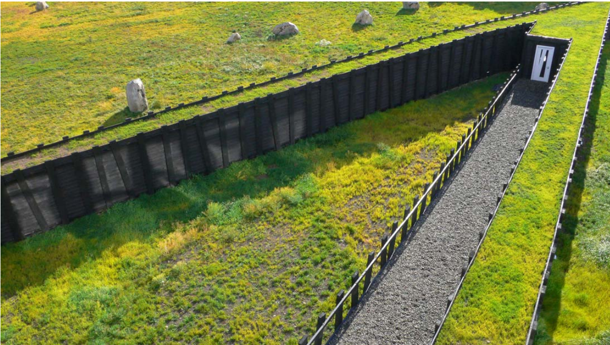
Fig.VI.52 – Germán De Sol, Hotel Remota , Patagonia (Chile), 2008. Esempio di compensazione ambientale: la copertura dell'edificio ospita la stessa vegetazione autoctona circostante, in modo da restituire all'ecosistema naturale tutta la superficie negatagli mediante l'edificazione. (Fonte: http://www.archdaily.com )
