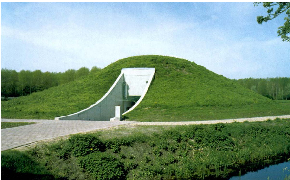
Fig.VII.17 – MIII Architecten, Environmental Education Center , Hoorn (Paesi Bassi), 2003. L'edificio semi-ipogeo presenta un involucro vegetato che si innalza dal terreno senza soluzione di continuità: la tecnologia d'inverdimento è quella della copertura a verde intensivo. Interessante la similitudine formale e "tecnologica" con l'edificio del periodo mesolitico riportato in Fig.II.2. (Fonte: JODIDIO, PHILIP, Green architecture now! , in bibl., p.227)
