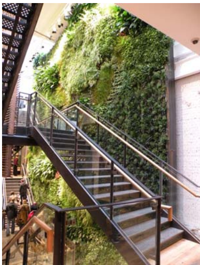
Fig.V.52 – A sinistra: BioTecture Ltd, Anthropologie Store , Londra, 2009. Muro vegetale indoor : nella parte alta dell’installazione è presente l’impianto d’illuminazione per fornire artificialmente alle piante la luce di cui necessitano, mentre sulla destra è visibile l’elemento di connessione verticale tra la chiusura pre-esistente e il sistema d’inverdimento. (Fonte: Valeria M. Rocco)
