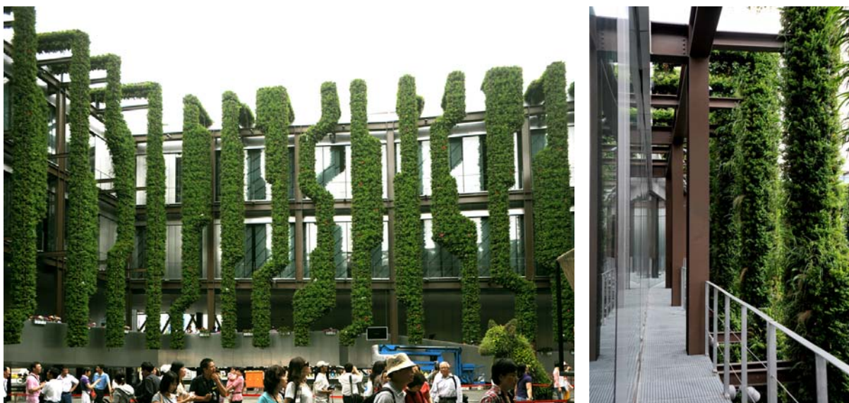
Fig.VII.40 – Jacques Ferrier, padiglione francese presso l'Expo di Shanghai 2010. Le chiusure trasparenti che affacciano sulla corte sono schermate tramite delle fasce verticali a verde che poi proseguono anche in copertura. Si presume che comunque, in tal caso, l'apparato vegetale abbia più una valenza formale che prettamente funzionale, in quanto il disegno degli elementi a verde risulta esattamente uguale in tutte le facciate, anche quelle in cui una schermatura verticale si rivela non funzionale o non necessaria (ossia quelle esposte a Sud e Nord). Ciò non toglie che la matrice d'impiego qui sperimentata sia interessante ed innovativa, pienamente utilizzabile d'ora in avanti nella creazione di chiusure vegetate frangisole. Tra l'apparato vegetale e il curtain wall è presente un ballatoio (foto di destra): si noti l'apprezzabile effetto spaziale e percettivo prodotto dalla presenza della schermatura a verde nel momento in cui si transiti attraverso tale passaggio pedonale. (Fonte: Giovanni Zannoni)
