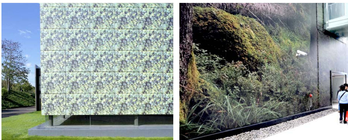
Fig.II.89 – A sinistra. Rue Royale Architectes, palestra, Francheville (Francia), 2001. L’involucro è realizzato mediante una pelle edilizia in laminato stratificato ad alta densità, riportante un motivo vegetale raffigurante dell’edera ed impresso in quadricromia mediante il processo del Digital Print . (Fonte: http://www.rueroyalearchitectes.com )
