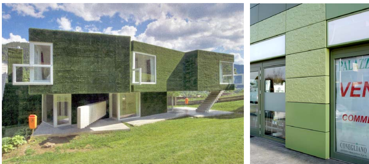
Fig.II.85 – A sinistra. WEIchlbauerORTis Architekten, casa a Lafnitzdorf (Austria), 2009. Le chiusure verticali dell’edificio sono interamente rivestite con pannelli di erba sintetica. (Fonte: Redazionale di A10, “Country living”, in bibl., p.6)
