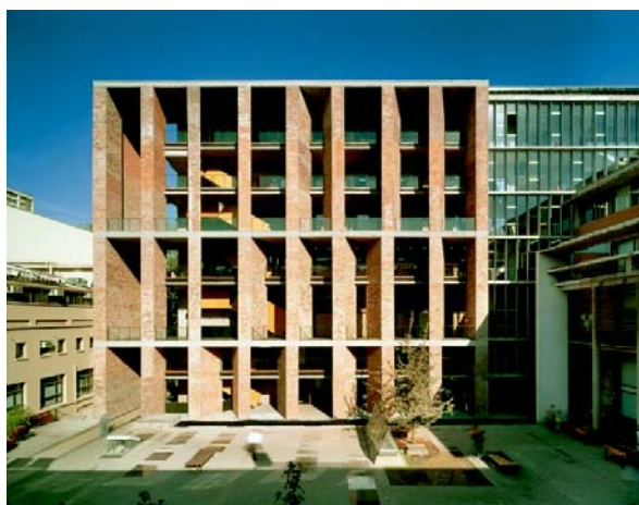
Fig.VII.41 – A sinistra. Alejandro Aravena Arquitecto, Facoltà di Medicina presso l'Università Cattolica, Santiago del Cile, 2004. La schermatura solare fissa è ottenuta tramite setti verticali in mattoni faccia a vista, collocati davanti al curtain wall vetrato che delimita i percorsi interni all'edificio. (Fonte: http://www.alejandraravena.com )
