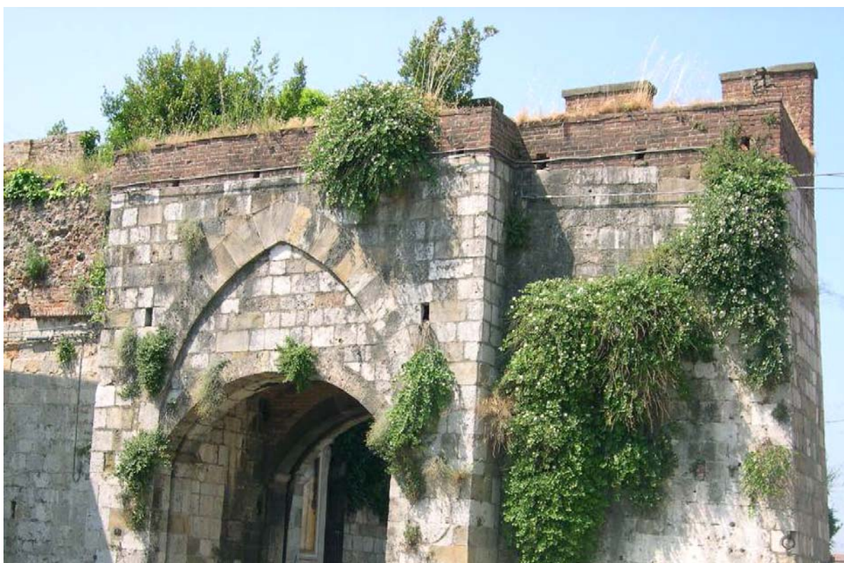
Fig.IV.7 – Edificio storico colonizzato dai vegetali. Queste piante di Capparis spinosa (cappero) sono riuscite ad invadere la muratura (colonizzazione primaria) sfruttando la propria capacità di disseminazione myrmecocora: i semi della pianta – molto grandi, quindi impossibilitati al raggiungimento autonomo delle fessure murarie – vengono trasportati dalle formiche che li collocano negli interstizi rocciosi. (Fonte: BENVENUTI, STEFANO, Aspetti biologici ed ecologici della flora infestante dell'ecosistema urbano , in bibl., p.11)
