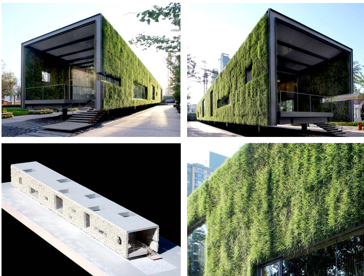
Sopra: viste della facciata esposta a Est, in prossimità dell'ingresso al padiglione. Sotto a sinistra: modello tridimensionale. Sotto a destra: dettaglio del sistema d'inverdimento.
