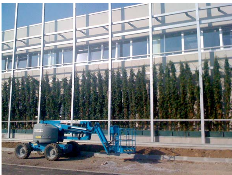
A sinistra: operazione di messa a dimora delle specie vegetali sull'apposito reticolo in metallo zincato. Si notino, nella parte bassa della foto, i vasi in PVC contenenti i rampicanti. A destra: dettaglio del sistema di rivestimento al termine dei lavori.
