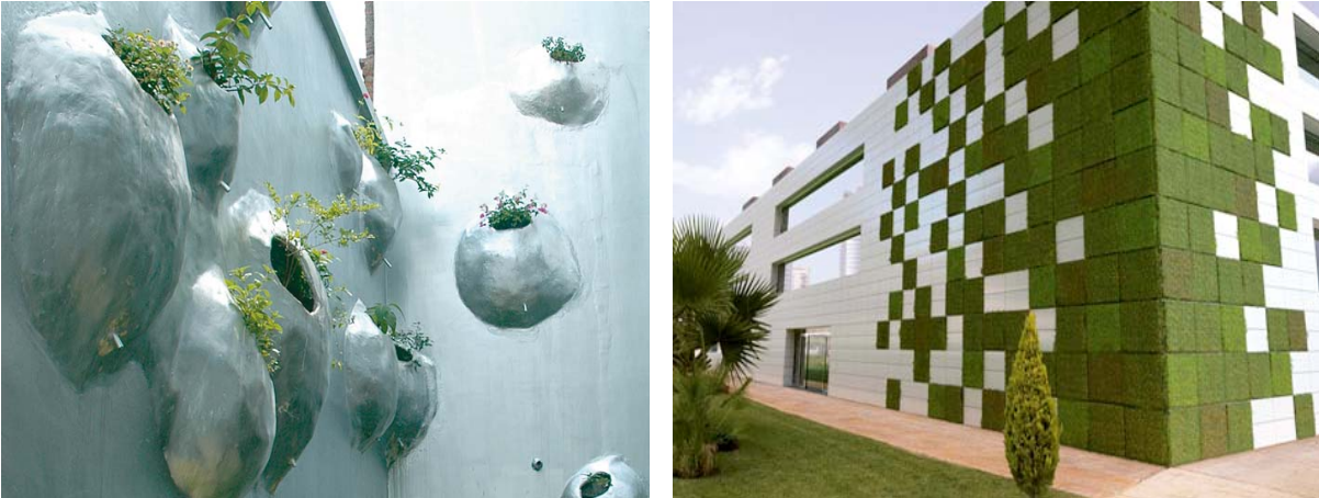
Fig.V.60 – A sinistra. HUSOS e Francisco Amaro, GBHNPCB – Casa-Taller Croquis , Cali (Colombia), 2008. Esempio di sistema d’inverdimento puntuale: nel caso specifico è stato eseguito artigianalmente , mediante la modellazione del calcestruzzo armato con cui è eseguita la parete ospitante, in modo da creare una sorta di “vasi” per l’impianto di vegetali. (Fonte: http://www.husos.info/proyectos/EJHNM/00_6_bulbos%202.jpg )
