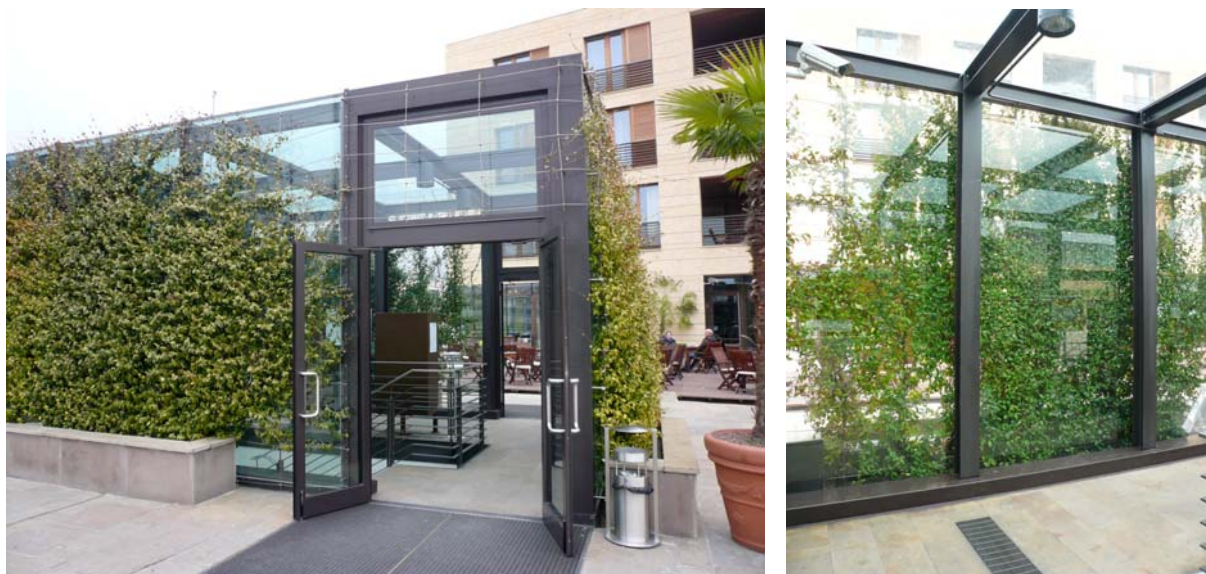
Fig.III.87 – A sinistra. Matteo Thun, Terme di Merano (BZ), 2005: scala di accesso al parcheggio interrato. Esempio di rivestimento a verde impiegato per la schermatura di chiusure trasparenti. Nel sopraluce della porta d'ingresso, l'incompleto sviluppo del sistema vegetale lascia intravedere il reticolo di cavi destinato al supporto delle propaggini della pianta.
