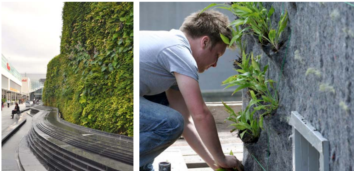
Fig.VIII.5 – A sinistra. AECOM Design & Planning: Westfield Shopping Centre , Londra (UK), 2009. La presenza in parete di un grande spessore di substrato lo rende un sistema pesante , quindi prestante dal punto di vista della gestione energetica in fase estiva. (Fonte: Giovanni Avosani)
