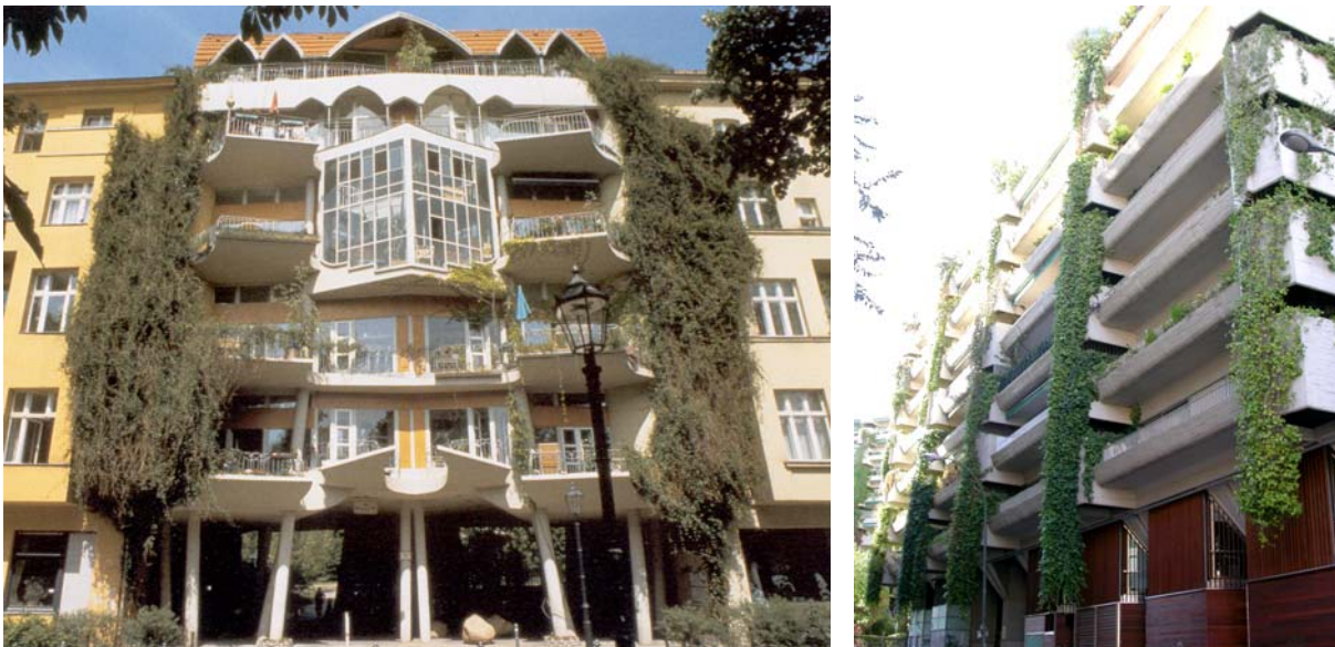
Fig.II.36 – A sinistra: Hinrich Baller, edificio a Fraenkelufer (Germania). Le specie vegetali a portamento rampicante sono piantate a terra ai due lati del portale d'ingresso. (Fonte: WINES, JAMES, Green architecture , in bibl., p.159)
