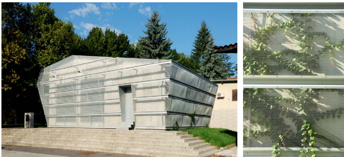
Fig.III.97 – Arhitektura Krušec, Celje Power Plant , Celje (Slovenia), 2005. Annesso industriale (di nuova edificazione) in cui le chiusure verticali verranno, col trascorrere del tempo, completamente rivestite dalle piante. Anche in questo caso l'andamento del sottosistema deputato ad accogliere i vegetali si discosta da quello delle pareti per assumere una configurazione autonoma. (Fonte: http://www.archdaily.com )
