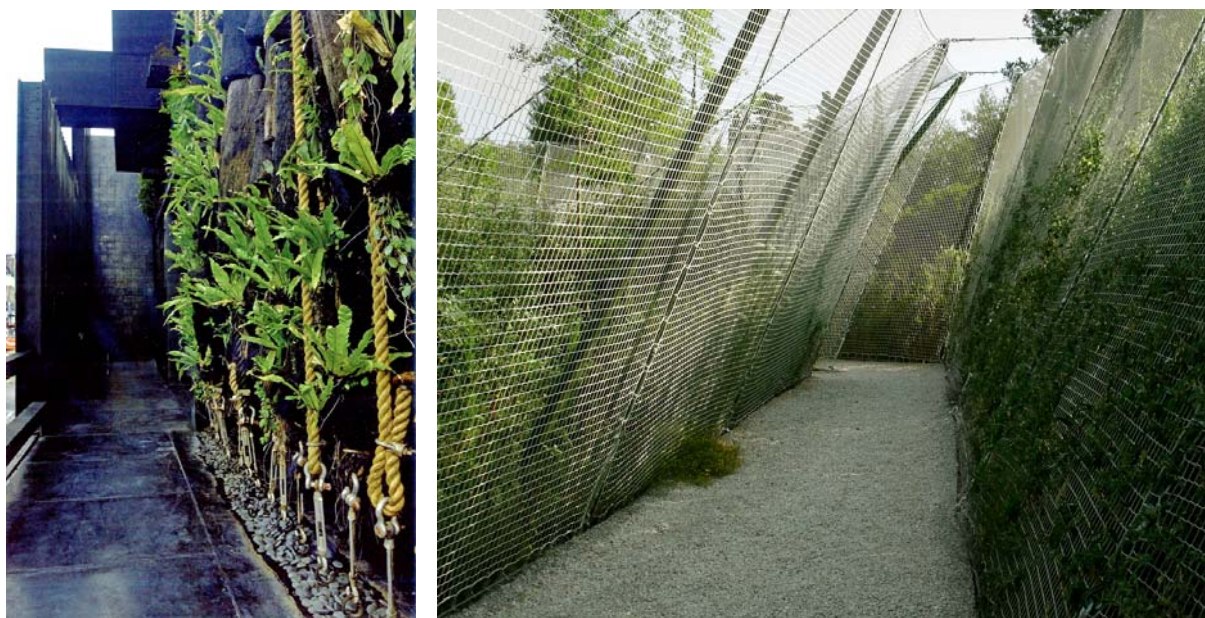
Fig.III.67 – A sinistra. Giovanni D'Ambrosio, VI.AI.PI. Restaurant , Bali (Indonesia) 2003: dettaglio alla base del rivestimento. Il supporto alle piante è realizzato mediante funi verticali. Vista la collocazione geografica dell'intervento, si sono utilizzate specie autoctone tropicali. (Fonte: FABRIS, LUCA MARIA FRANCESCO, Tecnonatura: progetti per la rivoluzione ambientale , in bibl., p.176)
