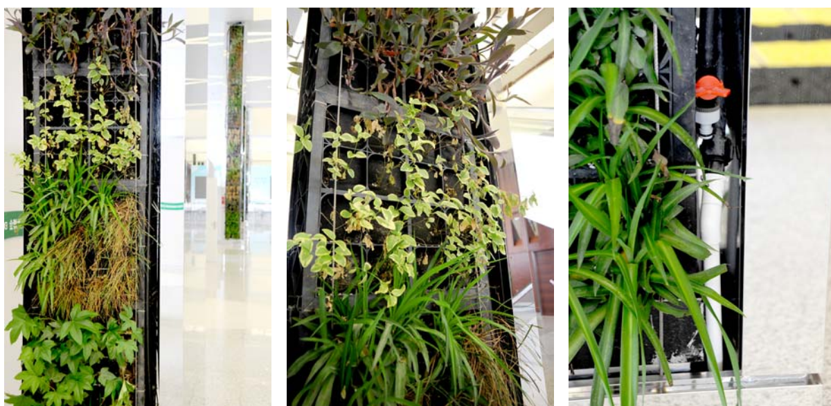
Fig.V.25 – Esempio applicativo del sistema VGM – Vertical Greening Module (Cfr.Fig.V.24), all'interno del Press Centre presso l'Expo di Shanghai 2010: i pannelli vegetati sono contenuti nei pilastri strutturali. Vista la scarsa qualità raggiunta dall'inverdimento, sono comprensibili le modalità di messa in opera dei moduli preformati. Nella foto al centro, ai due lati della facciata di ogni pannello, si possono vedere i correnti verticali in filo metallico che servono a bloccare il sistema contro il ribaltamento. A destra è raffigurata la base del pilastro: vi si può notare un dettaglio del sistema d'irrigazione automatizzata. (Fonte: Giovanni Zannoni)
