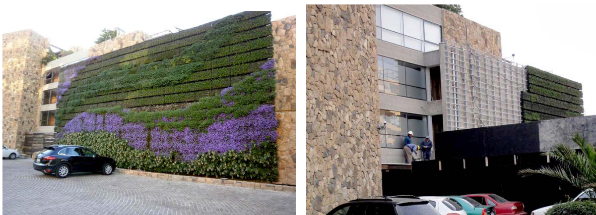
Fig.VII.59 – Mitzi Rojas, Hotel Radisson , Concepción (Cile), 2010. Anche in questo caso il sistema Babylon è stato impiegato in funzione della fitodepurazione verticale: tutta l'acqua grigia prodotta dall'albergo viene biodepurata dalle piante presenti in parete, per essere successivamente re-impiegata. Nell'immagine di destra sono raffigurate alcune fasi di cantiere, dove si può notare la natura modulare del sistema e la sottostruttura metallica di supporto ai pannelli prevegetati. Come visibile, nonostante la natura fortemente funzionalizzata di questa particolare tipologia di chiusure inverdite, esse presentano comunque un'apprezzabile valenza formale. (Fonte: http://www.v-ter.com )
