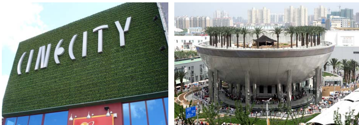
Fig.II.91 – A sinistra: Andrea Viviani, Cinecity Multiplex , Limena (PD), 2005. La facciata principale è stata "inverdita" mediante moduli di edera sintetica.
