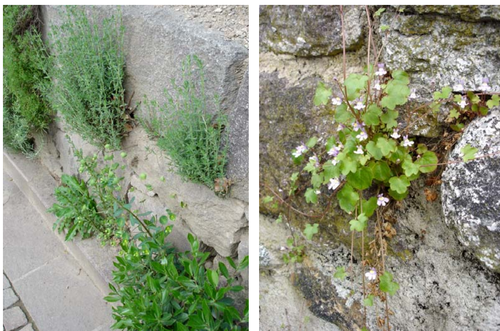
Fig.IV.15 – Dettagli di murature a secco: gli interstizi fra i massi che le compongono diventano cavità per il deposito di terra e substrati che, col trascorrere del tempo, verranno colonizzati da forme vegetali differenti.
