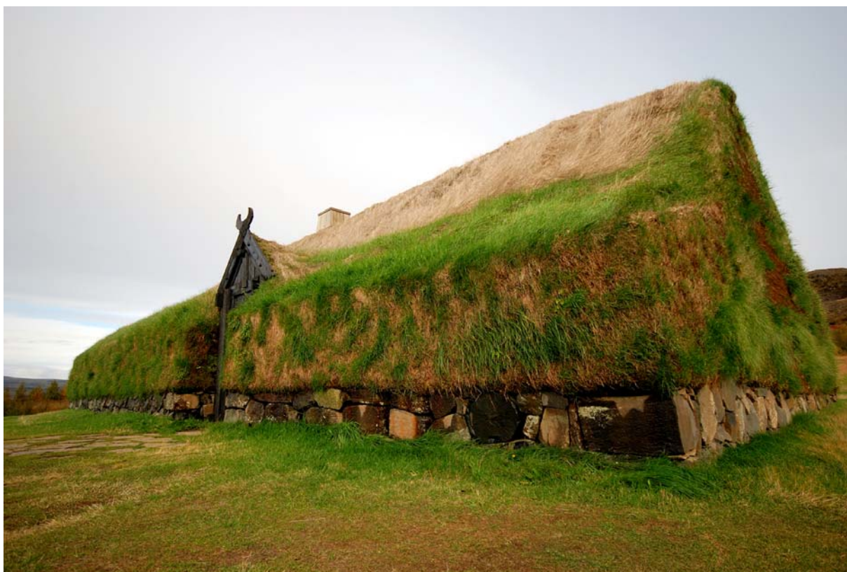
Fig.II.9 – Esempio di long house vichinga. La long house è un'evoluzione storica della turf house . Tali edifici, seppur variando l'assetto spaziale delle turf houses hanno in alcuni casi continuato a riproporre le tecnologie di chiusura. Si noti inoltre la grande somiglianza metaprogettuale tra questo manufatto e sperimentazioni più contemporanee di involucro a verde, come ad esempio le opere di Emilio Ambasz, Patrick Blanc o Venhoeven CS che verranno descritte nel prosieguo della ricerca. (Fonte: http://upload.wikimedia.org )
