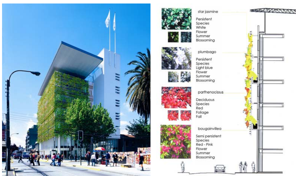
Fig.VI.16 – L'edificio Consorcio Building situato a Concepción in Chile e progettato dall'architetto Enrique Browne, utilizza come protezione solare degli spazi-filtro esterni agli uffici un sistema di specie vegetali piantumate in quota. Tale sistema schermante consiste in una sottostruttura di acciaio e legno dove vengono fatte crescere delle piante rampicanti, ed è orientato sui lati Nord, Nord-Est e Nord-Ovest (il Chile si trova nell'emisfero Australe, quindi la facciata maggiormente esposta all'irraggiamento solare è quella a Nord). Come si può vedere dal disegno a destra, la schermatura vegetale è composta da quattro specie differenti, sia a foglia caduca che sempreverdi, a seconda delle necessità funzionali interne e dell'orientamento edilizio. Si veda la contestuale Scheda Progetto al capitolo III. (Fonte: Enrique Browne y Arquitectos Asociados)
