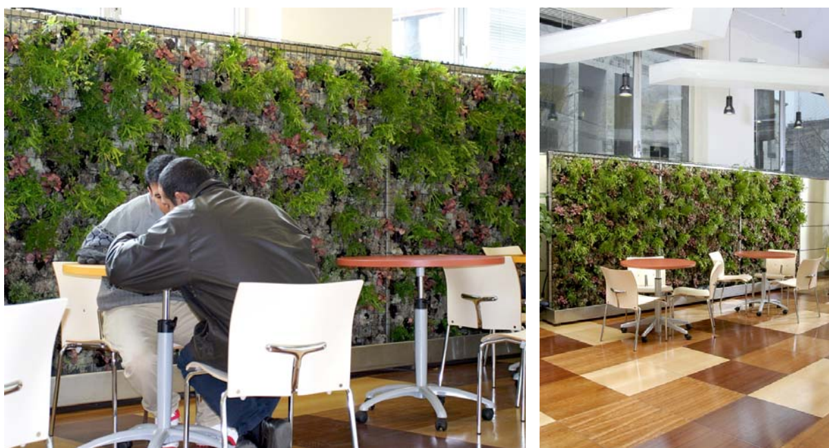
Fig.V.59 – Albero Monti & Associati, Palazzo della Provincia di Milano , 2004. Esempio di muro vegetale eseguito in modo artigianale: l'installazione consta di un'anima in grigliato metallico contenente substrato; le specie vegetali sono erbacee e tappezzanti. Alla base della parete è visibile una vasca d'acqua che funge da serbatoio per la soluzione idrosalina: il sistema nutrizionale consiste quindi in una fertirrigazione a circuito chiuso. (Fonte: Nicolas Monti)
