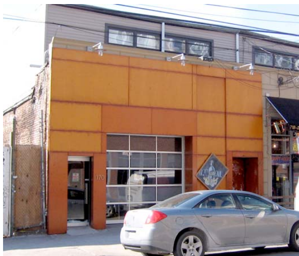
Fig.V.95 – A sinistra. L' Oulu Bar di New York (USA), inizialmente inverdito mediante un sistema vegetale monospecie, dopo meno di un anno dal completamento dei lavori presentava la morte dell'intero apparato a verde (si veda in Fig.IV.28 la foto del medesimo quando la vegetazione era in vita). La componente vegetale esposta a Nord è deceduta probabilmente a causa di un'erronea selezione dei vegetali.
