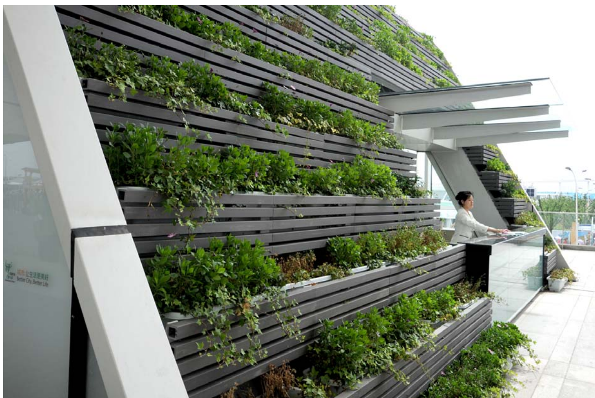
Fig.III.42 – Expò di Shanghai 2010, Info Point . La verticalizzazione vegetale verrà in questo caso ottenuta mediante una serie di vasi in quota e degradanti in altezza, dove trovano dimora delle specie vegetali a portamento decombente. (Fonte: Giovanni Zannoni)
