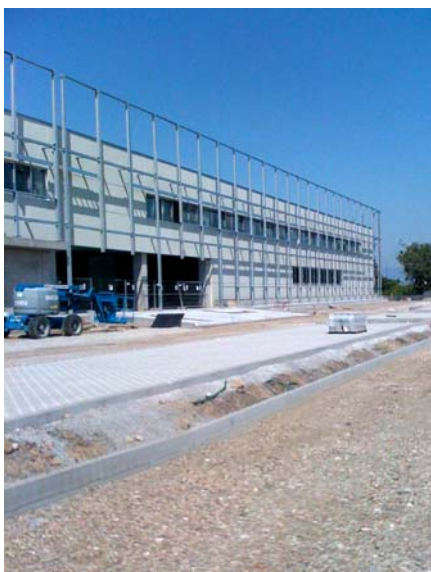
A sinistra: vista del reticolo strutturale in acciaio zincato durante le fasi di montaggio. A destra: dettaglio delle mensole metalliche per il supporto dei vasi sospesi contenenti i rampicanti.
