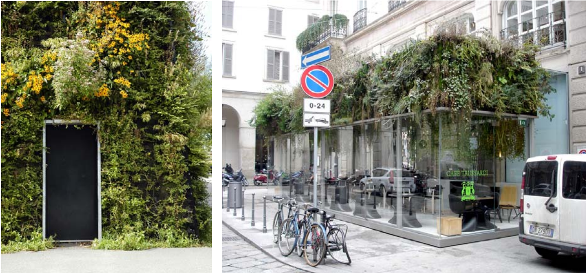
Fig.V.77 – A sinistra. VenhoevenCS, Sportplaza Mercator , Amsterdam (Paesi Bassi), 2006: particolare di una porta. Una semplice scossalina in acciaio zincato a caldo funge da elemento separatore tra vegetazione e serramento. Interessante da notare anche la rigogliosità vegetale: la foto è stata scattata in data 30/08/2009, quindi le piante si trovavano in piena attività vegetativa. Si veda la contestuale Scheda Progetto al paragrafo V.3. (Fonte: Giovanni Avosani)
