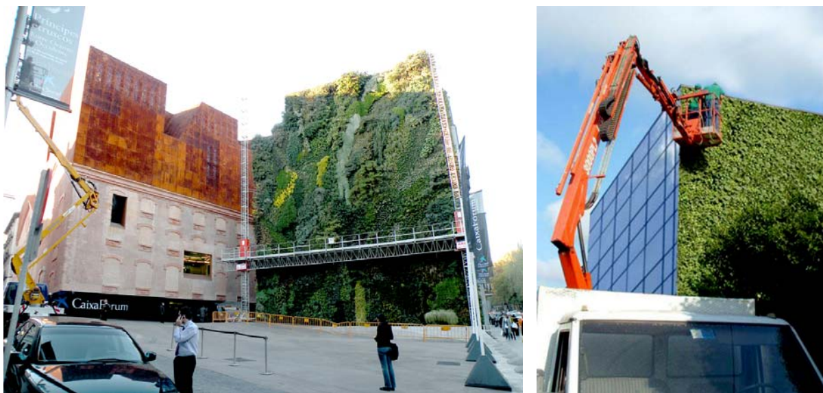
Fig.V.85 – A sinistra. Herzog & de Meuron, Patrick Blanc: Caixa Forum , Madrid (Spagna), 2007. Nella parte bassa della parete a verde è possibile vedere il ponteggio elevatore non permanente: esso permette sia le operazioni d'impianto manuale dei vegetali che le attività manutentive. Tale struttura viene montata e smontata all'occorrenza, quindi più volte all'anno. (Fonte: Valeria M. Rocco)
