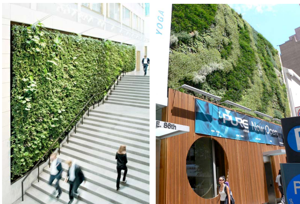
Fig.VII.29 – A sinistra. Green Fortune, Muro vegetale presso il Stockholm City Office , Stoccolma (Svezia) 2010. La chiusura vegetata è stata installata su una parete pre-esistente durante alcuni lavori di ristrutturazione edilizia. (Fonte: http://www.greenfortune.com )
