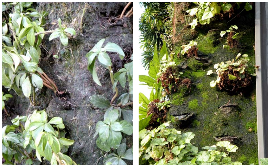
Fig.V.3 – Patrick Blanc, due esempi di Mur Vegetal : dettaglio del substrato d’impianto ottenuto con un doppio feltro in poliammide sintetica. Nell’immagine di sinistra è rappresentato il Caixa Forum di Madrid poco dopo l’inaugurazione avvenuta nel 2007; a destra è invece raffigurato l’ Athenaeum Hotel di Londra dopo circa due anni dal completamento. In quest’ultima sono ben visibili i fusti delle piante e le radici del vegetale (in colore chiaro) che si integrano completamente alla superficie del feltro, penetrandolo ed attraversandolo in tutte le direzioni. A destra si può notare la conformazione delle sacche per l’alloggio dei vegetali, e la loro scansione spaziale. Confrontando le due foto è visibile come, col trascorrere del tempo, le colonie vegetali tendano a invadere la superficie del substrato sintetico, naturalizzandolo. (Fonte: Valeria M. Rocco)
