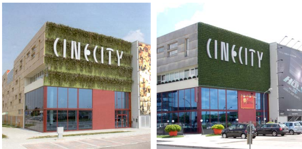
Fig.III.63 – Andrea Viviani, CinéCITY Multiplex , Limena (PD), 2005: confronto tra due immagini dell'edificio nelle annate 2005 (a sinistra) e 2008. La facciata principale, originariamente rivestita mediante piante di gelsomino decumbenti (foto di sinistra; fonte: BELLINI, OSCAR E., DAGLIO, LAURA, Verde Verticale , in bibl., p.240), è stata sostituita con un'edera sintetica in seguito alla morte dei vegetali (a destra). Le ragioni del decesso sono presumibilmente da imputarsi alle alte temperature del contesto d'impianto causate dall'esposizione a Sud-Ovest della facciata, unitamente al calore re-irradiato del grande parcheggio asfaltato antistante l'edificio.
