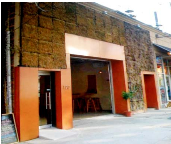
Fig.V.95 – A sinistra. L' Oulu Bar di New York (USA), inizialmente inverdito mediante un sistema vegetale monospecie, dopo meno di un anno dal completamento dei lavori presentava la morte dell'intero apparato a verde (si veda in Fig.IV.28 la foto del medesimo quando la vegetazione era in vita). La componente vegetale esposta a Nord è deceduta probabilmente a causa di un'erronea selezione dei vegetali.
