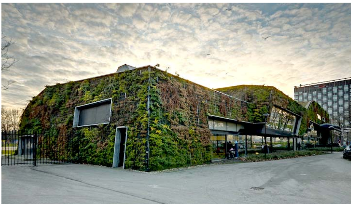
Fig.VII.21 – VenhoevenCS, Sportplaza Mercator , Amsterdam (Paesi Bassi), 2006: vista da Nord-Est. L'involucro edilizio è completamente vegetato mediante l'impiego combinato di tecnologie per la realizzazione di muri vegetali e di coperture a verde estensivo. Si veda la contestuale Scheda Progetto al paragrafo V.3. (Fonte: http://pouhou.aminus3.com/image/2009-01-18.html )
