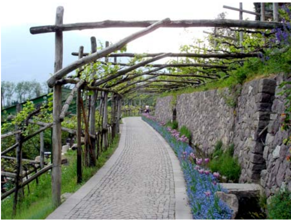
Fig.II.14 – A sinistra: pergola avente la funzione di ombreggiare un percorso pedonale presso i Giardini di Castel Trauttmansdorff a Merano (BZ). La tecnologia costruttiva è quella tradizionale: tronchi di legno per la realizzazione di strutture orizzontali o verticali, destinati ad ospitare la crescita della vegetazione.
