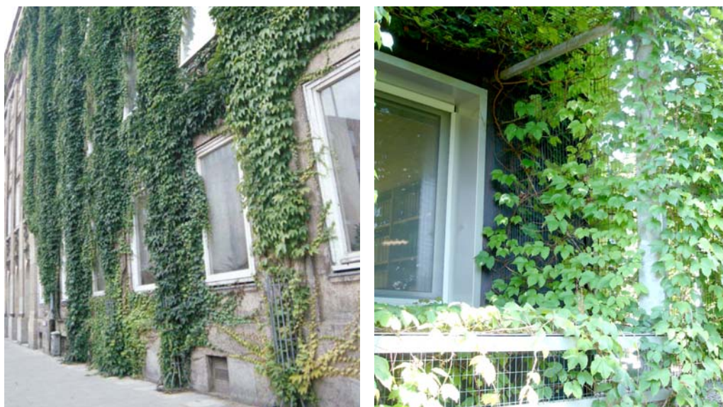
Fig.III.57 – A sinistra. Esempio di attacco a terra in ambito urbano: ai piedi degli esemplari di vite vergine sono visibili gli elementi metallici per la protezione del fusto della pianta, fino ad un'altezza di circa 2 m. dal piano stradale. Si noti anche come il rivestimento venga potato in prossimità delle finestre, per lasciare che la luce naturale possa penetrare liberamente negli ambienti interni. (Fonte: Marco Devecchi)
