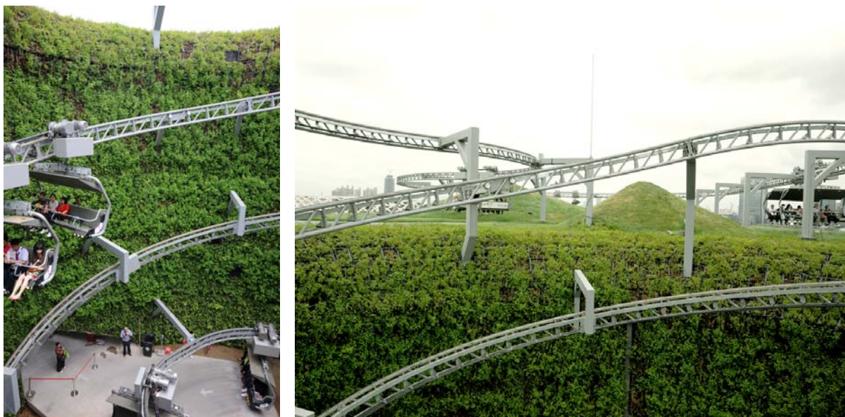
Fig.VII.22 – Buchner & Bründler, padiglione svizzero presso l'Expo di Shanghai 2010. La continuità tra i prospetti interni e la copertura a verde del padiglione crea un unicum materico e formale. I due sistemi tecnologici (chiusura verticale e superiore) presentano comunque tecnologie differenti: le pareti inverdite sono realizzate tramite un sistema modulare prevegetato, mentre la copertura praticabile consta di un sistema d'inverdimento semi-intensivo. (Fonte: Giovanni Zannoni)
