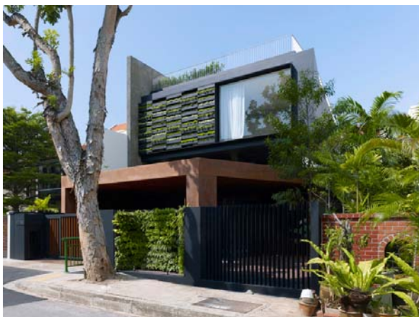
Fig.III.91 – Formwerkz Architects, Maximum Garden House , Singapore, 2010. Al secondo piano, in corrispondenza della camera padronale, è presente una facciata a verde finalizzata alla schermatura solare. Tale frangisole, posizionato davanti ad una grande chiusura trasparente ubicata nel bagno (foto di destra), è ottenuto mediante fiorire equidistanti in altezza e contenenti specie decombenti. (Fonte: http://www.archdaily.com )
