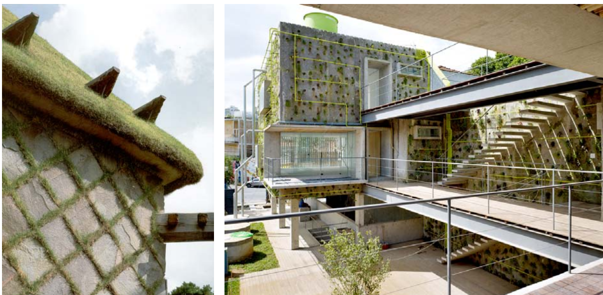
Fig.V.49 – A sinistra. Terunobu Fujimori, Tsubaki Castle , Tokyo: dettaglio della connessione fra chiusura verticale e superiore. Le fughe inclinate del rivestimento in pietra e il tetto a padiglione dell’edificio sono vegetati mediante un manto erboso piantato dopo la chiusura del cantiere edilizio. (Fonte: LAMBERTINI, ANNA, Giardini in verticale , in bibl., p.154)
