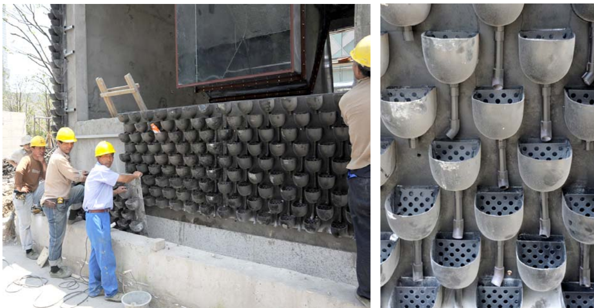
Fig.V.30 – Esempio di sottosistema di supporto alla vegetazione in materiale polimerico. È composto da pannelli modulari di grandi dimensioni, che inglobano in superficie dei contenitori per l'alloggio di substrato e piante. Come visibile, nella parte bassa di ogni contenitore è presente un tubicino per consentire la percolazione dei liquidi d'irrigazione verso i vasi sottostanti. Questo sistema è quindi concettualmente simile a quello inventato da Patrick Blanc, e ne differisce sostanzialmente solo nel materiale. Inoltre, il polimero che lo compone funge, se ben realizzato, sia da elemento di tenuta che antiradice. (Fonte: Giovanni Zannoni)
