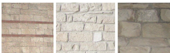
Fig. 4.8 Murature sbazzate di Limassol - Cipro: elementi pseudo regolari con e senza ricorsi in laterizio
