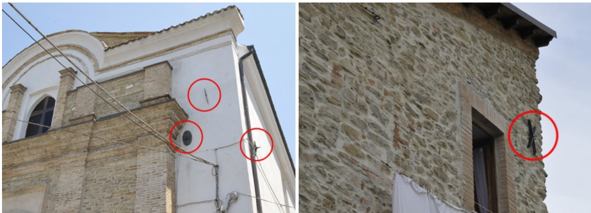
Fig. 4.45 Arsita (TE): i capochiavi testimoniano la presenza di tirantature (Fotografie: ENEA C. R. Bologna)
