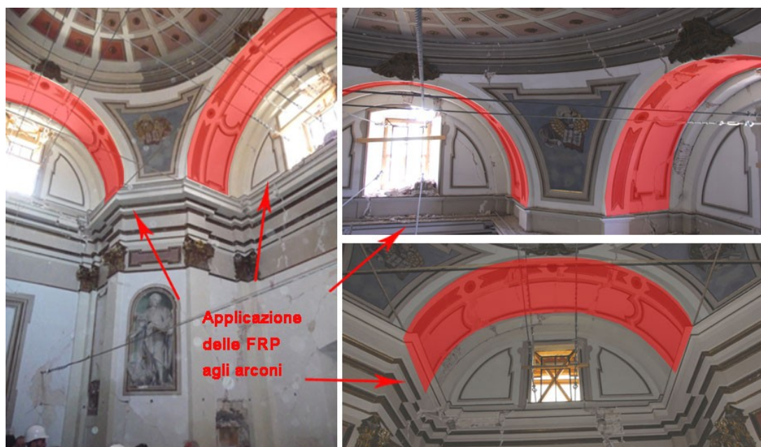
Fig. 6.28 Ipotesi di rinforzo con FRP (Fotografie: Il Cenacolo S.r.l.)
