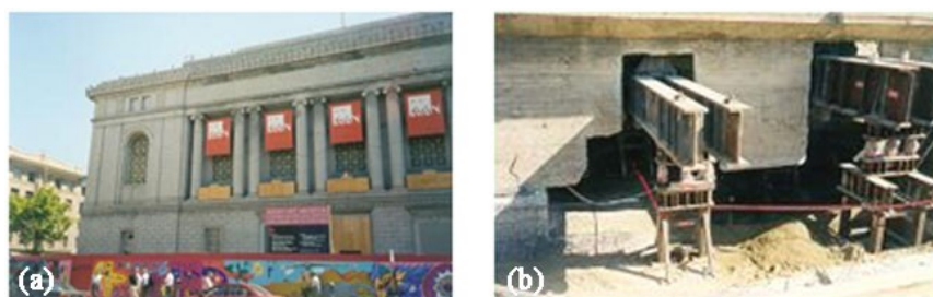
Fig. 5 (a) The Asian Art Museum at San Francisco (USA), (b) Dettaglio fondazioni: inserimento isolatori, (in Indirli, Martelli, 2009)
