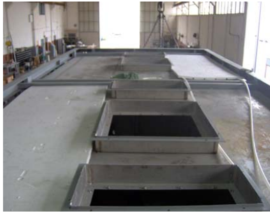
Figura 6.4: Posizionamento dei circuiti sopra al soffitto.
