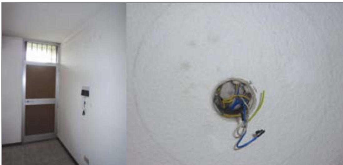
Figura 5.6. – Vista dell'ingresso dell'unità abitativa Tipo A del piano primo, dove l'impianto elettrico è stato oggetto di integrazioni con canalizzazioni esterne che hanno sostituito quelle annegate nel getto del Tunnel.
