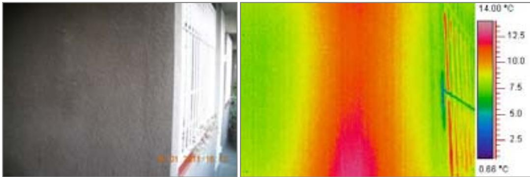
Figura 6.11. - Immagini di rilevamento del Virgolone - Ponte termico d'angolo Unità tipo A3. Ballatoio del piano primo
