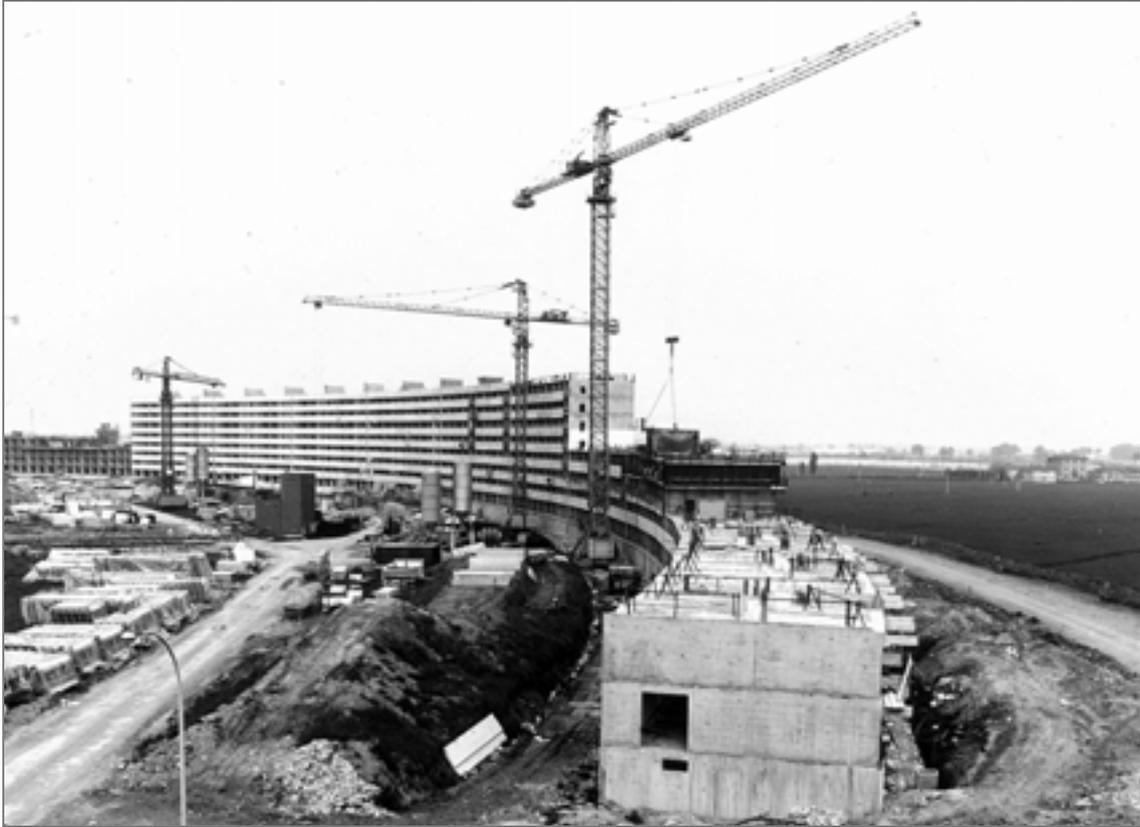
Figura 3.5. – Fasi di cantiere dell'edificio Virgolone realizzato con struttura a Tunnel. Quartiere Pilastro. Archivio Acer Bologna.
