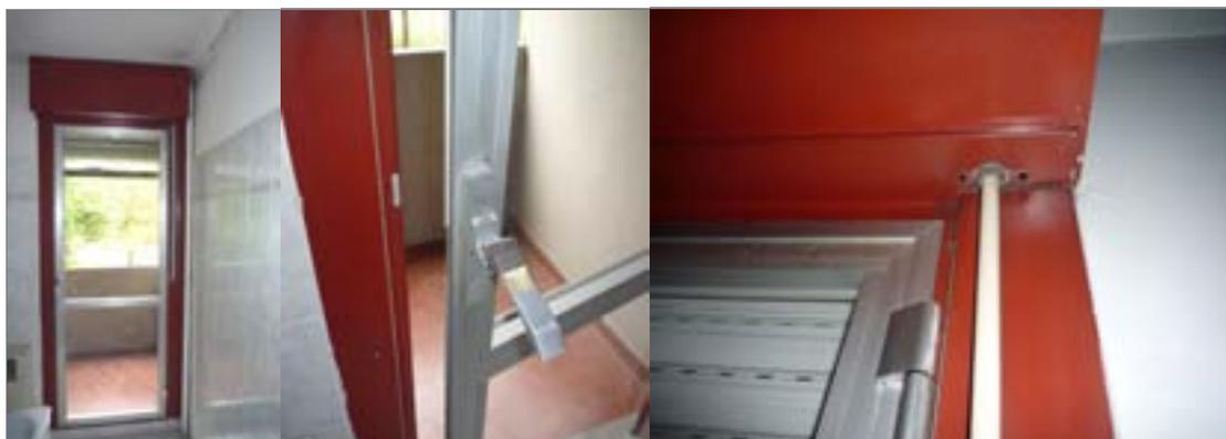
Figura 5.3. - Serramento tipo con profili in alluminio e vetro singolo. Il sistema di oscuramento avviene attraverso sistema avvolgibile.
