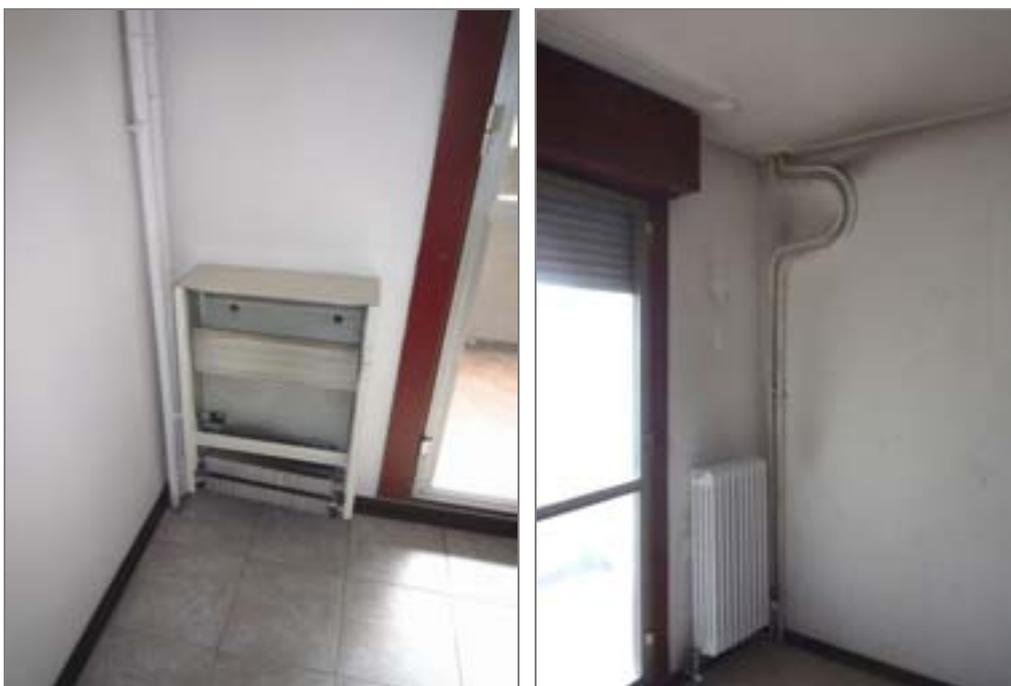
Figura 5.7. - Terminali dell'impianto di riscaldamento all'interno delle unità abitative costituiti da termoconvettori e radiatori alimentati da colonne montanti verticali.
