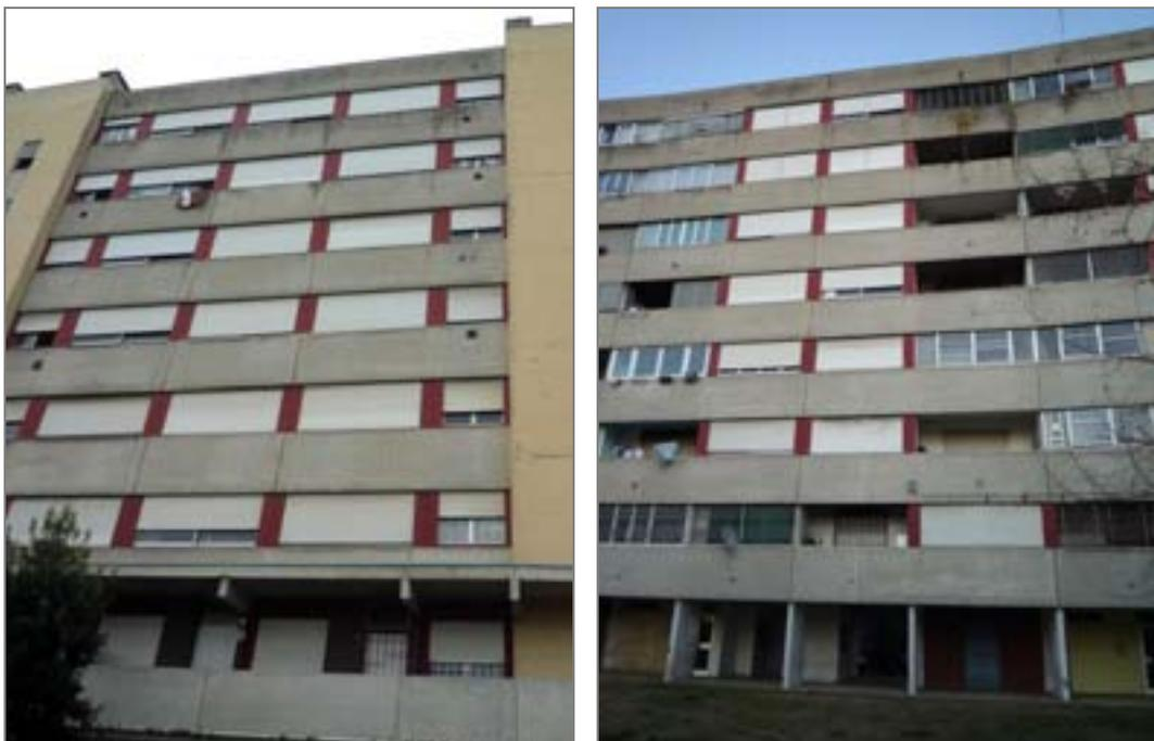
Figura 8.2. – Si nota come nel fronte nord (prima immagine) l'involucro termico è definito dal tamponamento in c.a. e dall'infisso, mentre nel fronte sud dal tamponamento in laterizio all'interno della loggia. Sono evidenti inoltre i tentativi individuali di chiusura delle logge.
