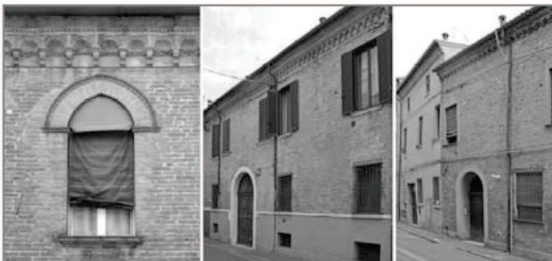
Fig. 23. Ferrara, esempi di qualificazione del fronte mediante caratterizzazione del componente del linguaggio edilizio corrispondente alla connessione tra parete e copertura.
