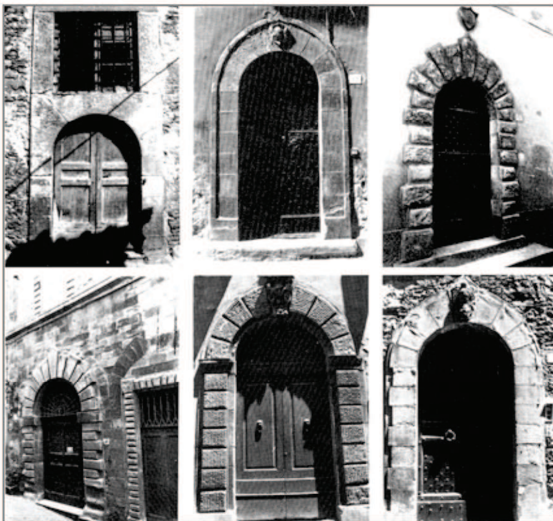
fig. 11. Cortona, campionamento fotografico delle bucatore di passaggio lavoranti per forma, differenziate per diversa conformazione e reciprocità tra arco e piedritti: 1) accentuazione dei conci d'arco, 2) continuità dei conci con rinforzo rigirante e chiave, 3) continuità dei conci senza accentuazione delle parti, 4) continuità dei conci e accentuazione dell'appoggio al piedritto, 5) continuità dei conci e specificazione del piedritto e della chiave, 6) continuità dei conci e specificazione della sola chiave. Immagini tratte da AA.VV., Cortona struttura e storia. Materiali per una conoscenza della città e del territorio , Arezzo 1987, pp. 336-337.
