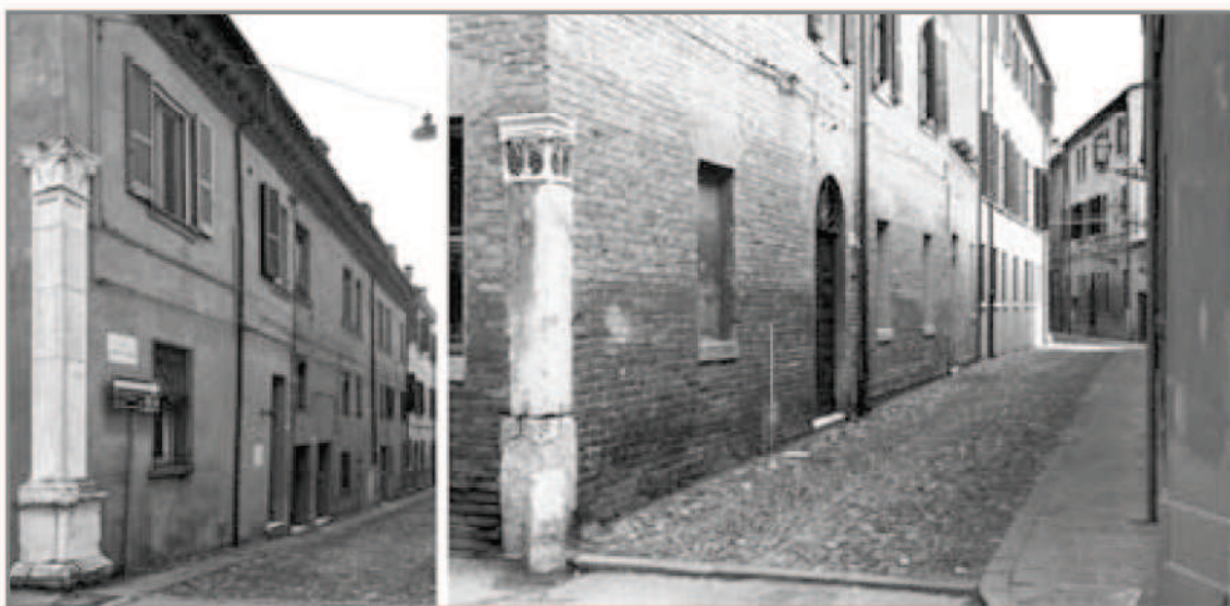
Fig. 1. Ferrara, esempi di mediazione per codificazione architettonica nella connessione tra pareti ortogonali.
