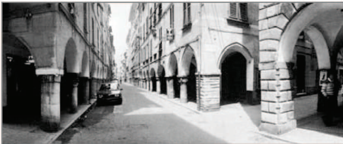
fig. 13. Chiavari, veduta dei portici del Carrugio dritto: la successione di pilastri ed archi determina la continuità formale delle pareti stradali. Immagine tratta da M. D. Brambilla, M. Gallarati, Linguaggio edilizio ed immagine urbana a Chiavari , Genova 1983.
