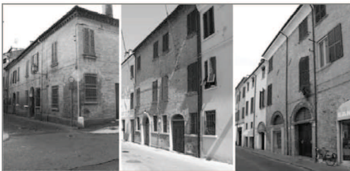
Fig. 12. Ferrara, prevalenza di strutture orizzontali lavoranti per forma di arco a tutto sesto nelle bucatore di passaggio.
