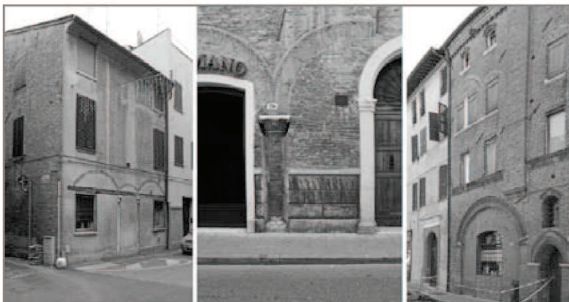
Fig. 28. Ferrara, esempi di strutture porticate nell'edilizia di base.
