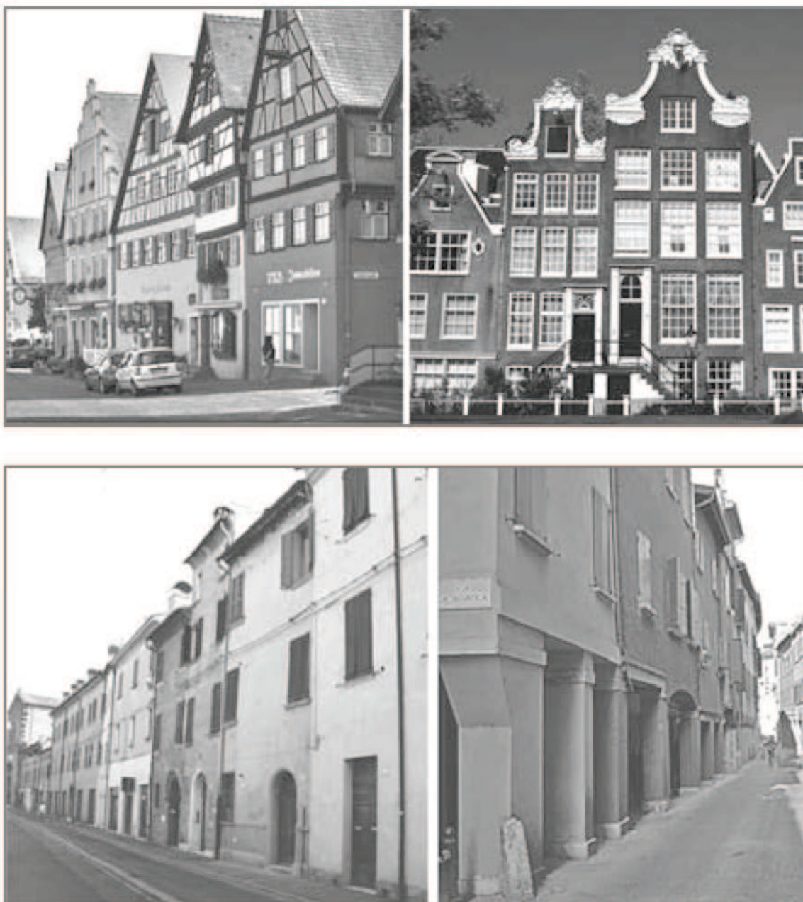
fig. 1. Linguaggi edilizi caratterizzati da specifici impieghi di materiale e da soluzioni tecnologiche e costruttive tipiche. Sopra, vocazione elastico-lignea di area nord europea: sistemi costruttivi a "graticcio" a Dinkelsbuehl (Baviera) e intrusione degli stilemi derivati da area plastico-muraria a Begijnhof (Amsterdam). Sotto, vocazione plastico-muraria padana: il tessuto compatto di Ferrara caratterizzato dall'uso di elementi decorativi in terracotta e tipicità della struttura porticata dell'edilizia bolognese.
