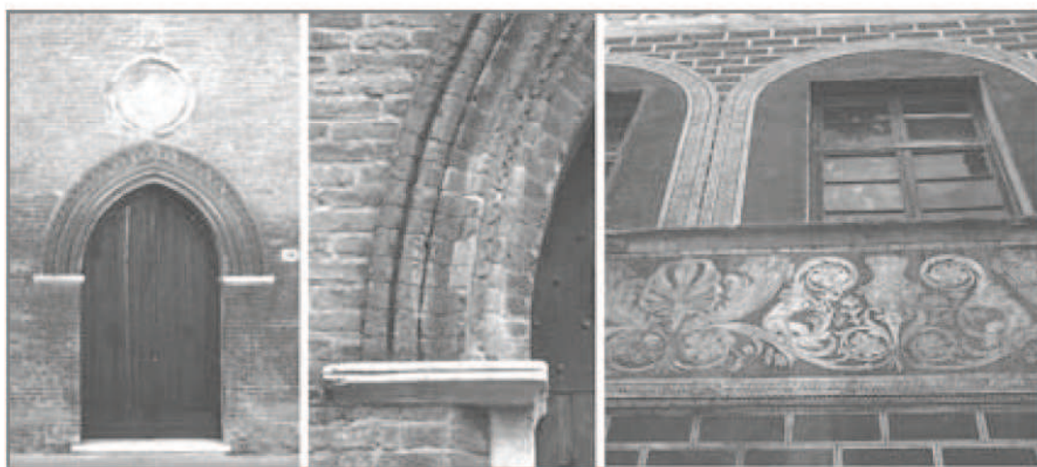
fig. 3. Esempi di mediazione linguistica per caratterizzazione locale: terrecotte ferraresi (Casa del Sale, XIV secolo), facciata graffita fiorentina (palazzo Coverelli, 1450-1475).
