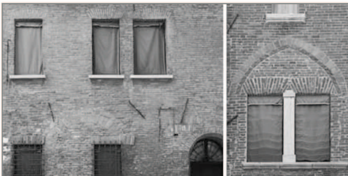
Fig. 17. Ferrara, esempi del processo di modificazione delle bucaure di affaccio leggibile sul fronte faccia a vista.
