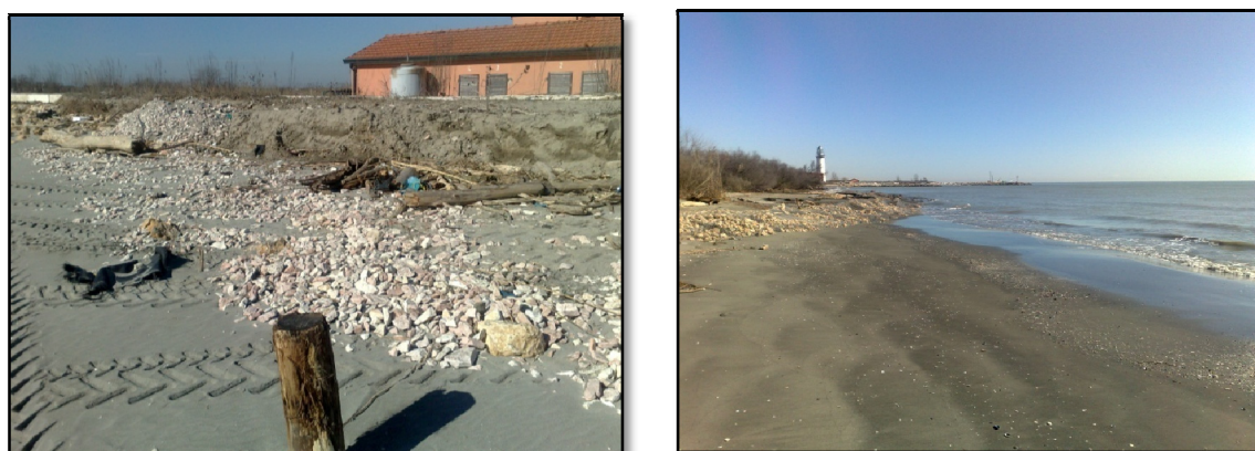
Figura 201 – prospettive della condizione morfologica nella quale si trova oggi la duna in corrispondenza del faro di Gorino (FE).
