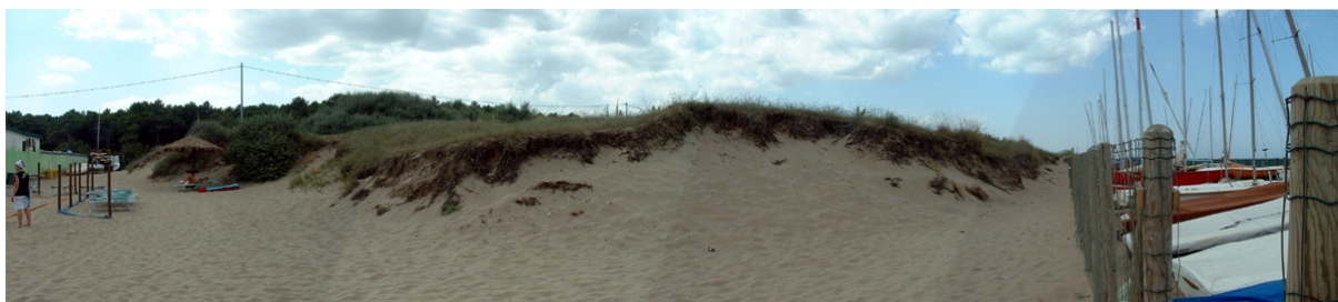
Figura 92 – Particolare di duna a Punta Marina (Ravenna) che mette in risalto come gran parte di quelle che si sviluppano in questo settore, risultino oggi estremamente frammentata, a causa dei numerose strutture che ne frammentano di netto l'estensione longitudinale - Lido di Classe (Ra).
