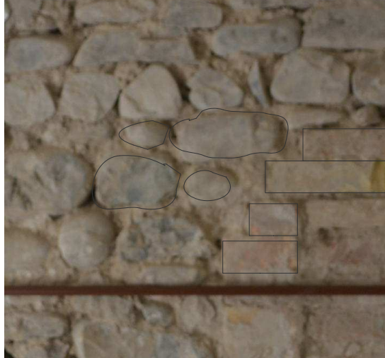
Immagine 70: immagine fotografica dopo la demolizione dell'intonaco
