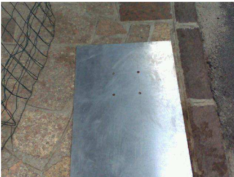
Immagine 25: Pannello in acciaio inox con fori passanti
