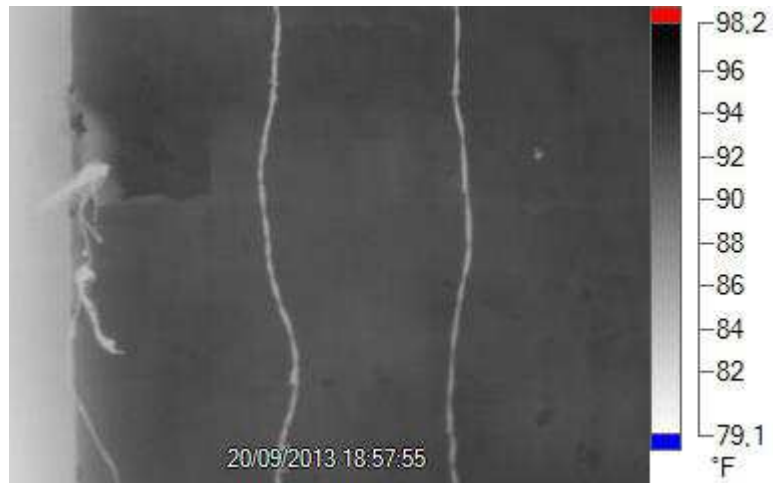
Immagine 67: immagine termica ibrida con strutture portanti (travi-pilastri).
