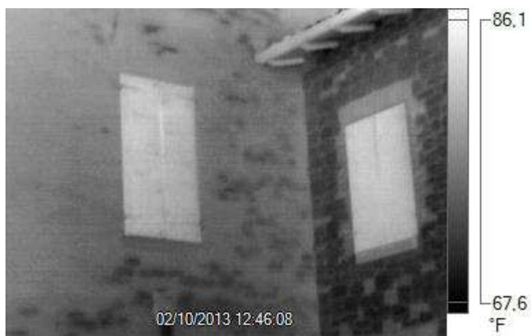
Immagine 74: immagine termica di edificio di impianto romanico
