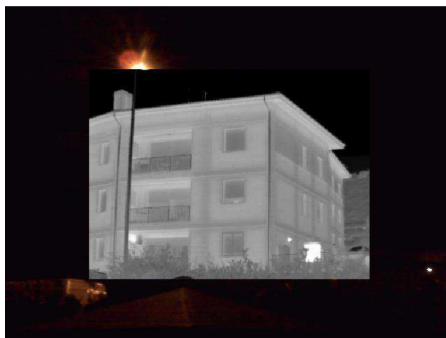
Immagine 66: immagine termica ibrida con strutture portanti (travi-pilastri).
