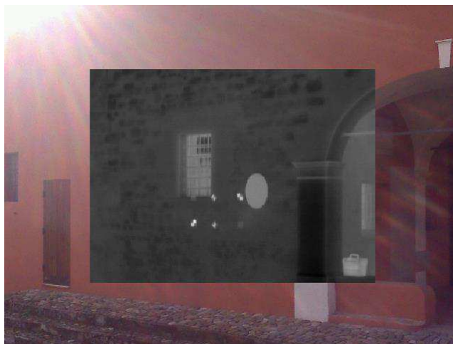
Immagine 80: immagine ibrida fotografica termica di edificio di impianto romanico
