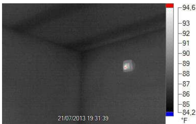
Immagine 65: immagine termica con travetti prefabbricati.
