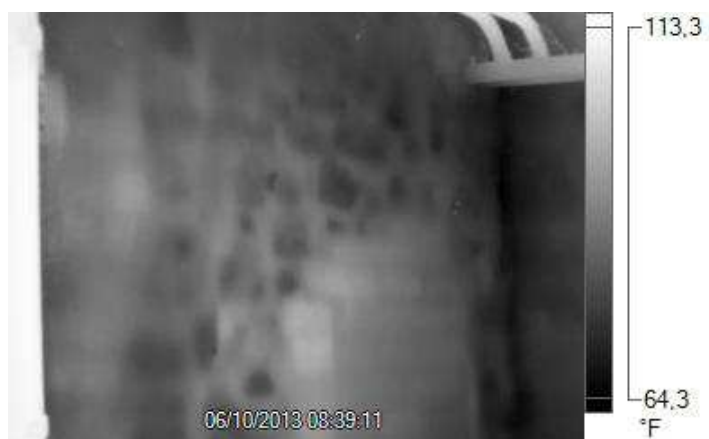
Immagini 57: porzione di parete intonacata in immagine termica.
