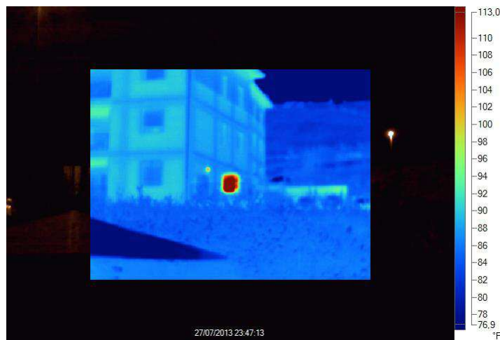
Immagini 56: porzione di edificio in rilievo notturno.
