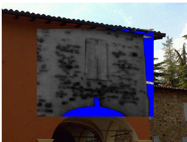
Immagine 76: immagine ibrida fotografica termica di edificio di impianto romanico
