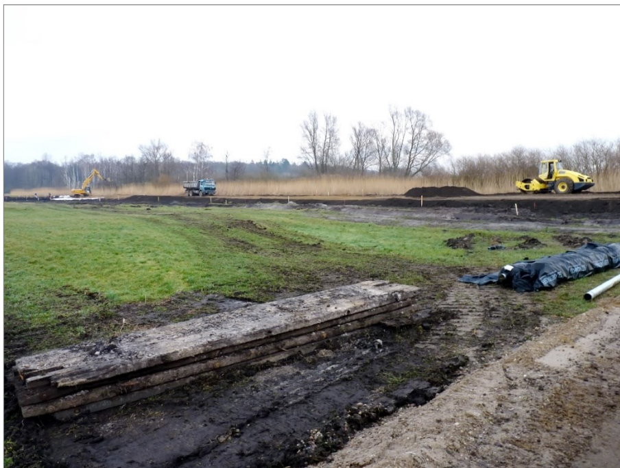
Figura 2: Costruzione di argini con materiale dragato (Körkwitzer Bach nel 2014), ( http://www.dredgedikes.eu/en/dredgedikes-pilot-dike-completed-3732 )
