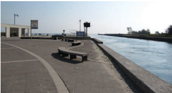
Passeio pedonal ao longo do canal do porto
