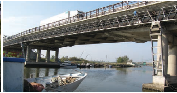
Ponte da estrada SS 309 "Romea"
