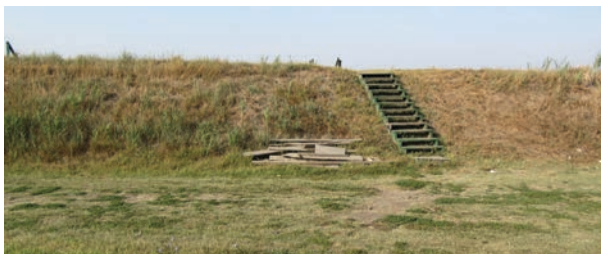
Terraplanagem do canal navegável
