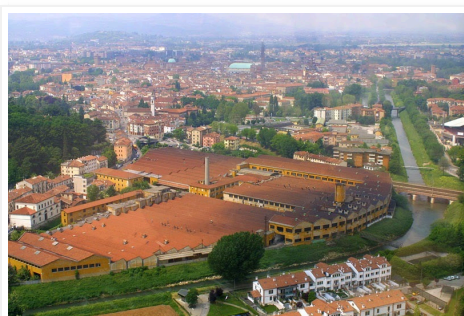
PIRUEA Ex Cotorossi: veduta aerea prima della demolizione fonte: Comune di Vicenza, Forum Center
