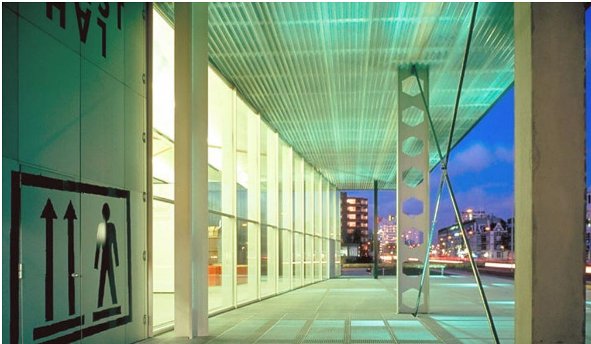
Figure 27 - Kunsthal Rotterdam, three columns [28]
