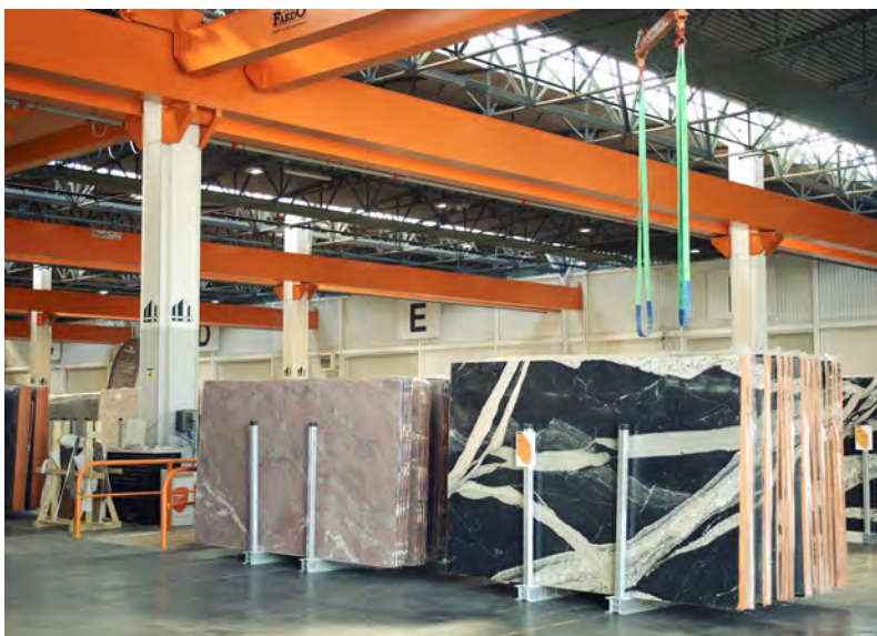
Stabilimento per lo stoccaggio di lastre di marmo a Gambellara (VI).
