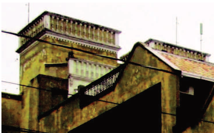
Figura 4.35 – Hotel em São Francisco do Sul (Brasil). Detalhe.
