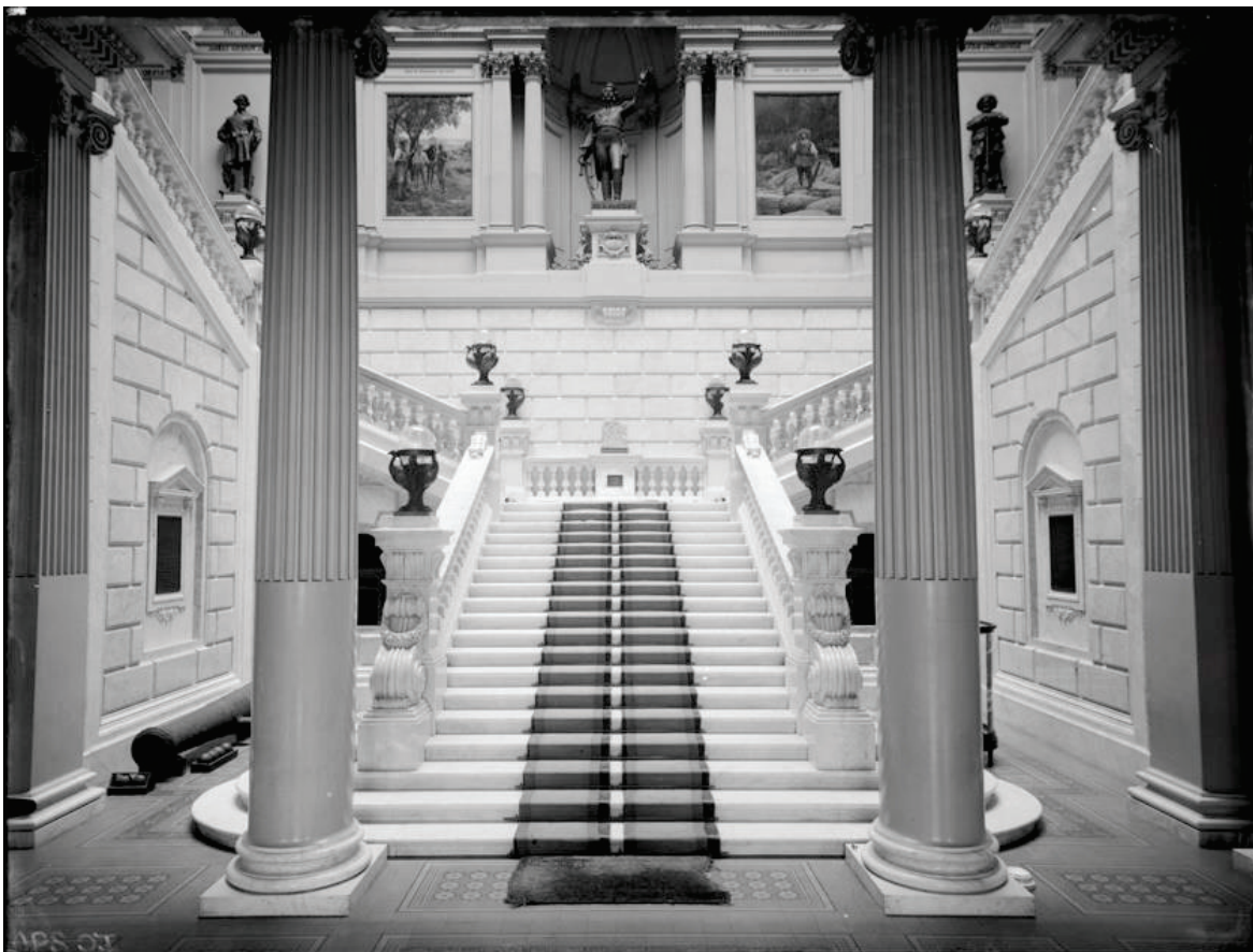
Figura 1.12. Escadaria monumental em mármore, adornada com ânforas, esculturas e quadros, que guiam os visitantes até o pavimento superior. A iluminação indireta se dá pela claraboia sobre a escadaria, contornada por sanca de telas dos artífices da Independência.
