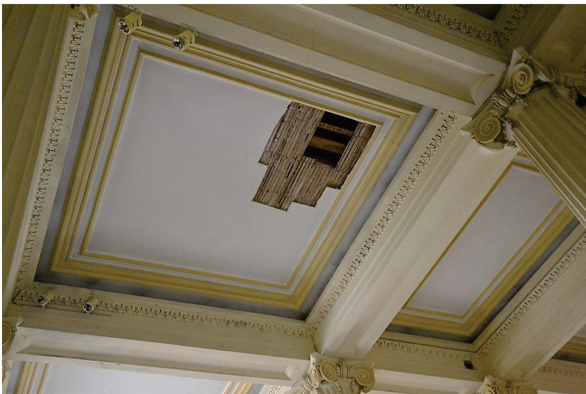
Figura 2.15. Janela de prospecção no forro do Saguão de Entrada do edifício-monumento para investigação das soluções estruturais.
