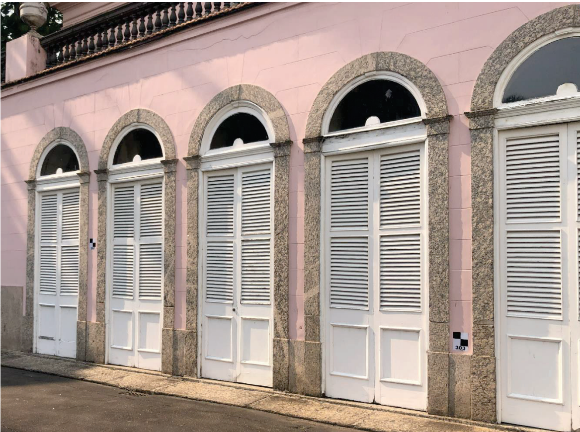
Figura 3.58. Registro dos trabalhos em campo de levantamento métrico-arquitetônico do Complexo do Itamaraty. Distribuição dos alvos quadriculados na superfície de uma das fachadas do Palácio.
