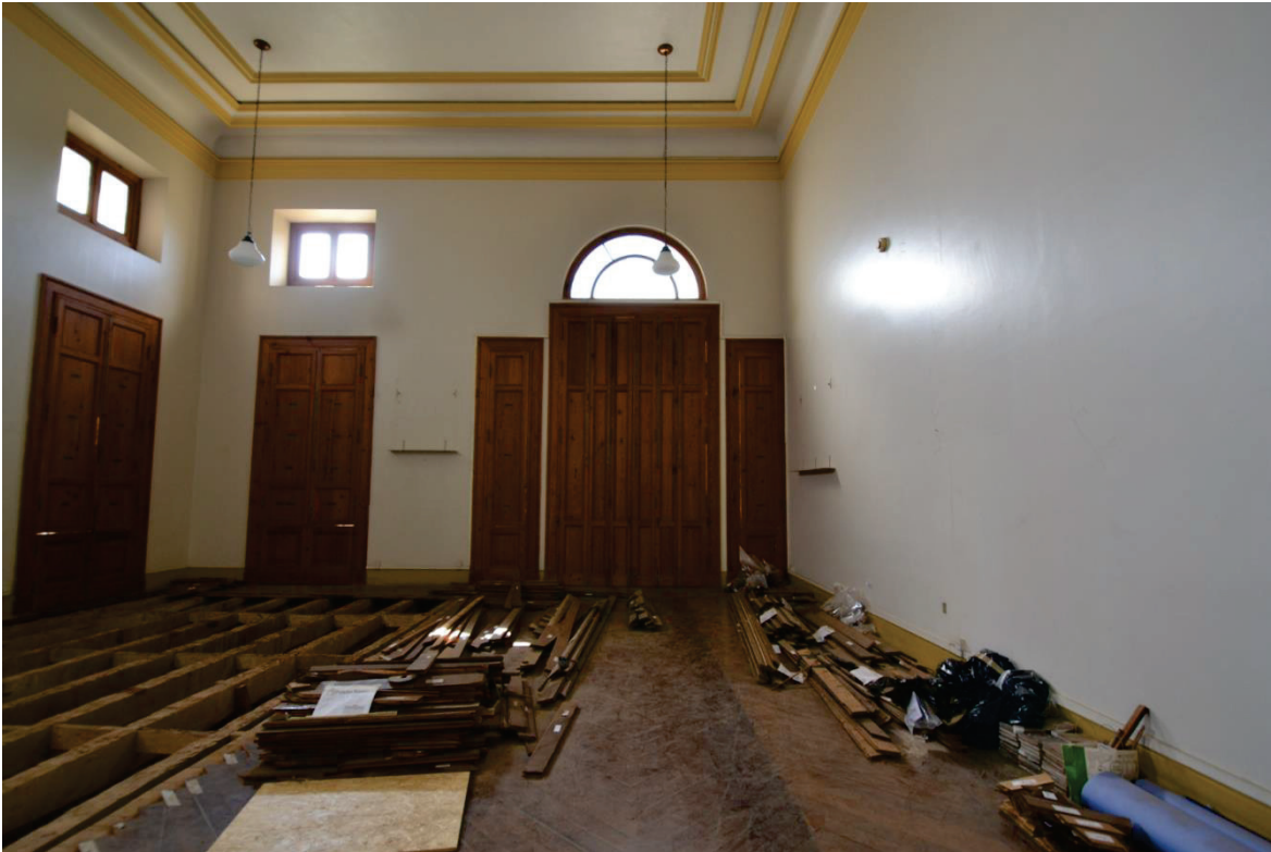
Figura 2.18. Assoalho e contrapiso desmontados em uma das salas do primeiro pavimento, na torre leste do edifício. Barrotes e estrutura de sustentação do forro encontram-se expostos. À direita, as peças catalogadas sem qualquer tipo de proteção ou guardadas em sacos plásticos, podendo levar à criação de bioclimas de elevada umidade ou à contaminação por insetos xilófagos.
