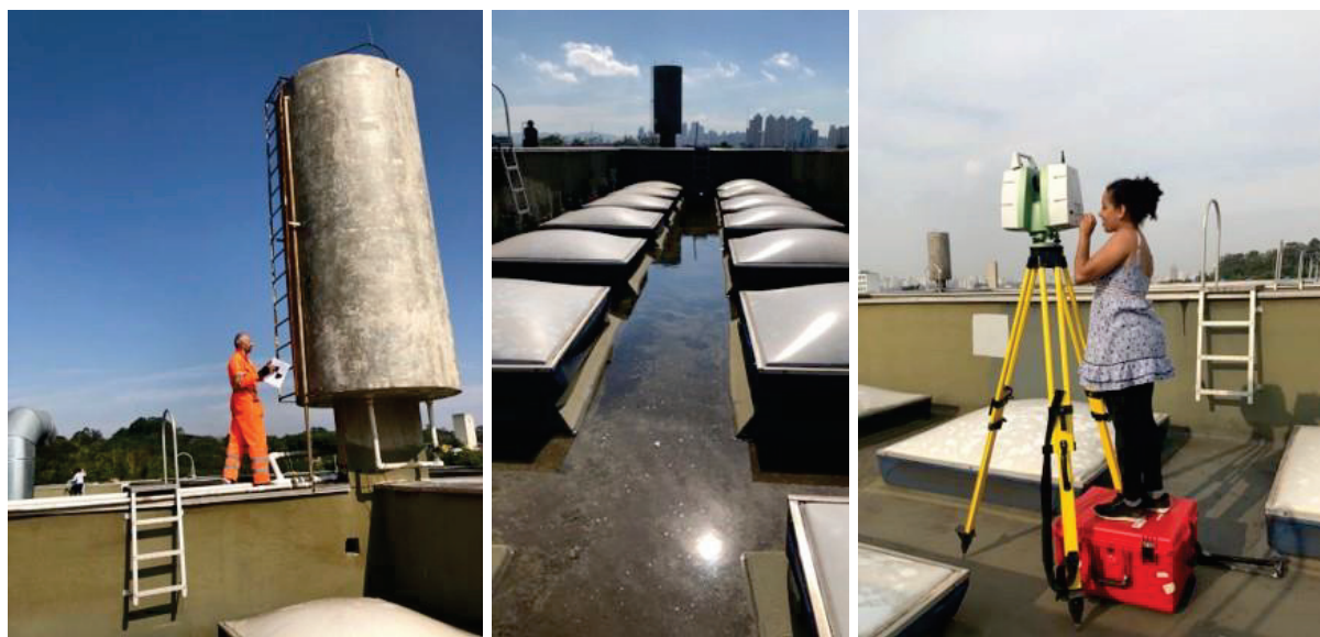
Figura 3.44 a 3.46. Da esquerda para a direita: posicionamento dos alvos, inclusive nas superfícies dos reservatórios; acúmulo de águas pluviais e matéria orgânica sobre as lajes de parte dos módulos; e adaptação da estação de varredura para acesso ao aparelho.
