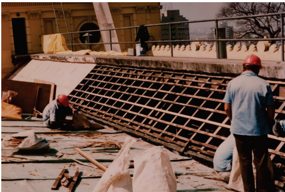
Figuras 1.26 a 1.28. Obras na cobertura, com substituição das chapas de cobre e reparos na estrutura da claraboia central sobre a escadaria monumental.
