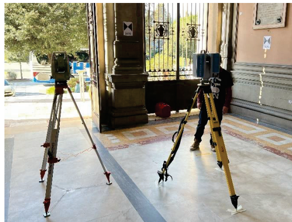
Acima: Levantamento topográfico para obtenção das coordenadas geográficas dos pontos de controle na linha de referência local.
