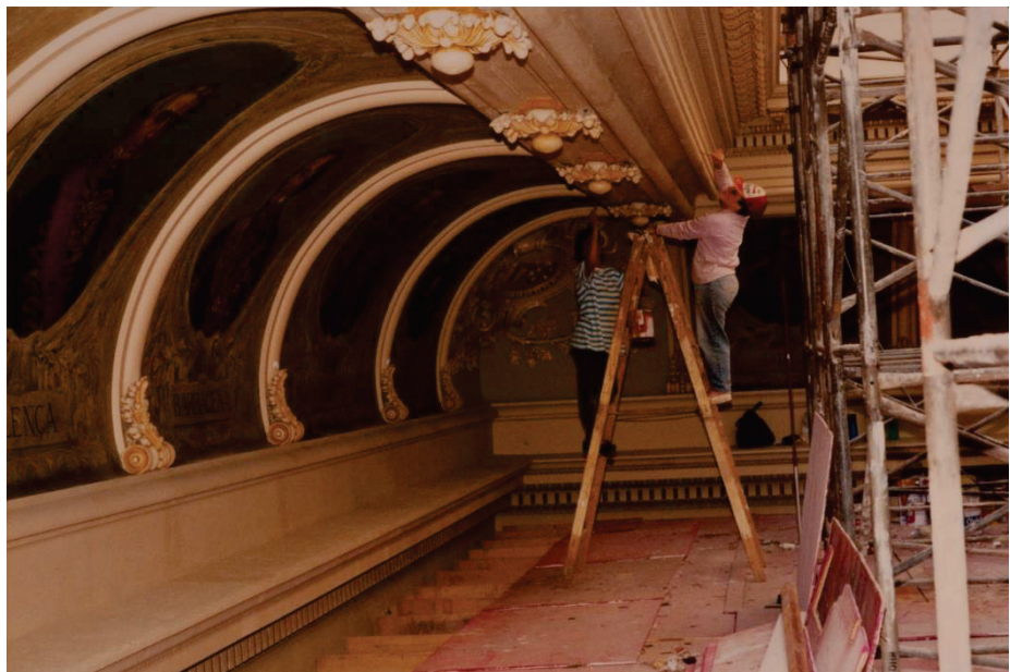
Figuras 1.24 e 1.25. Campanha de restauro das pinturas nas sancas em torno da escadaria monumental do edifício. Colocação de andaimes para acesso às obras e claraboia de vidro.
