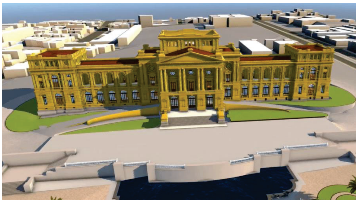
Figura 3.28. Visualização do modelo HBIM do Museu do Ipiranga. O modelo foi realizado a partir dos dados de escaneamento a laser e fotogrametria aérea, em 2019, para ser utilizado como gêmeo digital do edifício-monumento.
