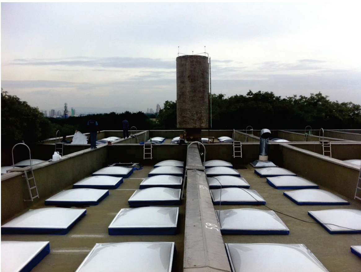
Figura 3.41. Vista de trecho da cobertura do edifício Vilanova Artigas após intervenção de 2015. Na imagem, centralizada entre dois módulos, identifica-se o reservatório de água, além do sistema de rufos e de circulação sobre as vigas invertidas.
