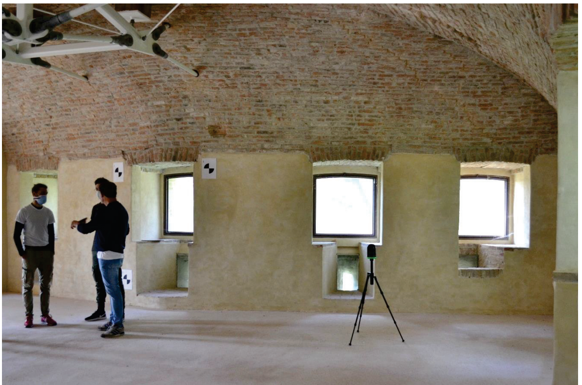
Figura 3.64. Escaneamento a laser das áreas internas da Rocca Possente, durante aulas em campo dos cursos de Levantamento Arquitetônico e Técnicas de Representação do Departamento de Arquitetura da Universidade de Ferrara.
