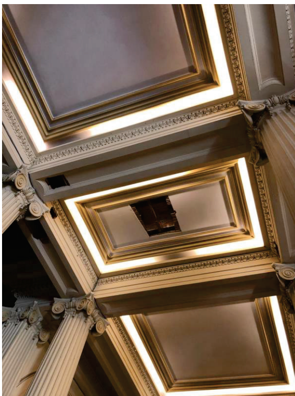
Figuras 2.16 e 2.17. Aberturas em diversos trechos dos forros do Saguão de Entrada, ainda expostos cerca de um ano após a conclusão das investigações para o diagnóstico estrutural do edifício.
