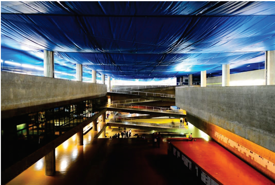
Figura 3.32. Vista interna do edifício com instalação de lonas de proteção em toda a extensão da cobertura.
