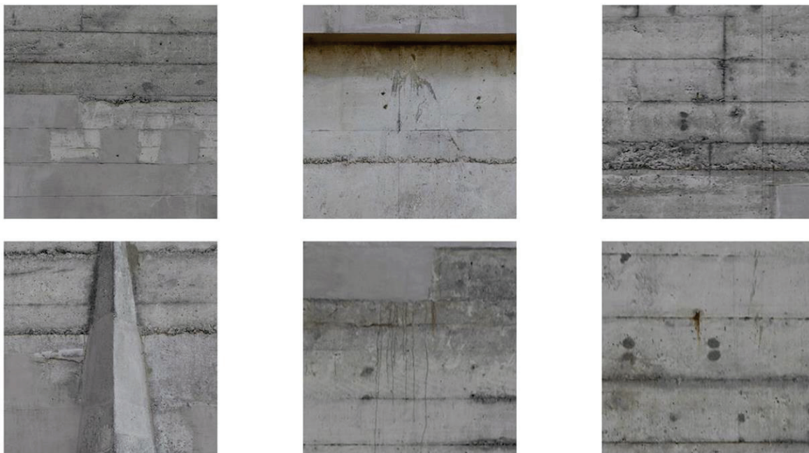
Figura 3.40. Ábaco fotográfico de danos e alterações identificados através de investigação visual macroscópica.
