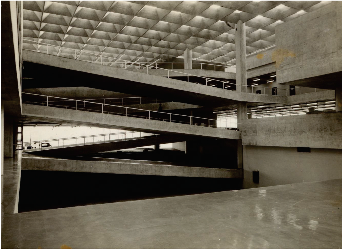
Figura 3.30. Distribuição dos patamares em meios-níveis, conectados por extensas rampas. Na imagem vê-se a ampla cobertura que permite a entrada de luz natural, distribuída por todo o edifício.
