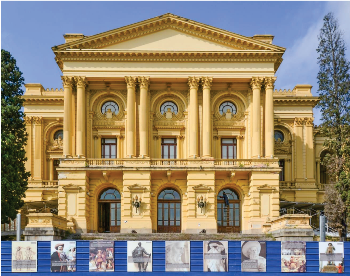
Figuras 2.23 e 2.24. Fotos retificadas da fachada do Corpo Central do Museu.
