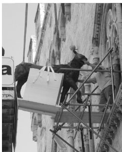
07 Movimentazione del Grifo perugino duecentesco tramite imbracatura e castelletto ligneo provvisorio. Perugia, Palazzo dei Priori, 2004
