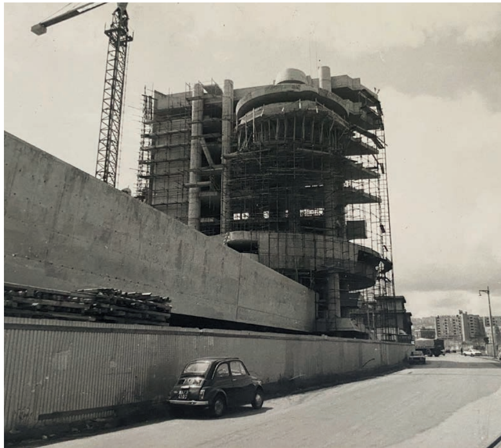
Fig.7 - Vista da nord-est della Casa del portuale a seguito della costruzione delle parti strutturali e precedente all'aggiunta del curtain wall (Archivio dell'Università degli Studi di Napoli Federico II, sez. Architettura e Ingegneria, Fondo A.L. Rossi, Impresa Salvatore Penta, 1979)
