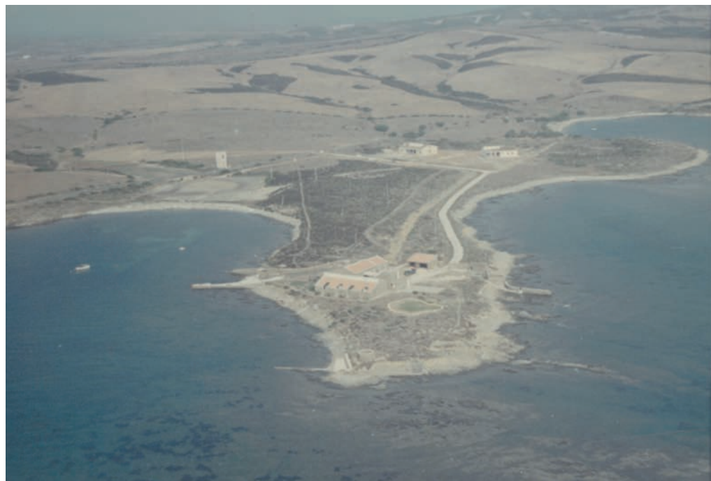
Fig.1 - La casa Di Palma in costruzione e il contesto. Centro di Alti Studi sulle Arti Visive (d'ora in poi CASVA), Milano. Archivio professionale architetto Fredì (Alfredo) Drugman
