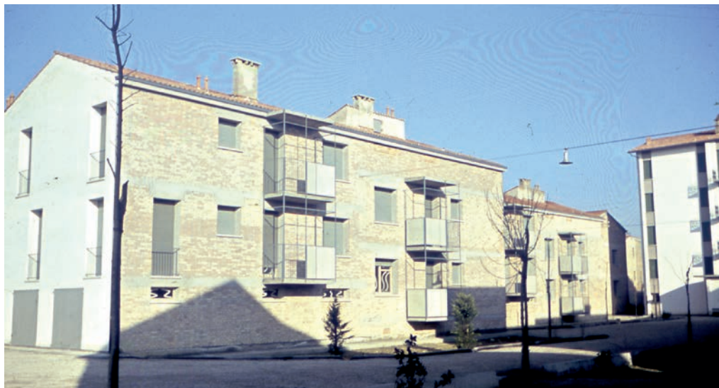
Fig.5-6 -Vedute del cantiere e degli edifici realizzati del quartiere INA Casa a San Giuliano di Mestre, Venezia, anni '50. Fotografie di E. R. Trincanato. © Università Luav di Venezia, Archivio Progetti, fondo Egle Renata Trincanato
