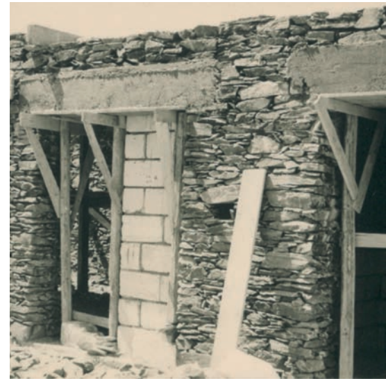
Fig.4 - La casa Di Palma in costruzione e il dettaglio di cantiere per la realizzazione degli architravi. Fotografia dell'epoca. CASVA, Milano. Archivio professionale architetto Fredi (Alfredo) Drugman
