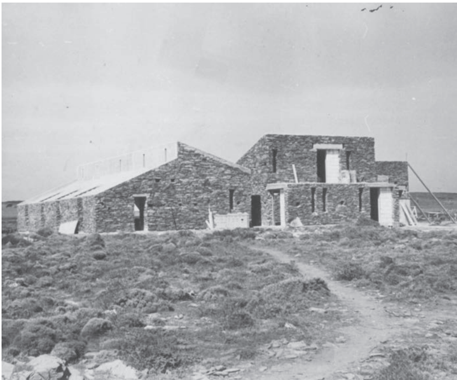
Fig.5 - Il cantiere della casa Di Palma e il contesto. CASVA, Milano. Archivio professionale architetto Fredi (Alfredo) Drugman
