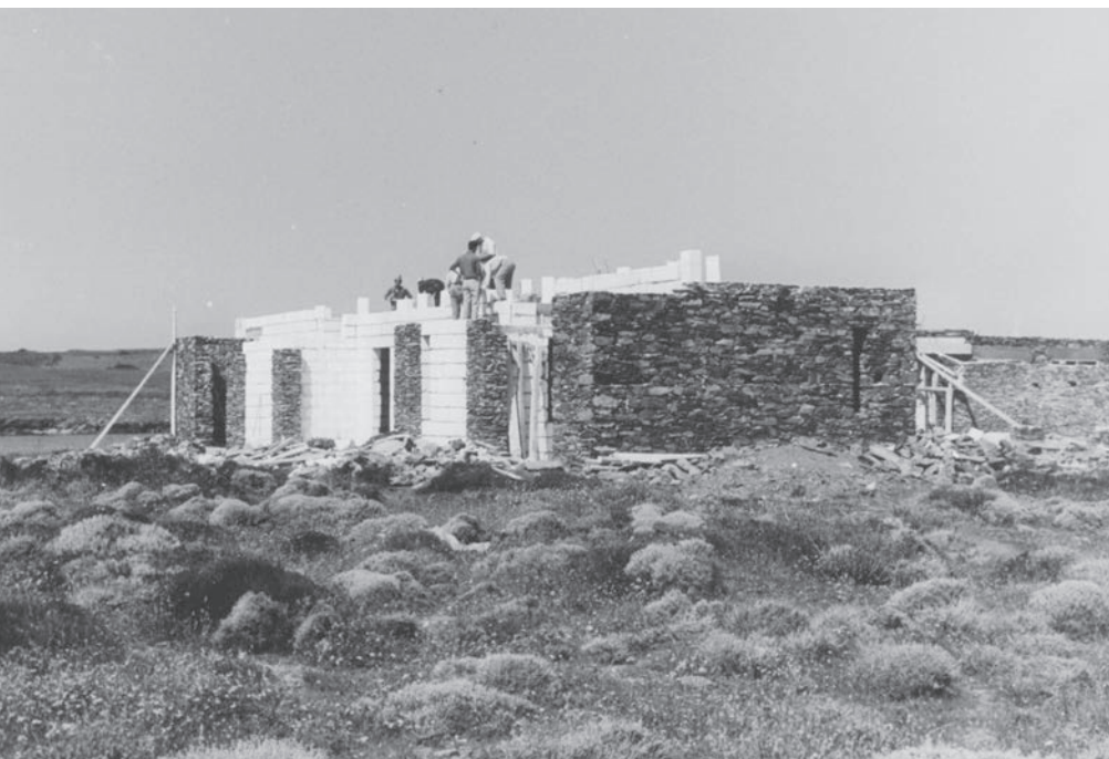
Fig.3 - La casa Di Palma in costruzione e i materiali del luogo: pietre scistose irregolari e blocchi di tufo squadrato.
