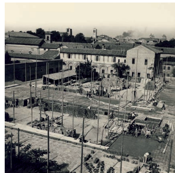
Fig.3 - Arcispedale sant'Anna, Padiglione oftalmico, realizzazione del solaio del piano rialzato, post luglio 1948 (FACS, racc. 1, foto 24)
