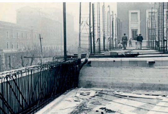
Fig.7 - Palazzo INA, armatura in acciaio di una trave, zona dell'atrio verso viale Cavour, V stato di avanzamento 3 feb. 1958 (FACS, racc. 7, foto 258)
