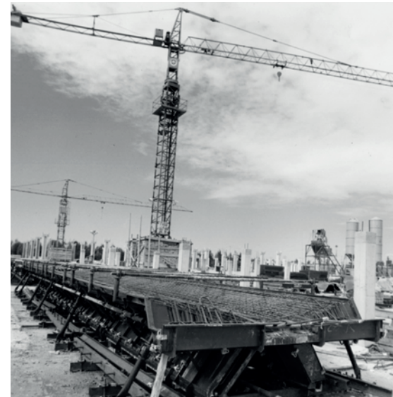
Fig.5 - Cantiere di prefabbricazione del coppone ad 'X' dello stabilimento Kodak a Marcianise. La complessità della cassaforma metallica, all'interno della quale sono posizionati i ferri dell'armatura ordinaria e i trefoli di pretensione, anticipa la realizzazione della scultorea forma dell'elemento strutturale (© Archivio privato Gigi Ghò, 1971)
