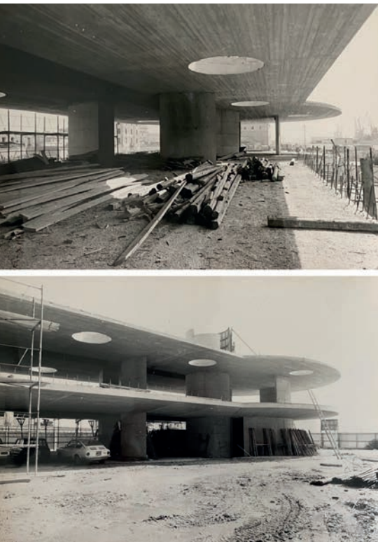
Fig.3 - Il 'ponte' con la costruzione degli impalcati con strutture in cemento trattate con casseri lignei (Archivio dell'Università degli Studi di Napoli Federico II, sez. Architettura e Ingegneria, Fondo A.L. Rossi, Impresa Salvatore Penta, 1978)
