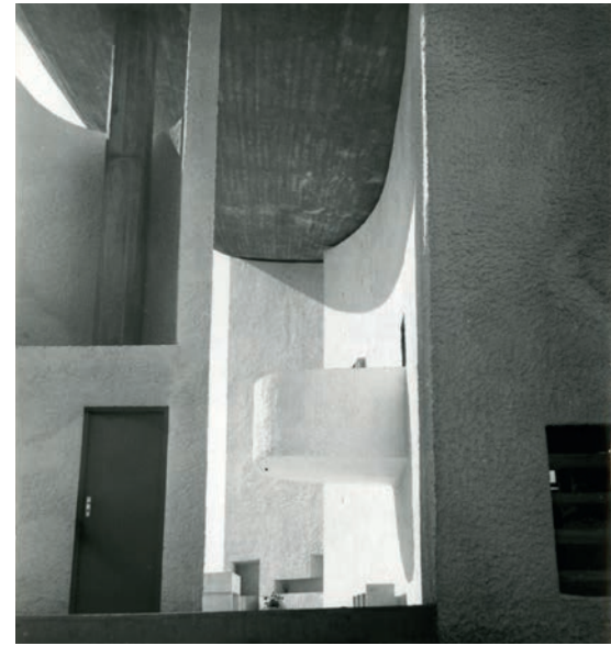
Fig.8 - Viaggio in Francia: Cappella di Notre-Dame du Haut di Le Corbusier a Ronchamp, Belfort, 1955. Fotografia di E. R. Trincanato. © Università Iuav di Venezia, Archivio Progetti, fondo Egle Renata Trincanato
