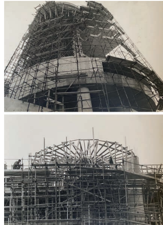
Fig.6 - La costruzione degli impalcati dell'elemento verticale prima dell'aggiunta dei curtain wall esterni e la presenza di complessi puntelli e ponteggi per la costruzione dei solai (Archivio dell'Università degli Studi di Napoli Federico II, sez. Architettura e Ingegneria, Fondo A.L. Rossi, Impresa Salvatore Penta, 1979)
