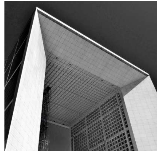
04 La Grande Arche a Parigi (J. Otto von Spreckelsen, 1984-89) è un cubo monumentale di circa 110 metri di lato, ricoperto di marmo di Carrara e Bardiglio. Foto dell'Autore
