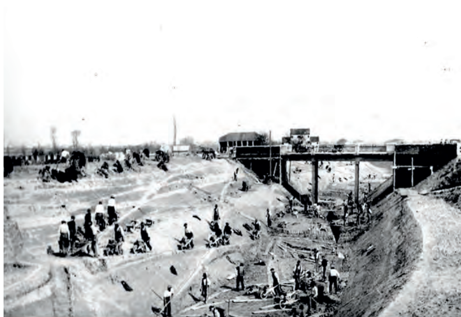
Fig. 1 - Lavori di costruzione di un canale di bonifica (1920, zona di Jolanda di Savoia).
