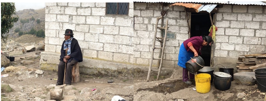
Case di blocchi di cemento che hanno sostituito la choza . Foto, Bosetti, 2016.
